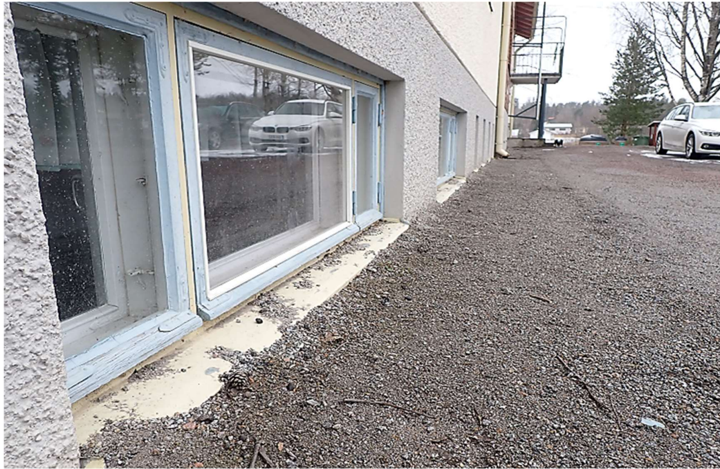
Kuva 6. Kellarikerroksen ikkunapellit ovat rakennuksen luoteen puoleisella seinustalla maanpinnan tasossa.
