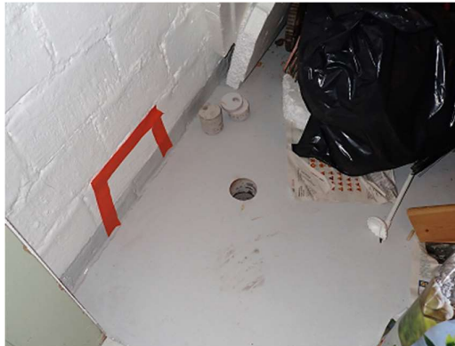
Kuvat 15 a ja b. Varaston 4 alapohjan rakennekerrokset avauksessa RA1. Bitumisivelyä otettiin materiaalinäyte PAH- ja asbestianalyysiin (AHA2: ei sisällä asbestia, PAH-pitoisuudet pieniä). Hiekkatäyttö on silmämääräisesti kostea.
