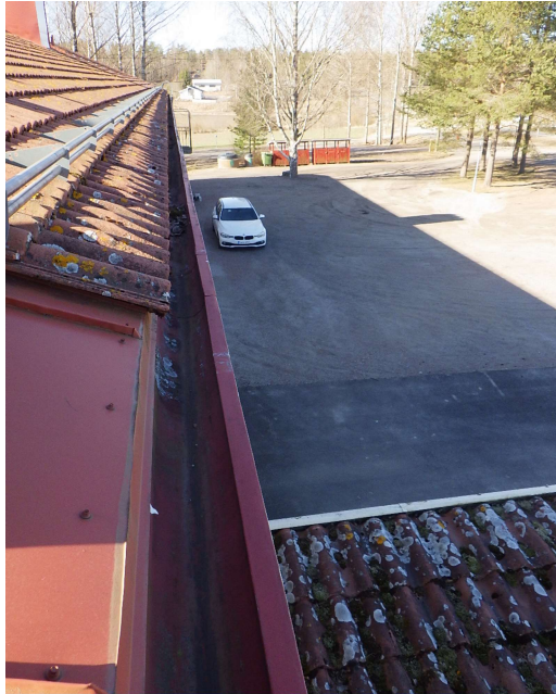
Kuvat 72 a ja b. Sadevesikourut ovat harjakaton osalla uudehkot ja puhtaat (kuva a). Pulpettikaton osalla sadevesikouruissa on runsaasti sammalta ja irtoainesta (kuva b).
