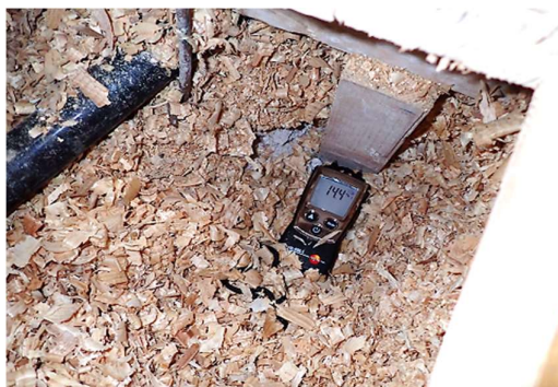
Kuvat 16 a...d. Liikuntasalin alapohjan rakennearaus RA2 kantavan väliseinän viereen. Kutteritäytön pohjalta otetussa materiaalinäytteessä MAT3 ei todettu mikrobikasvua. Täyttökerros on aistinvaraisesti arvioituna kuivaa. Täyttökerroksessa kulkee vesijohdot. Puurungon alaosan kosteuspuiteisuus on normaali (~ 14 paino-%). Alapohjan bitumisively on nostettu seinälle tiiliväliseinän alle (kuva d). Avauskohtaan tehdyn porareikämittauksen perusteella betonilaatassa on korkea kosteuspuiteisuus.
