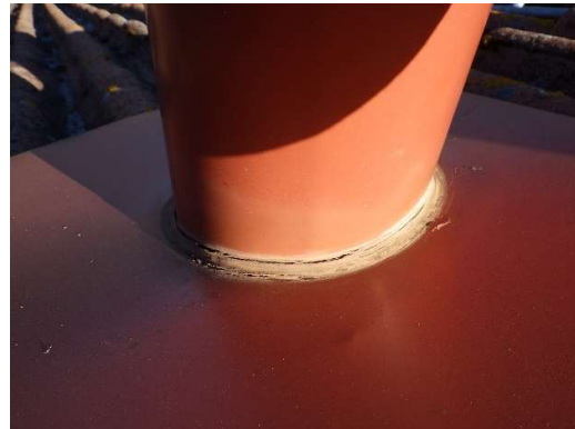
Kuvat 74 a...c. Tuuletusviemärien läpivienneissä on käytetty muovisia läpivientikappaleita sekä pellitystä ja elastista massausta. Läpivientien toteutuksessa ei havaittu puutteita.
