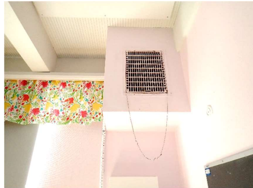
Kuvat 94 a ja b. Yleiskuva luokkatilojen ilmanvaihdosta. Ikkunaseinällä sijaitsevat Mobair-korvausilmalaite ja vanha painovoimaisen ilmanvaihdon hormi.
