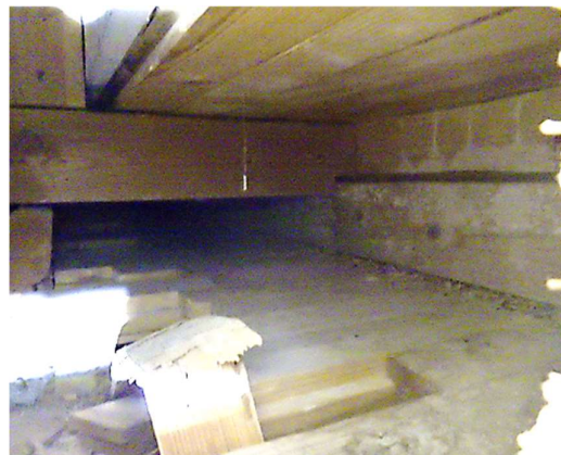
Kuvat 19 a ja b. Rakenneavaus RA4.2 liikuntasalin portaaseen. Portaan alustatilassa on tyhjä tila ja portaan puisia runkorakenteita. Alustatilassa ei tehty havaintoja poikkeavista hajuista tai merkkejä kosteusvaurioista avauksen kohdalla.
