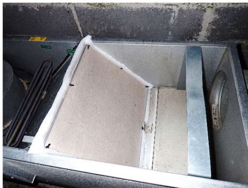
Kuvat 76 a ja b. Tuloilman suodatuksen suodatinkangas on likainen. Suodatinkankaan suodatusluokka ei ole tiedossa, mutta se on havaintojen ja kankaan paksuuden perusteella oletettavasti G3/G4 tai mahdollisesti M5.
