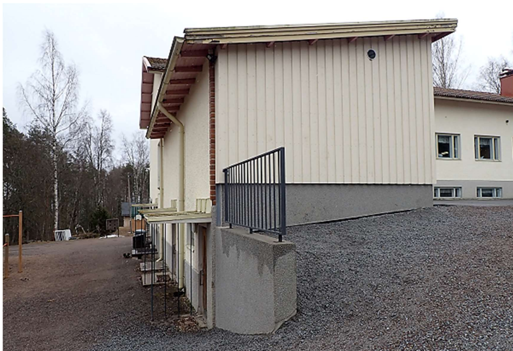
Kuva 7. Rakennus on loivasti koilliseen viettävässä rinteessä. Koillispäädyn vanha sisäänkäyntikatos on muutettu lämpimäksi tilaksi.
