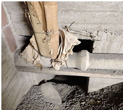
Kuvat 26 a ja b. Luoteen suuntaisen sivun putkikanaalin lähtöpiste on lounaspäädyn ryömintätilassa. Muita kanaalin tarkastelupisteitä ei tällä seinälinjalla havaittu. Lounaspäädyn portaan alustilassa on lahoavaa puuainesta ja muuta rakennusjätettä.
