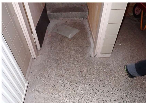
Kuvat 22 a...d. Koillispuolelisen kellaritilojen lattiapinnoissa havaittiin ikääntymisestä johtuvaa kulumista.
