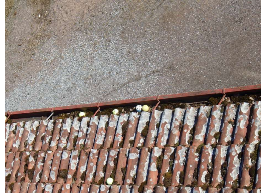
Kuvat 72 a ja b. Sadevesikourut ovat harjakaton osalla uudehkot ja puhtaat (kuva a). Pulpettikaton osalla sadevesikouruissa on runsaasti sammalta ja irtoainesta (kuva b).
