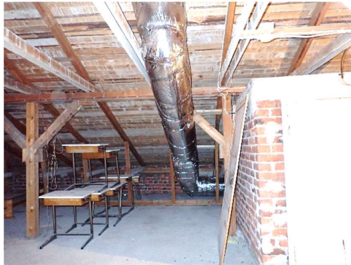
Kuvat 90 a ja b. Luokkatilojen poistoilma on toteutettu yhdistämällä painovoimaisen ilmanvaihdon hormit vesikatolla sijaitsevaan huippumuriin. Huippumurin teho-ohjainta ei havaittu tarkastelujen yhteydessä.
