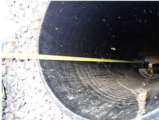
Kuvat 10 a ja b. Salaojaputken korkotaso arvioitiin yhteensä kolmesta salaojakaivosta. Salaojaputken korkotaso on arvion mukaan kellarin anturatasen yläpuolella.
