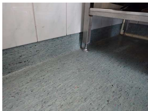
Kuvat 59 a...d. Alalaattapalkiston osalla välipohja-seinäliittymät ja läpiviennit ovat aistinvaraisesti ja merkisavun avulla tarkasteltuna epätiivitä. Ilmatiiviyys on hyvä keittiössä, jossa muovimatto on nostettu seinää vasten keraamisen laatoituksen taakse.
