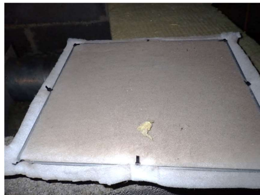
Kuvat 76 a ja b. Tuloilman suodatuksen suodatinkangas on likainen. Suodatinkankaan suodatusluokka ei ole tiedossa, mutta se on havaintojen ja kankaan paksuuden perusteella oletettavasti G3/G4 tai mahdollisesti M5.
