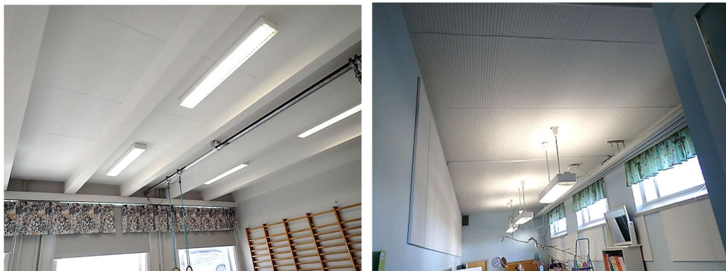
Kuvat 56 a ja b. Välipohjat ovat pääosin ylälaattapalkistoja tai teräsconilaattoja (luokkakäytävät).
