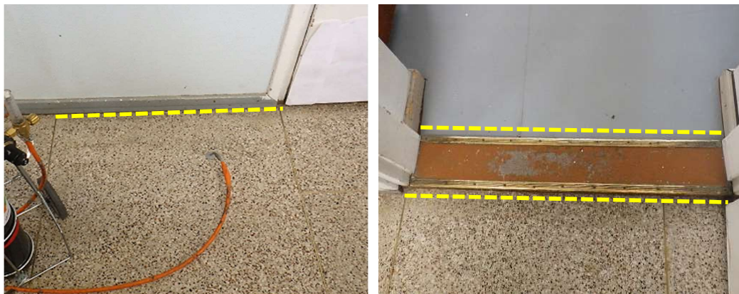
Kuvat 33 a ja b. Tarkekuvat kuvaan 30 merkkiainekokeen MA2 yhteydestä todetuista ilmavuotokohdista.
