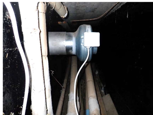
Kuvat 89 a ja b. Liikuntatilasta on yhteys putkikanaaliin. Putkikanaalissa on tyristori teho-ohjattu kanavapuhallin. Putkikanaaliin johtavan luukun havaittiin olevan merkkisavua apuna käyttäen epätiivis.
