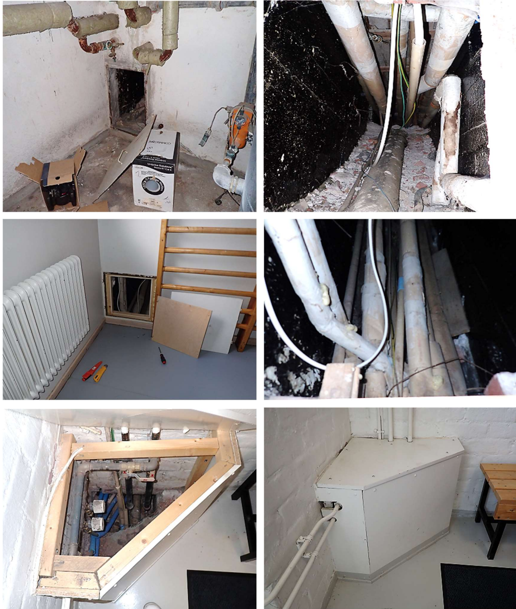
Kuvat 27 a...f. Havaintokuvia kaakon suuntaisen sivun putkikanaalista. Kanaalia pääsee tarkastelemaan alakellarin kattihuoneesta sekä liikuntasalista. Kellarivarastossa (varasto 6) on levyrakenteinen, silmämääräisesti epätiivis kotelointi, josta on suora ilmayhteys putkikanaaliin.
