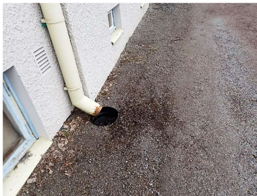
Kuvat 12 a ja b. Vesikatolta tulevat hulevedet ohjataan syöksytorvien alla sijaitseviin rännikaivoihin. Rännikaivojen sakkapesissä oli paikoin lehtiä ja kiviä. Salaojajärjestelmälle on piha-alueella useita tarkastuskaivoja (kuva b).
