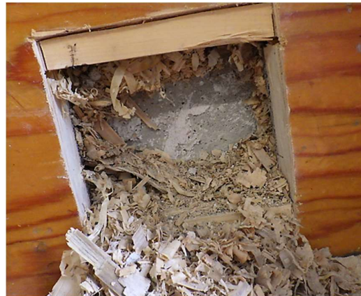
Kuvat 18 a ja b. Rakenneavaukset RA 4.1 ja RA4.2 liikuntasalin porraskäytäväalueeseen. Rakenneavauksessa RA4.1 havaittiin bitumikerros ja ohut kutterilastutäyttö. Avauksessa ei havaittu poikkeavia hajuja tai merkkejä kosteusvaurioista.
