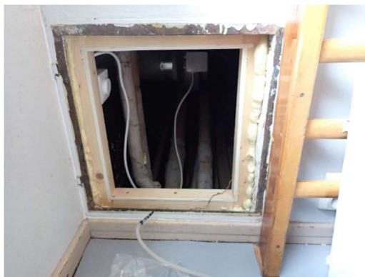
Kuvat 89 a ja b. Liikuntatilasta on yhteys putkikanaaliin. Putkikanaalissa on tyristori teho-ohjattu kanavapuhallin. Putkikanaaliin johtavan luukun havaittiin olevan merkkisavua apuna käyttäen epätiivis.
