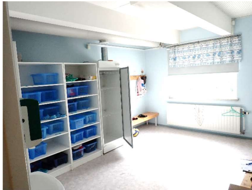
Kuvat 87 a ja b. Pohjakerroksen tilassa pukuhuone 1 on suoraan ulkoilmaan puhaltava kanavapuhallin. Puhaltimen teho-ohjainta ei havaittu.
