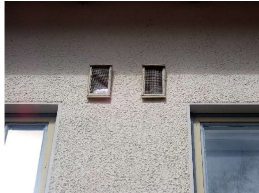
Kuvat 101 a ja b. Rakennuksen ulkoseinällä on useita korvausilma-aukkoja (merkattu punaisella), joiden toimivuutta ja merkitystä ei tarkasteluiden yhteydessä voitu todentaa korkean sijaintinsa vuoksi.
