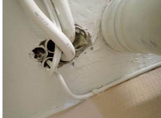
Kuvat 60 ja b. Myös ylä- ja massiivilaattavälipohjien osalla havaittiin epätiivitä läpivientejä. Ulkoseinien ja välipohjien liittymissä ei sen sijaan aistinvaraisella tarkastelulla havaittu ilmatiiveyspuutteita.
