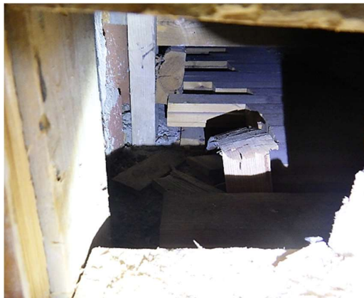
Kuvat 19 a ja b. Rakenneavaus RA4.2 liikuntasalin portaaseen. Portaan alustatilassa on tyhjä tila ja portaan puisia runkorakenteita. Alustatilassa ei tehty havaintoja poikkeavista hajuista tai merkkejä kosteusvaurioista avauksen kohdalla.
