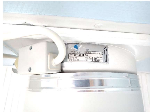
Kuvat 87 a ja b. Pohjakerroksen tilassa pukuhuone 1 on suoraan ulkoilmaan puhaltava kanavapuhallin. Puhaltimen teho-ohjainta ei havaittu.
