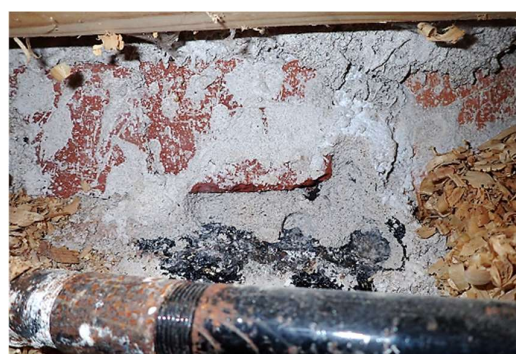
Kuvat 16 a...d. Liikuntasalin alapohjan rakennearaus RA2 kantavan väliseinän viereen. Kutteritäytön pohjalta otetussa materiaalinäytteessä MAT3 ei todettu mikrobikasvua. Täyttökerros on aistinvaraisesti arvioituna kuivaa. Täyttökerroksessa kulkee vesijohdot. Puurungon alaosan kosteuspuiteisuus on normaali (~ 14 paino-%). Alapohjan bitumisively on nostettu seinälle tiiliväliseinän alle (kuva d). Avauskohtaan tehdyn porareikämittauksen perusteella betonilaatassa on korkea kosteuspuiteisuus.
