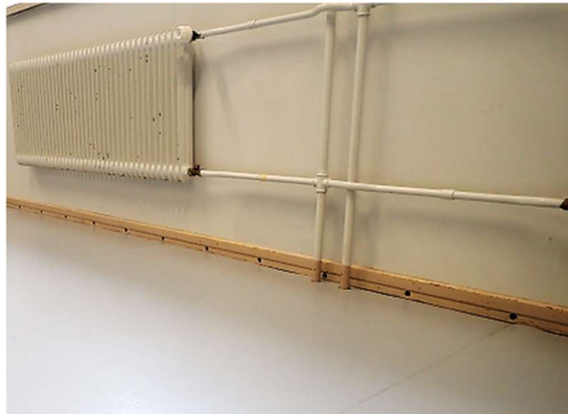
Kuvat 25 a ja b. Liikuntasalin jalkalistossa on kauttaaltaan tuuletusrakojen kautta suora ilmayhteys alapohjan kutteritöytäkerrokseen.
