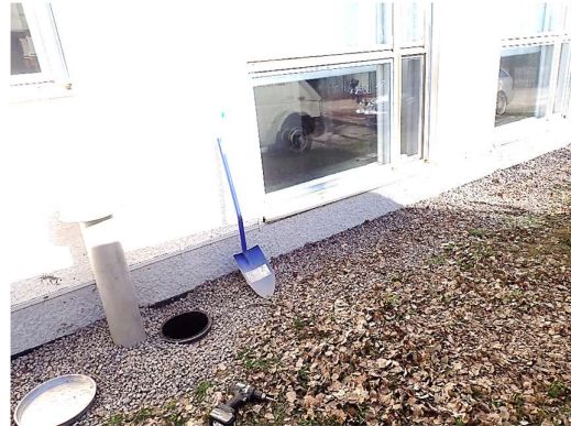
Kuvat 10 a ja b. Salaojaputken korkotaso arvioitiin yhteensä kolmesta salaojakaivosta. Salaojaputken korkotaso on arvion mukaan kellarin anturatasen yläpuolella.
