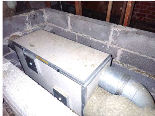
Kuvat 75 a ja b. Fläkt Group Oy:n valmistama iv-kone sijaitsee eristetyssä tilassa rakennuksen ullakolla. Konemalli on ns. kylmän tilan iv-kone, jossa on normaalia parempi eristys. Poistoilmakanava on osin eristämättä.
