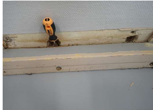
Kuvat 25 a ja b. Liikuntasalin jalkalistossa on kauttaaltaan tuuletusrakojen kautta suora ilmayhteys alapohjan kutteritöytäkerrokseen.
