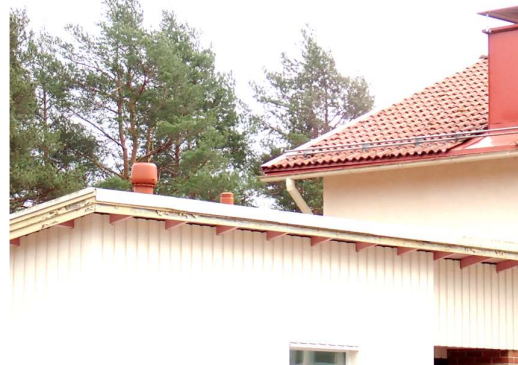
Kuvat 90 a ja b. Luokkatilojen poistoilma on toteutettu yhdistämällä painovoimaisen ilmanvaihdon hormit vesikatolla sijaitsevaan huippumuriin. Huippumurin teho-ohjainta ei havaittu tarkastelujen yhteydessä.
