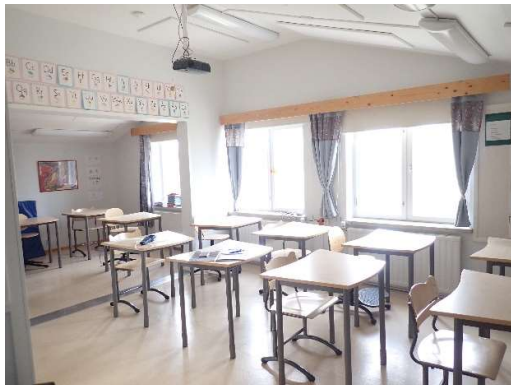
Kuvat 95 a ja b. Toisen kerroksen luokkatilan huuhtelu ei havaintojen perusteella ole optimaalinen. Tuloilmapäätelaitteiden ilmavirtaus ei suuntaudu tehokkaasti oleskeluvyöhykkeelle. Tarkasteluhetkellä tilassa oli myös ummehtunut haju ja samassa yhteydessä havaittiin, ettei tuloilmapäätelaitteista tule huonetilaan korvausilmaa, mikä myös todennettiin paine-eromittauksella (paine-eromittaus päätelaitteelta oli 0 Pa). Puhaltimien testauksen perusteella iv-koneen molemmat puhaltimet pyörivät ja olivat toimivia. Tuloilmakanavassa havaittiin olevan äänenvaimennin, jonka vaimennusmateriaalia ei voitu todentaa.
