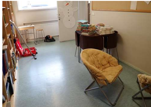
Kuvat 21 a...d. Kellarin lattiapinnoissa ei havaittu merkittäviä vaurioita tai ikääntymisestä johtuvaa kulumista. Lattiat on maalattu vuonna 2014. Yksittäisissä kellarin tiloissa on muovimattopäällyste.
