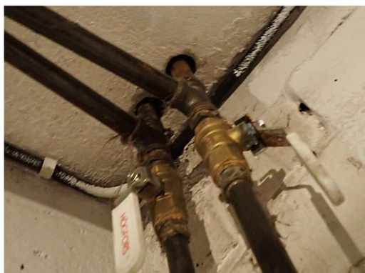
Kuvat 60 ja b. Myös ylä- ja massiivilaattavälipohjien osalla havaittiin epätiivitä läpivientejä. Ulkoseinien ja välipohjien liittymissä ei sen sijaan aistinvaraisella tarkastelulla havaittu ilmatiiveyspuutteita.
