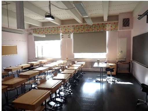
Kuvat 94 a ja b. Yleiskuva luokkatilojen ilmanvaihdosta. Ikkunaseinällä sijaitsevat Mobair-korvausilmalaite ja vanha painovoimaisen ilmanvaihdon hormi.
