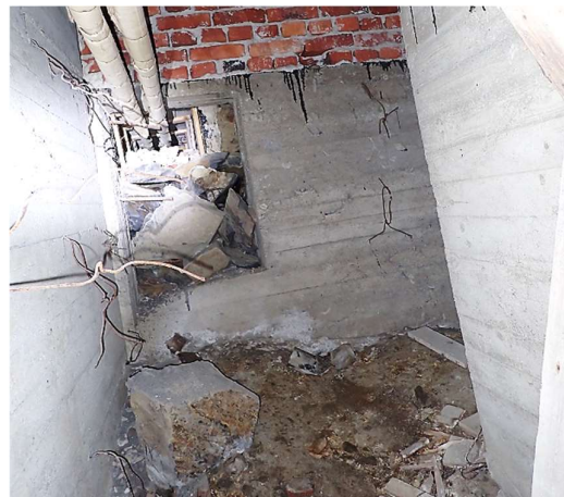
Kuvat 26 a ja b. Luoteen suuntaisen sivun putkikanaalin lähtöpiste on lounaspäädyn ryömintätilassa. Muita kanaalin tarkastelupisteitä ei tällä seinälinjalla havaittu. Lounaspäädyn portaan alustilassa on lahoavaa puuainesta ja muuta rakennusjätettä.
