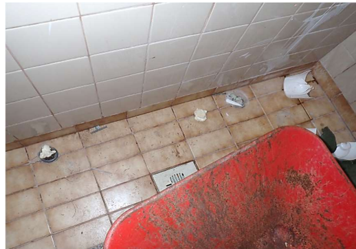
Kuvat 22 a...d. Koillispuolelisen kellaritilojen lattiapinnoissa havaittiin ikääntymisestä johtuvaa kulumista.
