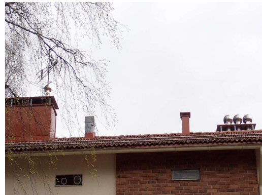
Kuvat 102 a ja b. Osa painovoimaisista hormeista on lähtötietojen ja havaintojen perusteella yhdistetty tuulen voimalla toimiviin ja vesikatolla sijaitseviin Turbovent-vedonparantajiin.
