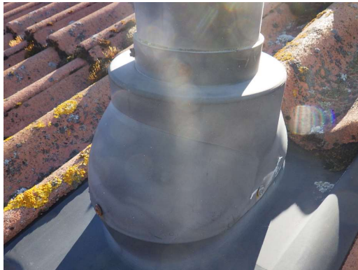
Kuvat 74 a...c. Tuuletusviemärien läpivienneissä on käytetty muovisia läpivientikappaleita sekä pellitystä ja elastista massausta. Läpivientien toteutuksessa ei havaittu puutteita.
