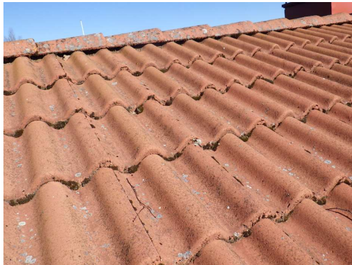
Kuvat 71 a...c. Kattotyyppi on pääosin harjakatto. Vanhan sisäänkäyntikatoksen osalta kattotyyppi on pulpettikatto (kuva c). Kattotiilet ovat pääosin hyväkuntoisia. Katon harjan pohjoispuolella on jonkin verran sammalta.
