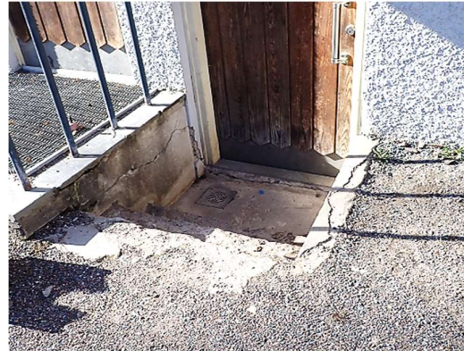
Kuvat 11 a ja b. Koillispäädyn alakellarin sisäänkäynnin edustalle lammikoituu vettä sadesäällä. Sadevesikaivo oli tukkeutunut runsaasta määrästä lehtiä. Sisäänkäynnin betoniset tukimuurit ovat halkeilleet voimakkaasti.
