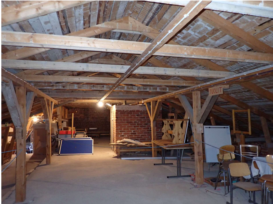
Kuva 66. Yleiskuva vesikaton tuuletustilasta. Rakenteissa ei silmämääräisesti havaittu merkkejä materiaalien laaja-alaisesta vaurioitumisesta. Ullakolla säilytetään irtaimistoa, mm. pulpetteja.
