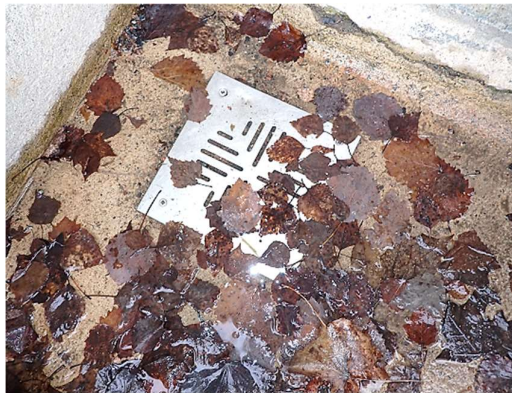
Kuvat 11 a ja b. Koillispäädyn alakellarin sisäänkäynnin edustalle lammikoituu vettä sadesäällä. Sadevesikaivo oli tukkeutunut runsaasta määrästä lehtiä. Sisäänkäynnin betoniset tukimuurit ovat halkeilleet voimakkaasti.
