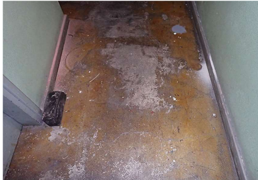
Kuvat 21 a...d. Kellarin lattiapinnoissa ei havaittu merkittäviä vaurioita tai ikääntymisestä johtuvaa kulumista. Lattiat on maalattu vuonna 2014. Yksittäisissä kellarin tiloissa on muovimattopäällyste.
