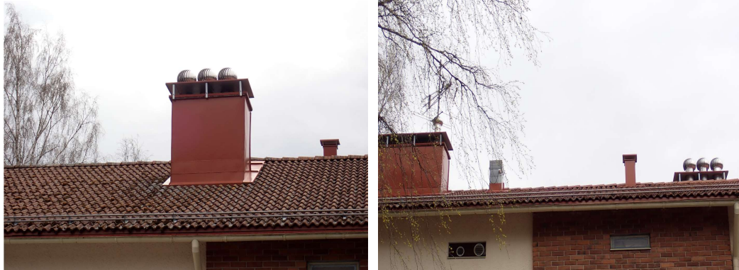
Kuvat 92 a ja b. Osa painovoimaisista hormeista on lähtötietojen ja havaintojen perusteella yhdistetty tuulen voimalla toimiviin ja vesikatolla sijaitseviin Turbovent-vedonpantajiin.
