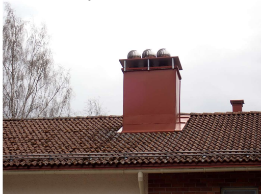
Kuvat 102 a ja b. Osa painovoimaisista hormeista on lähtötietojen ja havaintojen perusteella yhdistetty tuulen voimalla toimiviin ja vesikatolla sijaitseviin Turbovent-vedonparantajiin.
