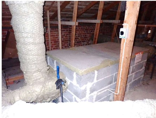
Kuvat 75 a ja b. Fläkt Group Oy:n valmistama iv-kone sijaitsee eristetyssä tilassa rakennuksen ullakolla. Konemalli on ns. kylmän tilan iv-kone, jossa on normaalia parempi eristys. Poistoilmakanava on osin eristämättä.
