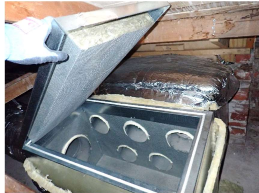
Kuvat 90 a ja b. Luokkatilojen poistoilma on toteutettu yhdistämällä painovoimaisen ilmanvaihdon hormit vesikatolla sijaitsevaan huippumuriin. Huippumurin teho-ohjainta ei havaittu tarkastelujen yhteydessä.
