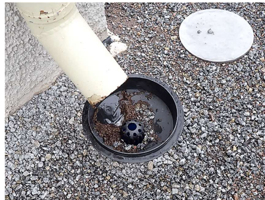
Kuvat 12 a ja b. Vesikatolta tulevat hulevedet ohjataan syöksytorvien alla sijaitseviin rännikaivoihin. Rännikaivojen sakkapesissä oli paikoin lehtiä ja kiviä. Salaojajärjestelmälle on piha-alueella useita tarkastuskaivoja (kuva b).
