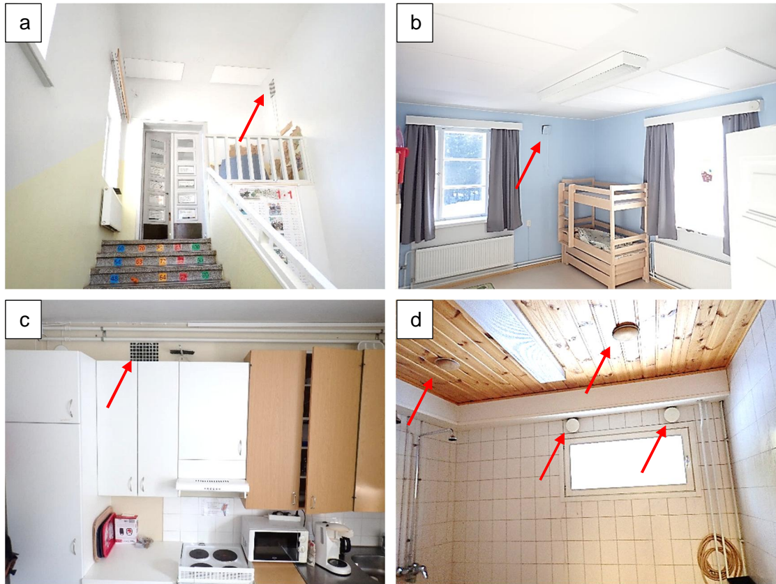
Kuvat 109 a...d. Yleiskuvia rakennuksen eri tilojen ilmanvaihdosta. Punaisilla nuolilla on osoitettu korvausilma-aukkoja ja poistoilmahormeja ja poistoilmaventtiileitä.
