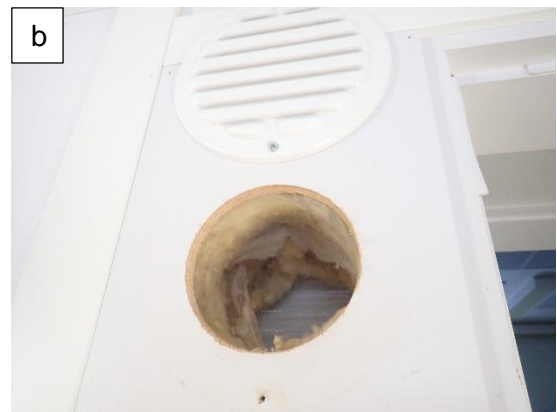
Kuvat 107 a...b. Yleiskuva opetustilan ilmanvaihdosta. Luokissa on -1-2 ilmahormia, jotka ovat suunniteltu poistoilmahormeiksi sekä ovissa siirtoilmäsäleikkö, jonka äänieriste on suojaamaton mineraalivilla. Osassa opetustiloja on ulkoilmaan johtavia korvausilma-aukkoja. Tarkasteluhetkellä, kun ilmanvaihtolaitteet olivat pois päältä, ilmavirtaukset olivat merkittävästi havainnoituna ilmahormeihin päin. Ilmanvaihtolaitteiden ollessa päällä, kääntyi ilmavirtaukset joistain ilmahormeista sisäilmaan päin (kaikkia hormoneja ei tarkasteltu).
