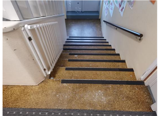
Kuvat 76 a...b. Porrashuoneiden lattioissa on alkuperäinen mosaiikkibetoni, joka on osin pinnoitettu (kuva b). Pinnoite on monin paikoin kulunut.
