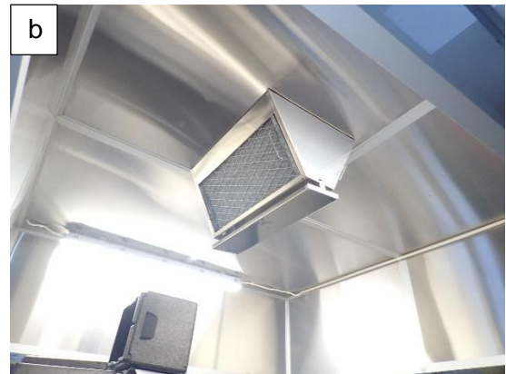
Kuvat 106 a... b. Yleiskuvia keittiön ilmanvaihdosta. Tuloilma johdetaan tilaan neljän KTS-125 -tuloilmaventtiin kautta (punainen nuoli). Keittiön rasvahuuva on yhdistetty ilmanvaihtokoneen poistoilmaan.
