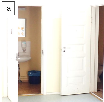
Kuvat 108 a...b. Ensimmäisen kerroksen keskiosan WC-tilojen poisto on toteutettu kanavapuhaltimen avulla. Tilojen oviaukoissa ei ole ovirakoa tai tilaan johtavaa korvausilmareittiä. Kanavapuhallin on huomattavan vanha ja siinä havaittiin voimakas laakerivaurioon viittaa sivuääni.
