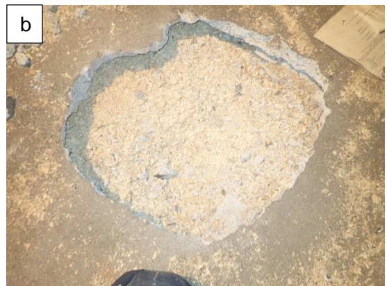
Kuvat 90 a...b. Eteläpäädyssä yläpohjan eristeet on vaihdettu puhallusvillaeristeeseen (a) ja muualla työ on jäänyt kesken. Palopermannon yläpinnassa on kaikkialla PAH-yhdistepitoinen (PAH (16) = 23 800 mg/kg)) bitumisively (Haitta-ainetutkimus, Vahanen Rakennusfysiikka Oy, 31.3.2021). Myös palopermantoa vasten olevien puurakenteiden bitumisively on PAH-yhdistepitoinen (PAH (16) = 50 200 mg/kg)).
