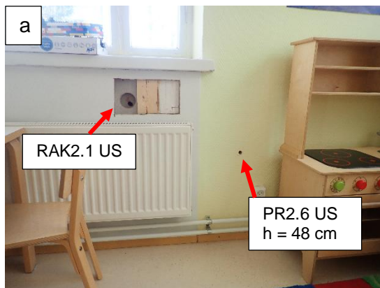
Kuvat 65 a...b. Rakenneavaukset RAK2.1 US ja PR2.6 US eteläpäädyn ulkoseinään 2.kerrokseen. Porauksessa PR2.6 US havaittiin noin 100 mm:n ilmaväli noin 280 mm syvyydessä, muilta osin rakenne on täystiilinen. Ikkunan alapuolella ollut patterisyvennyksen on ummistettu puukoolauksella ja vanerilevyllä. Lisäksi syvennykseen on liimattu uretaanivaahdolla 50 mm EPS-eristelevy, jonka takana, ennen alkuperäistä pintaa on noin 25 mm ilmaväli. Ulkoseinärakenteen kokonaispaksuus on noin 500 mm. Porauksesta PR2.6 todettiin voimakasta ilmavirtausta sisään päin. Poikkeavaa hajua avauksissa ei havaittu.
