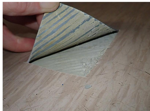
Kuva 39. V1: Selvää kemikaalimaista hajua muovimaton tartunta alustaansa heikko. Liimassa värimuutoksia.
