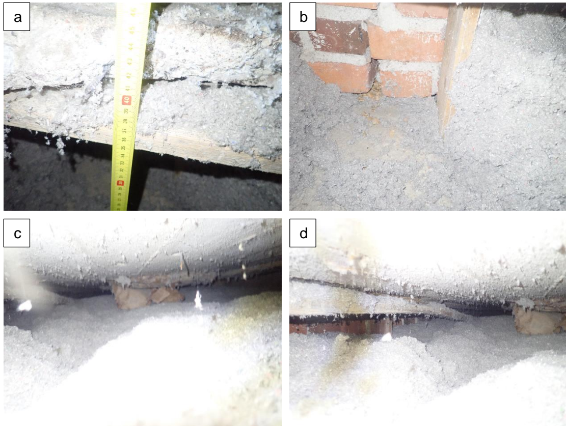
Kuvat 100 a...d. Eteläpäädyn yläpohjan eristetilaan suoritettiin rakennetarkastus RAK2.8 YP poistamalla puhallusvillaeristettä auki olevasta palopermannon aukosta. Alalaattapalkiston päällä oleva tila on 350 mm korkea. Eristettä yläpohjassa on noin 250 mm. Rakenteesta ei ole korjaustöiden yhteydessä saatu poistettua kaikkea alkuperäistä kutterilastueristettä eikä muottilautoja. Palopermannon paksuus vaihtelee välillä 60–80 mm. Rakenteesta ei havaittu poikkeavaa hajua.
