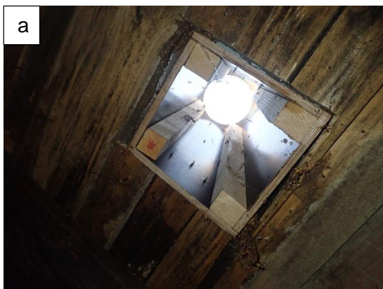
Kuvat 91 a...b. Ullakotila tuulettuu vesikaton harjatuuletusventtiilien kautta. Vanhan aluslaudoituksen päällä näkyy vanha bitumikermi aluskatteena (kuva a). Paikoin rakenteessa on tervapahvi (kuva b).
