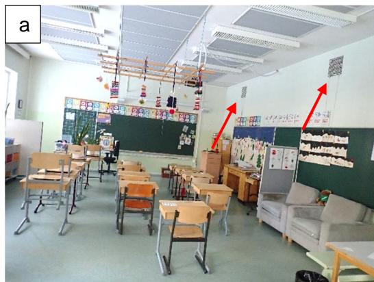
Kuvat 107 a...b. Yleiskuva opetustilan ilmanvaihdosta. Luokissa on -1-2 ilmahormia, jotka ovat suunniteltu poistoilmahormeiksi sekä ovissa siirtoilmäsäleikkö, jonka äänieriste on suojaamaton mineraalivilla. Osassa opetustiloja on ulkoilmaan johtavia korvausilma-aukkoja. Tarkasteluhetkellä, kun ilmanvaihtolaitteet olivat pois päältä, ilmavirtaukset olivat merkittävästi havainnoituna ilmahormeihin päin. Ilmanvaihtolaitteiden ollessa päällä, kääntyi ilmavirtaukset joistain ilmahormeista sisäilmaan päin (kaikkia hormoneja ei tarkasteltu).
