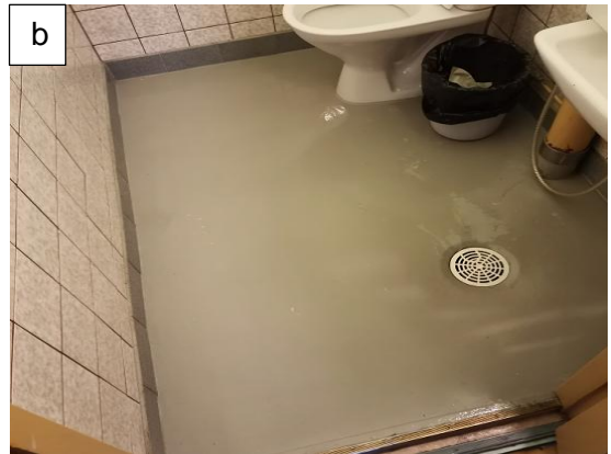
Kuvat 76 a...b. Porrashuoneiden lattioissa on alkuperäinen mosaiikkibetoni, joka on osin pinnoitettu (kuva b). Pinnoite on monin paikoin kulunut.
