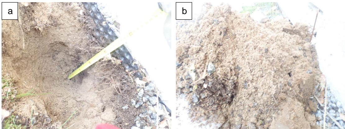
Kuvat 8 a...b. Koekuoppa 2, alkuperäisen osan länsipuolelle. Kaivussyvyys noin 500 mm, vierustäyttö on hienorakeista hiekkaa. Pinnassa on ohut kerros Ø16 mm sepeliä ja multaa. Lämmöneristeitä ei havaittu.
