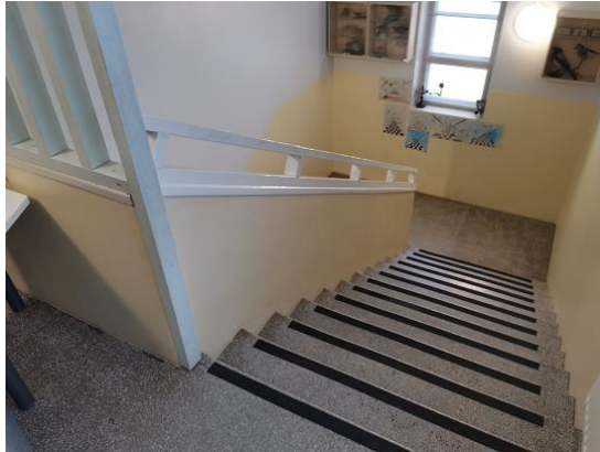
Kuvat 76 a...b. Porrashuoneiden lattioissa on alkuperäinen mosaiikkibetoni, joka on osin pinnoitettu (kuva b). Pinnoite on monin paikoin kulunut.
