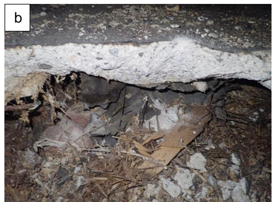
Kuvat 91 a...b. Ullakotila tuulettuu vesikaton harjatuuletusventtiilien kautta. Vanhan aluslaudoituksen päällä näkyy vanha bitumikermi aluskatteena (kuva a). Paikoin rakenteessa on tervapahvi (kuva b).
