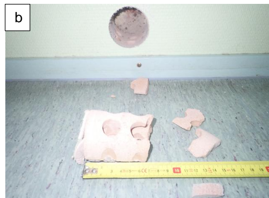
Kuva 60. Rakenneavaukset PR1.3...1.5 US eteläpäätyyn 1.kerrokseen. Porauksessa PR1.3 US havaittiin noin 100 mm:n ilmapäli noin 280 mm syvyydessä, muilta osin rakenne on täystiilinen. Ikkunan alapuolissa porauksissa todettiin vanhan patterisyyvennyksen olevan muurattu umpeen kevytsoraharkoilla. Ulkoseinärakenteen kokonaispaksuus on noin 500 mm. Avauksesta PR1.3 US todettiin voimakasta ilmavirtausta sisään päin. Poikkeavaa hajua avauksista ei havaittu.
