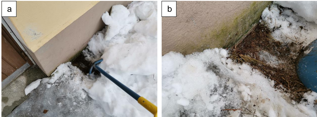
Kuvat 10 a...b. Koekuoppa 3, laajennusosan pohjoispuoli. Maanpinta oli tutkimushetkellä jäässä, joten koekuoppaa ei saatu kaivettua. Vedeneristettä ei havaittu.
