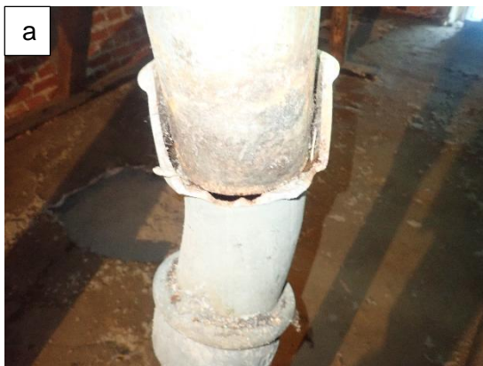
Kuvat 93 a...b. Yläpohjatilassa olevan viemärituuletusputken muhvi on iso lohkeama (kuva a) Yläpohjan puurakenteet todettiin pistokoeluontoisilla piikkimittauksilla kuiviksi (kuva b).
