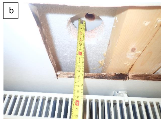
Kuvat 65 a...b. Rakenneavaukset RAK2.1 US ja PR2.6 US eteläpäädyn ulkoseinään 2.kerrokseen. Porauksessa PR2.6 US havaittiin noin 100 mm:n ilmaväli noin 280 mm syvyydessä, muilta osin rakenne on täystiilinen. Ikkunan alapuolella ollut patterisyvennyksen on ummistettu puukoolauksella ja vanerilevyllä. Lisäksi syvennykseen on liimattu uretaanivaahdolla 50 mm EPS-eristelevy, jonka takana, ennen alkuperäistä pintaa on noin 25 mm ilmaväli. Ulkoseinärakenteen kokonaispaksuus on noin 500 mm. Porauksesta PR2.6 todettiin voimakasta ilmavirtausta sisään päin. Poikkeavaa hajua avauksissa ei havaittu.
