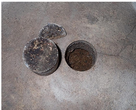
Kuva 30. Rakenneavaus RAK0.1 AP kellarikerroksen varaston maanvastaiseen alapohjaan. Haitta-ainetutkimuksen (Vahanen Rakennusfysiikka Oy, 31.3.2021) materiaalinäytteen mukaan bitumisively on PAH-yhdistepitoinen ( PAH(16)=32000 mg/kg). Avauksen yhteydessä ei havaittu poikkeavaa hajua.
