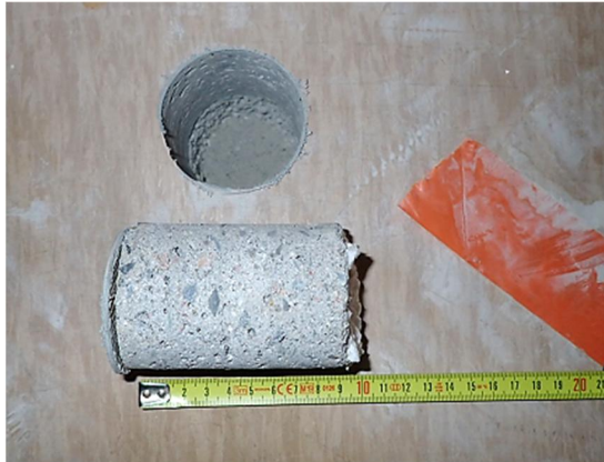
Kuva 37. Rakenneavaus RAK1.3 AP pukuhuoneen PKH/N maanvastaiseen alapohjaan. Rakenneavauksessa ei todettu poikkeavia hajuja tai merkkejä vaurioista.
