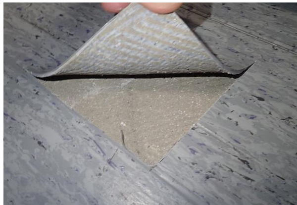
Kuva 84. V3: Lievää kemikaalimaista hajua ja muovimaton tartunta alustaansa kohtalainen.
