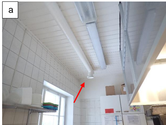
Kuvat 106 a... b. Yleiskuvia keittiön ilmanvaihdosta. Tuloilma johdetaan tilaan neljän KTS-125 -tuloilmaventtiin kautta (punainen nuoli). Keittiön rasvahuuva on yhdistetty ilmanvaihtokoneen poistoilmaan.
