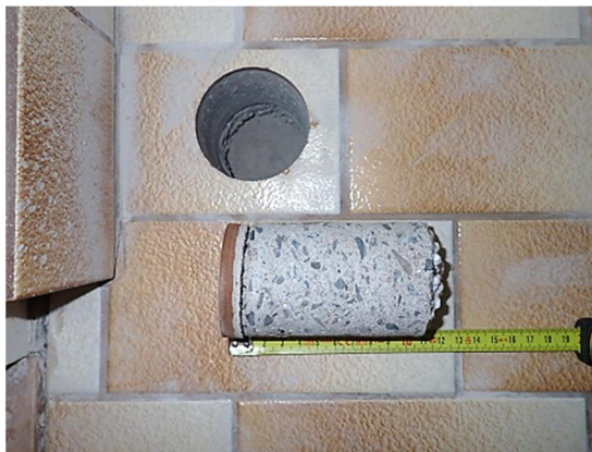
Kuva 38. Rakenneavaus RAK1.4 AP WC-tilan maanvastaiseen alapohjaan. Rakenneavauksessa ei todettu poikkeavia hajuja tai merkkejä vaurioista.
