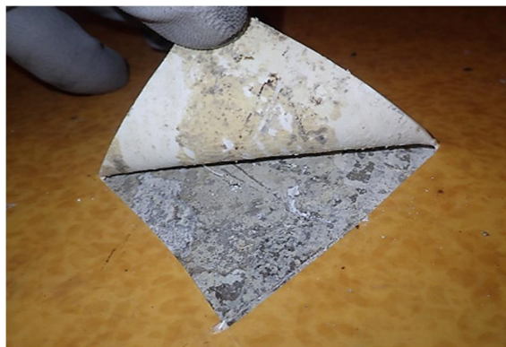
Kuva 39. V1: Selvää kemikaalimaista hajua muovimaton tartunta alustaansa heikko. Liimassa värimuutoksia.
