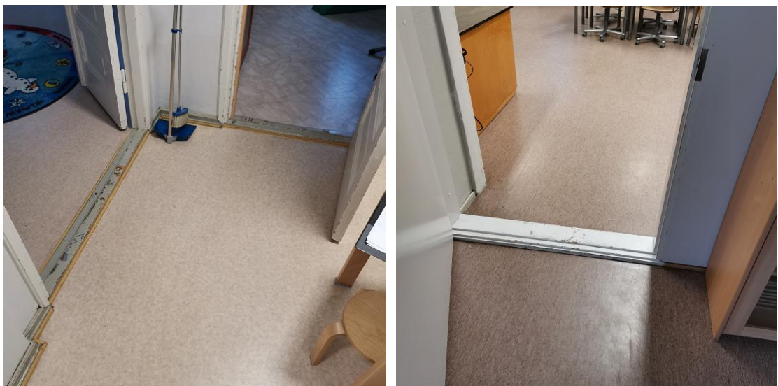
Kuvat 75 a... b. Välipohjien lattiapäällysteenä on erilaisia muovimattoja. Päällysteet ovat ikääntyneitä mutta yhä siistikuntoisia.
