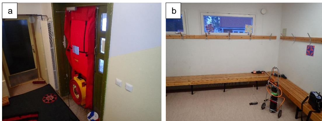
Kuvat 42 a...b. Merkkiainekokeen MA1 AP mittaussjärjestelyt. Tila alipaineistettiin Retrotec-puhaltimen avulla noin 10 Pa alipaineiseksi alapohjarakenteen eristetilaan nähden.
