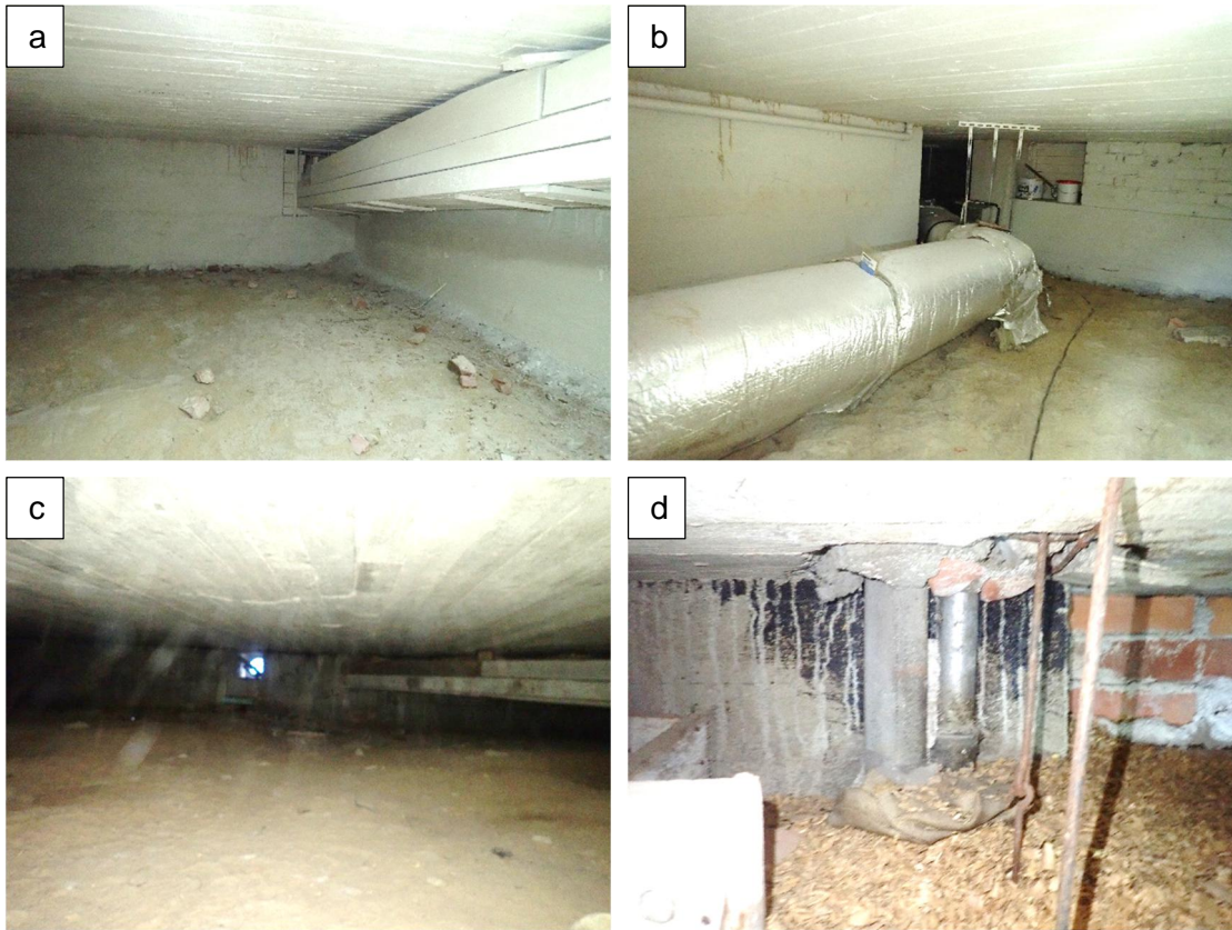
Kuvat 112 a...d. Yleiskuvia kellarikerroksen ryömintätiloista.
