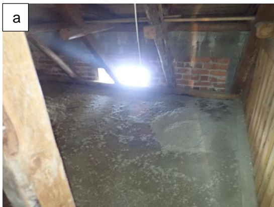
Kuvat 90 a...b. Eteläpäädyssä yläpohjan eristeet on vaihdettu puhallusvillaeristeeseen (a) ja muualla työ on jäänyt kesken. Palopermannon yläpinnassa on kaikkialla PAH-yhdistepitoinen (PAH (16) = 23 800 mg/kg)) bitumisively (Haitta-ainetutkimus, Vahanen Rakennusfysiikka Oy, 31.3.2021). Myös palopermantoa vasten olevien puurakenteiden bitumisively on PAH-yhdistepitoinen (PAH (16) = 50 200 mg/kg)).
