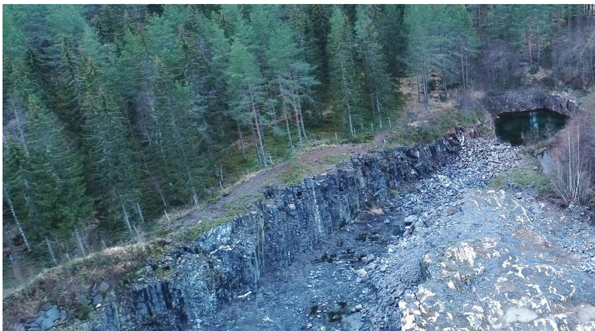
Kuva 8. Louhoksen kallioleikkaukset on ympäröity hirviaidalla.
