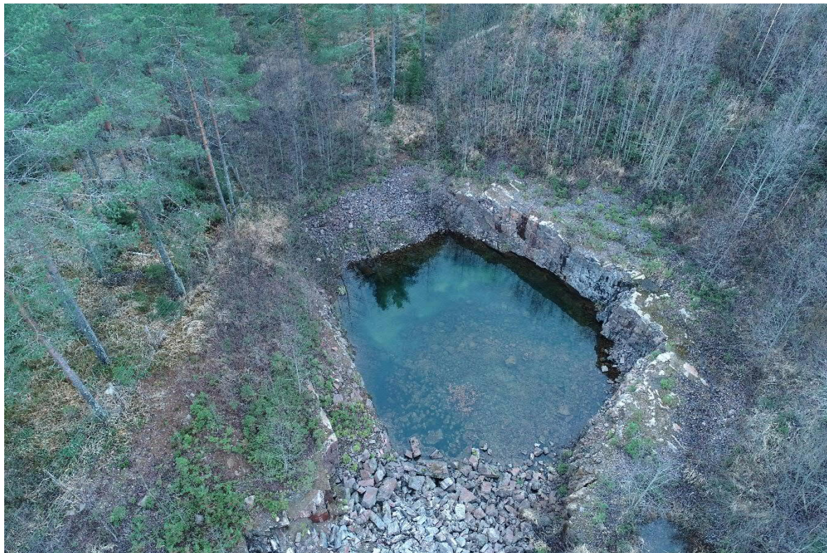
Kuva 7. Alueen länsinurkan hulevesien selkeytysallas.
