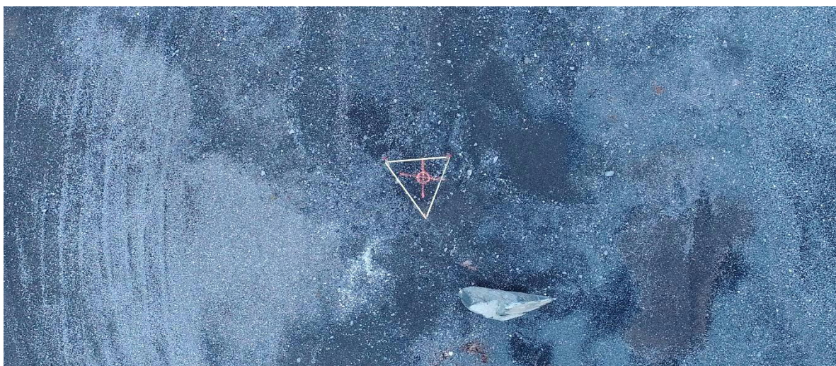
Kuva 3. Alueen keskivaiheilla on korkopukki louhinnan ja kentän tasauksen korkeusasemien hallintaa varten.
