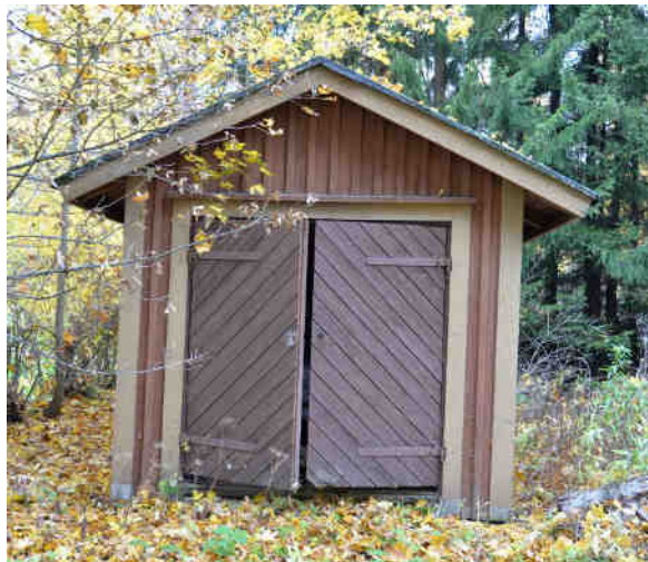
Kuvat: Kellari ja autotalli, jotka sijaitsevat samassa rivissä ulkorakennusten kanssa.
