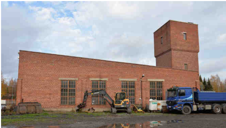
Kuvat: Veturitalli etelästä ja radan puolelta luoteesta sekä kaakkoissivu.
