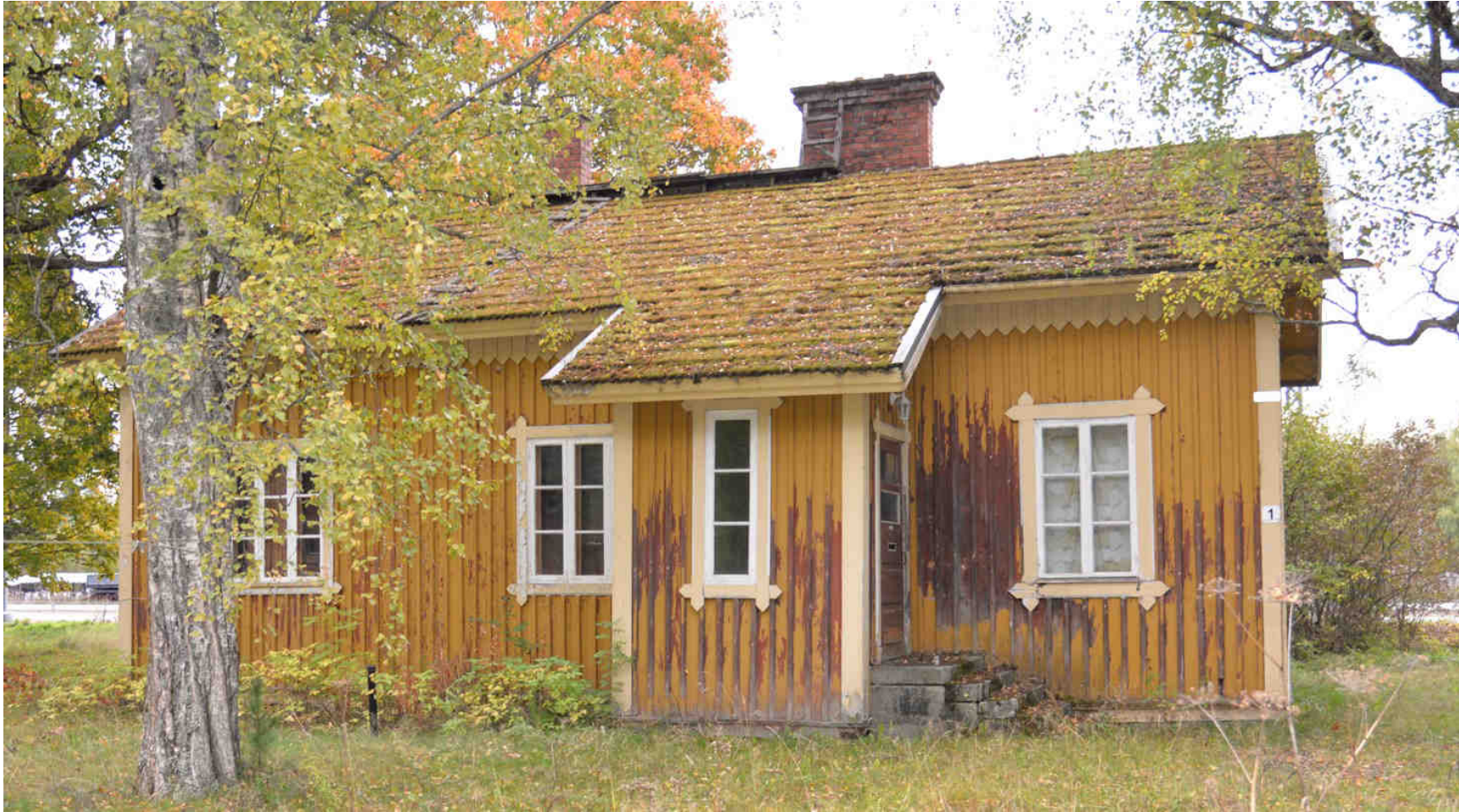
Kuvat: Pieni asuinrakennus on säilyttänyt kattoa ja ovia lukuun ottamatta lähes alkuperäisen asunsa 1900-luvun alun laajennuksen jälkeen.
