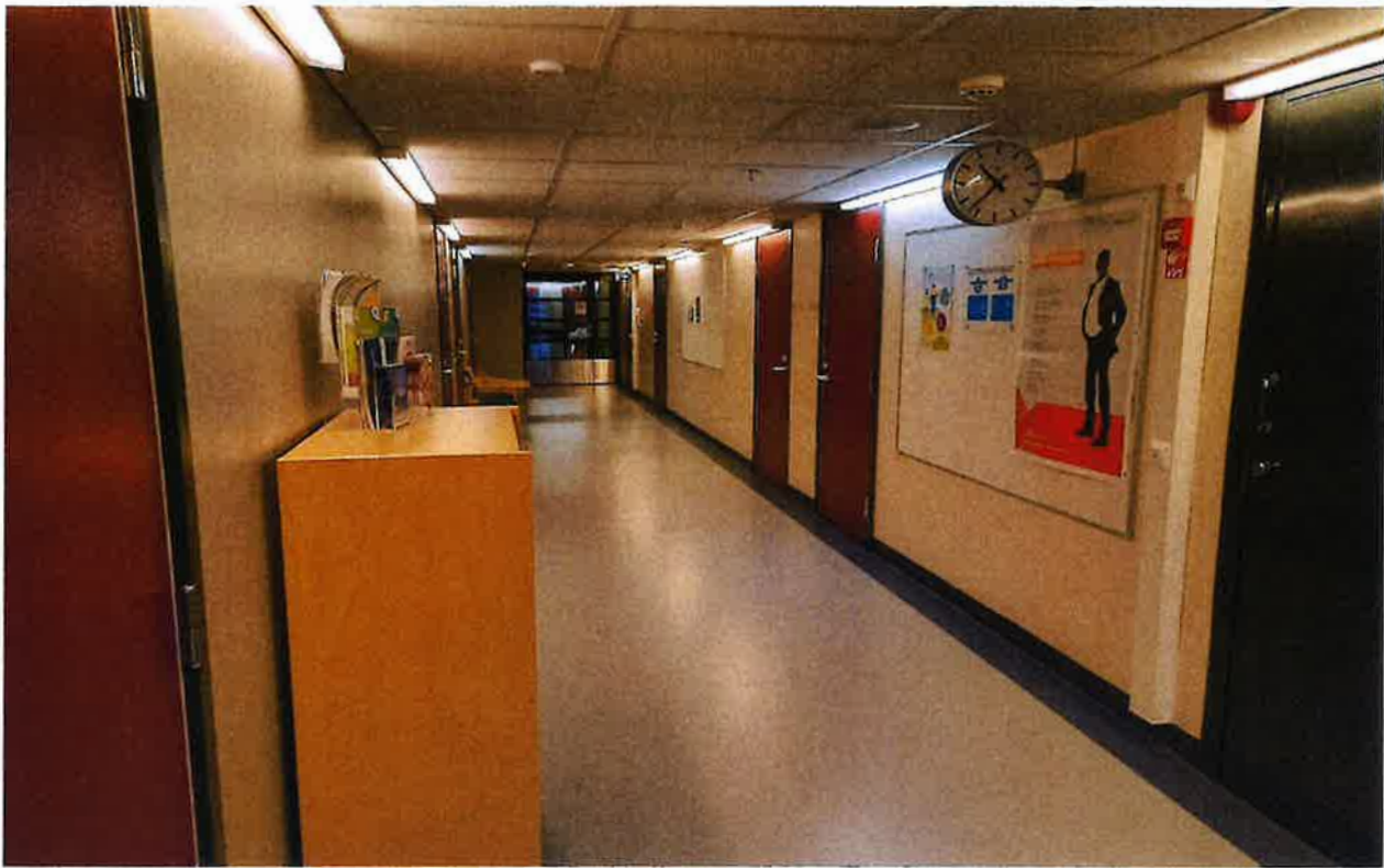
Terveyskeskuksen käytävä korjauksen jälkeen.
