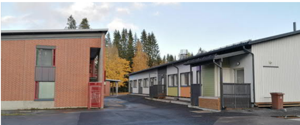
Rovastinkankaan koulun pihalle valmistuivat väistötilat elokuussa 2022, kun vieressä ollut Tredun Oriveden toimipisteen rakennus poistettiin käytöstä. Luokkatilojen lisäksi väistötiloihin tuli ruokala ja puutyötilat.
