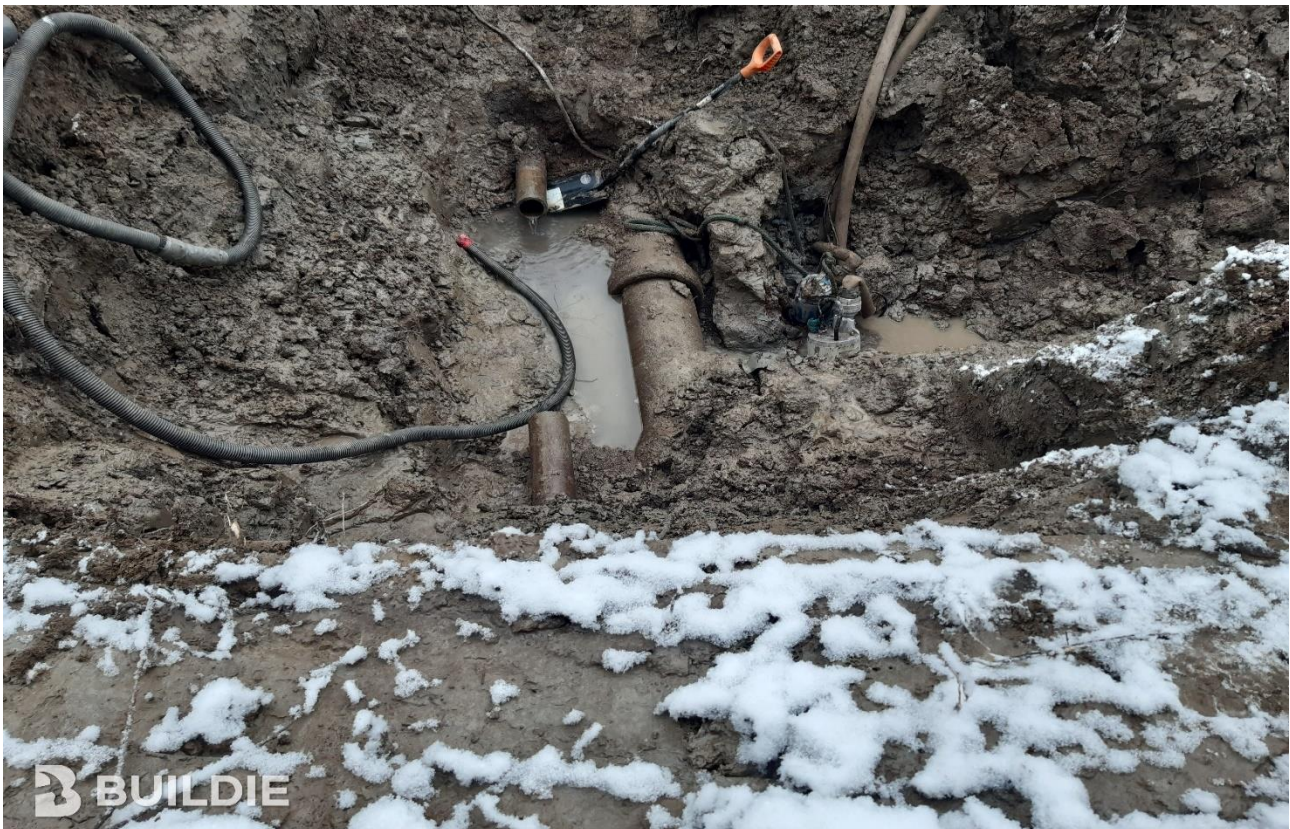
Asematien vesijohtovuotojen korjaus 10.-14.12.2022 (kolme eri vuotokohtaa tuona aikana)
