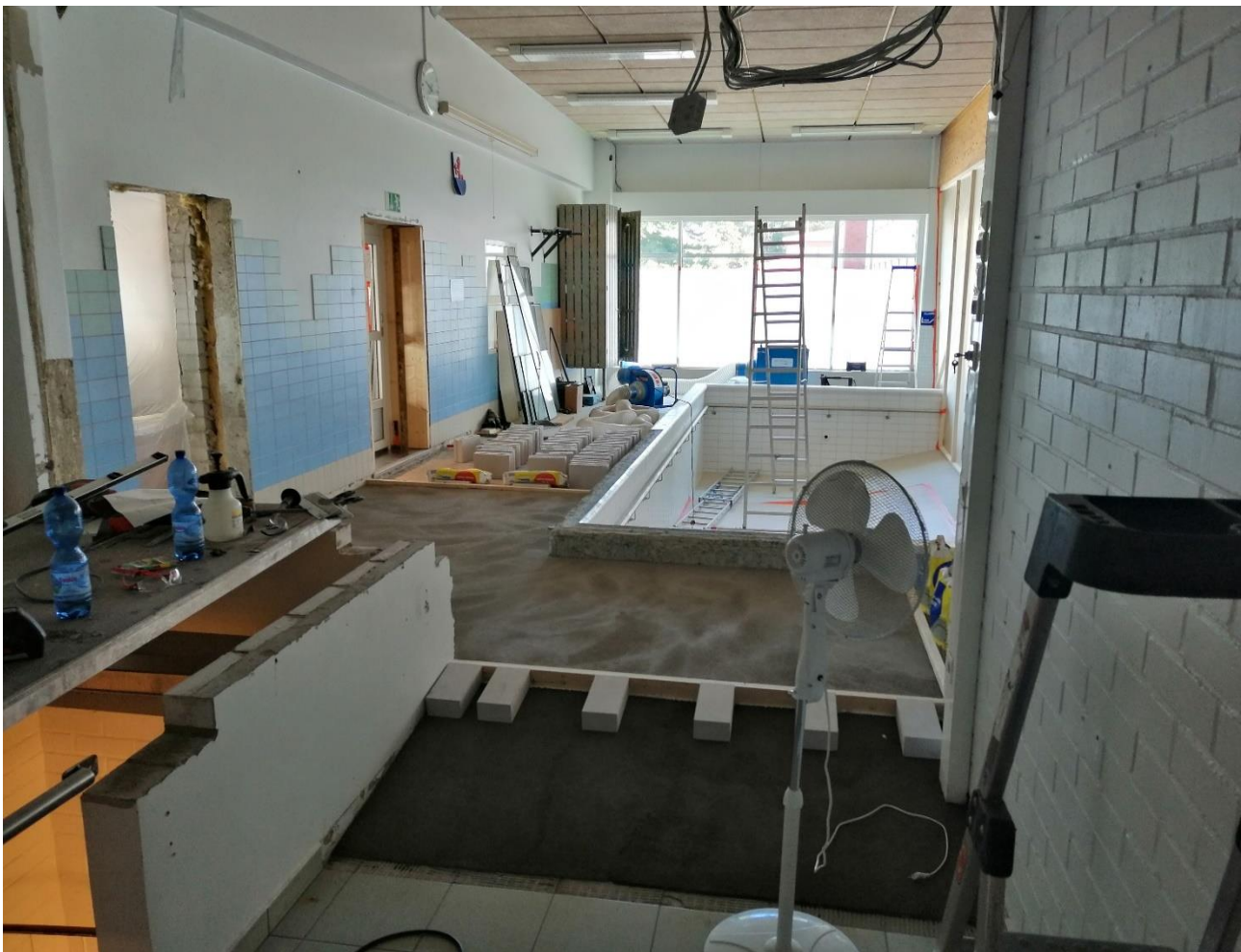
Uimahallin valvomon muutostyöt
