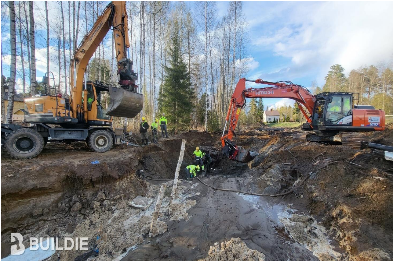
VT 9 runkovesijohdon paikan muutostyöt kevät 2022
