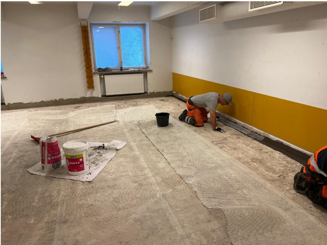
Yhteiskoulun B rakennuksen korjaus huhtikuu-joulukuu 2022
