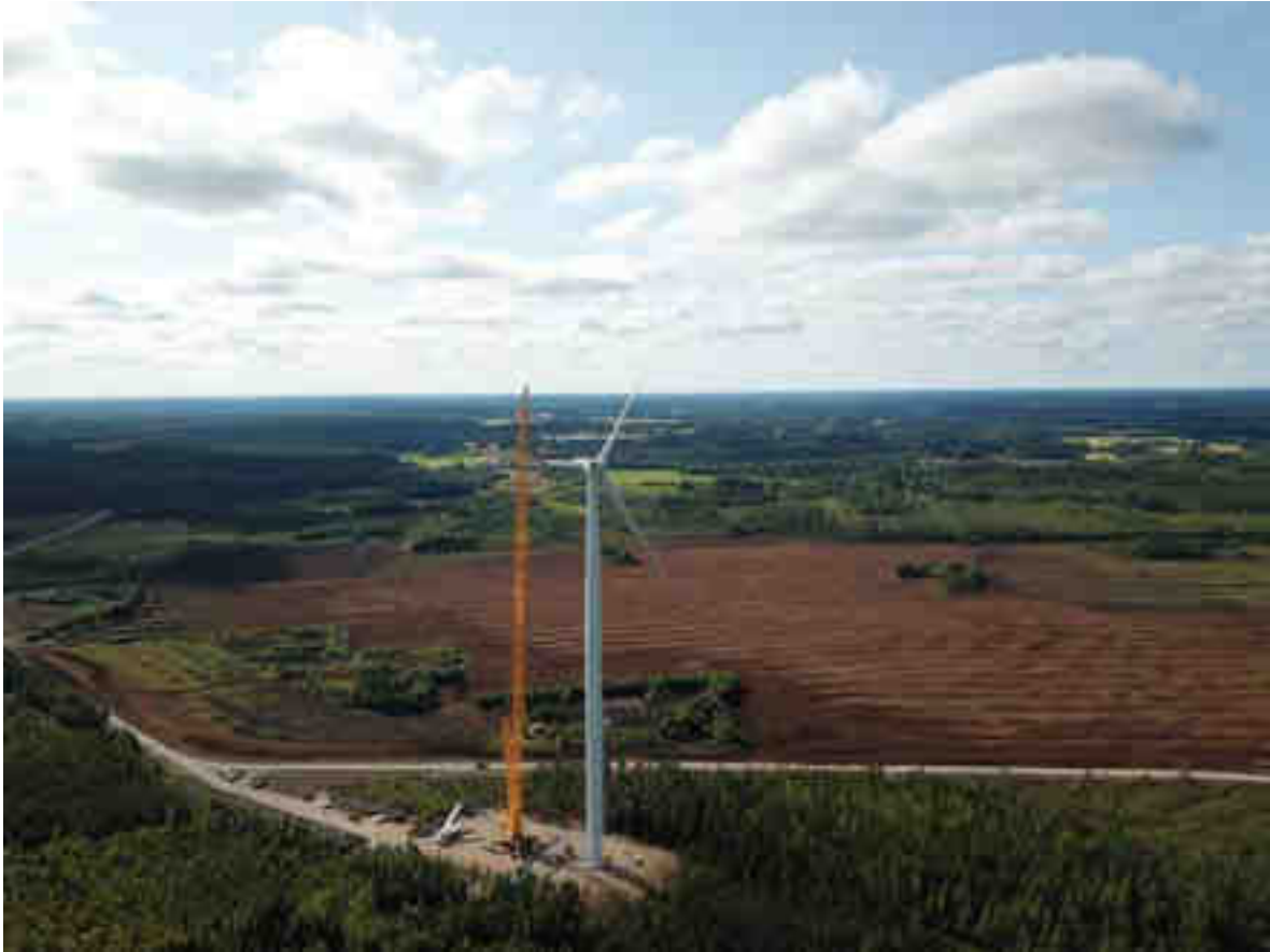
Kuva 7-1. Esimerkkikuva maankäytöstä tuulivoimalan rakentamisvaiheessa, Ratiperän tuulivoimapuisto Jämijärvellä (Kuva: ABO Wind Oy).
