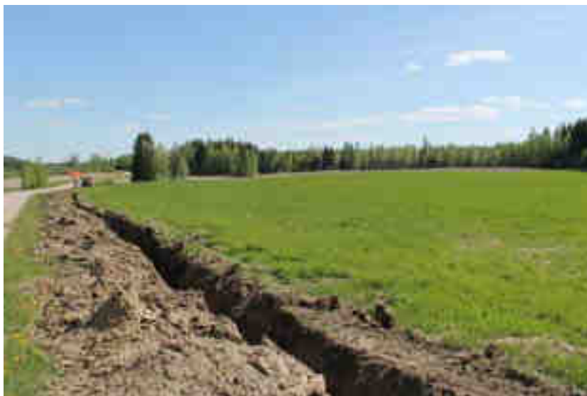
Kuva 7-10. Esimerkkikuva maakaapelin kaapeliojan kaivuutyöstä, Ratiperän tuulivoimapuisto Jämijärvellä (Kuva: ABO Wind Oy).
