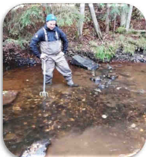
Kuva 5.5. Elo-syyskuussa ennen taimenen lisääntymisajankohdan käynnistymistä noin 15–20 minuutin huoltotyöllä kutusoraikkoon kertynyt kiintoaine poistetaan ja soraikon huokoisuus palautetaan.
