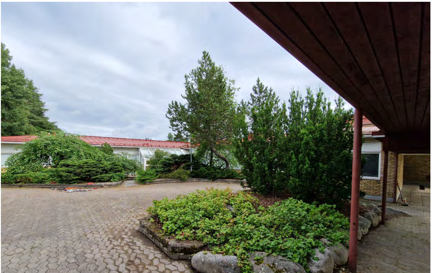
Sisäpiha kuvattuna C-osalle johtavan katoksen alta. EK
