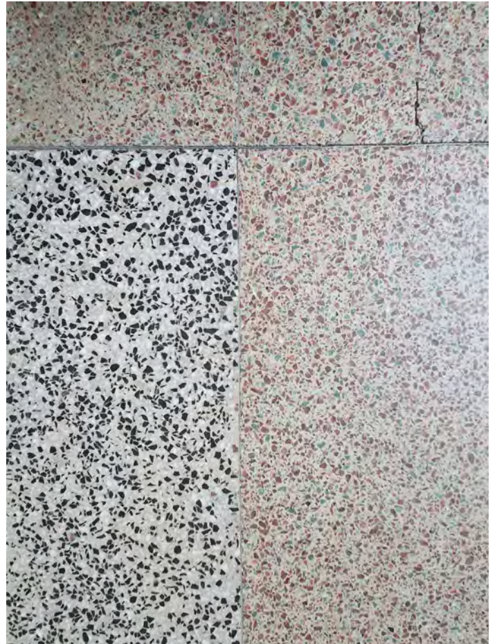
Alkuperäisen vuonna 1931 valmistuneen osan portaassa por-rastasanteilla on käytetty punavihreää kiviseosta, kun taas käytävässä ja portaissa mustavalkoista. EK.
