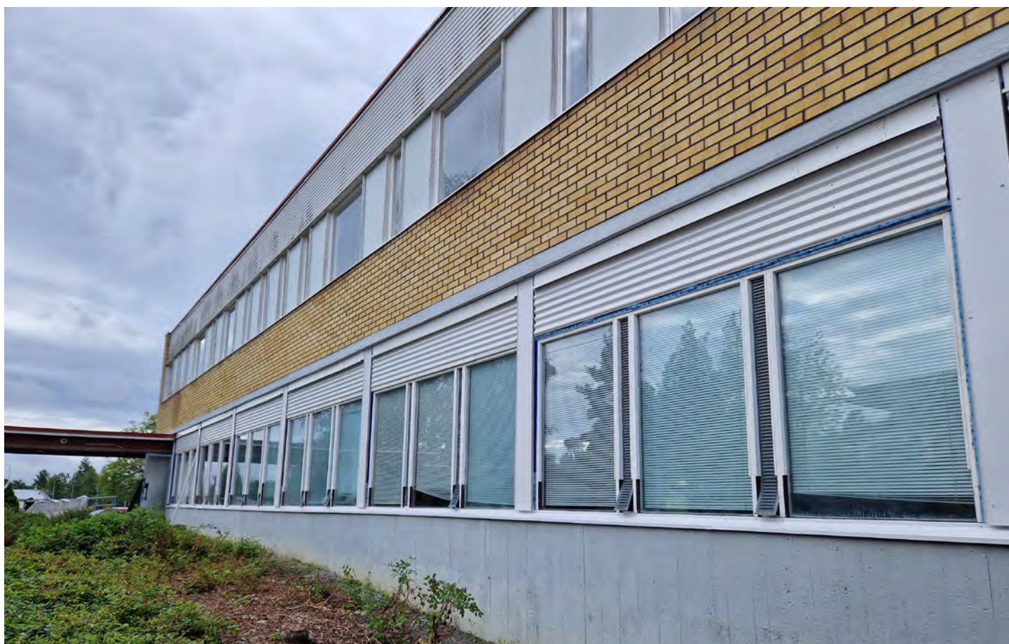
Sisäpihalle aukeava itäjulkisivu on muuttunut ilmeeltään huomattavasti vaaleammaksi. Sekä ikkunat ja niiden ympärökset, että sokkeli olivat alunperin tummanruskeita. Vertaa arkistokuvaan s.53. EK
