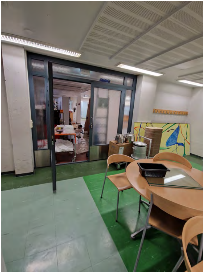
Alakerran pohjoispäädyn aulan alkuperäinen vihreä lattia ja tummat palo-ovet. EK
