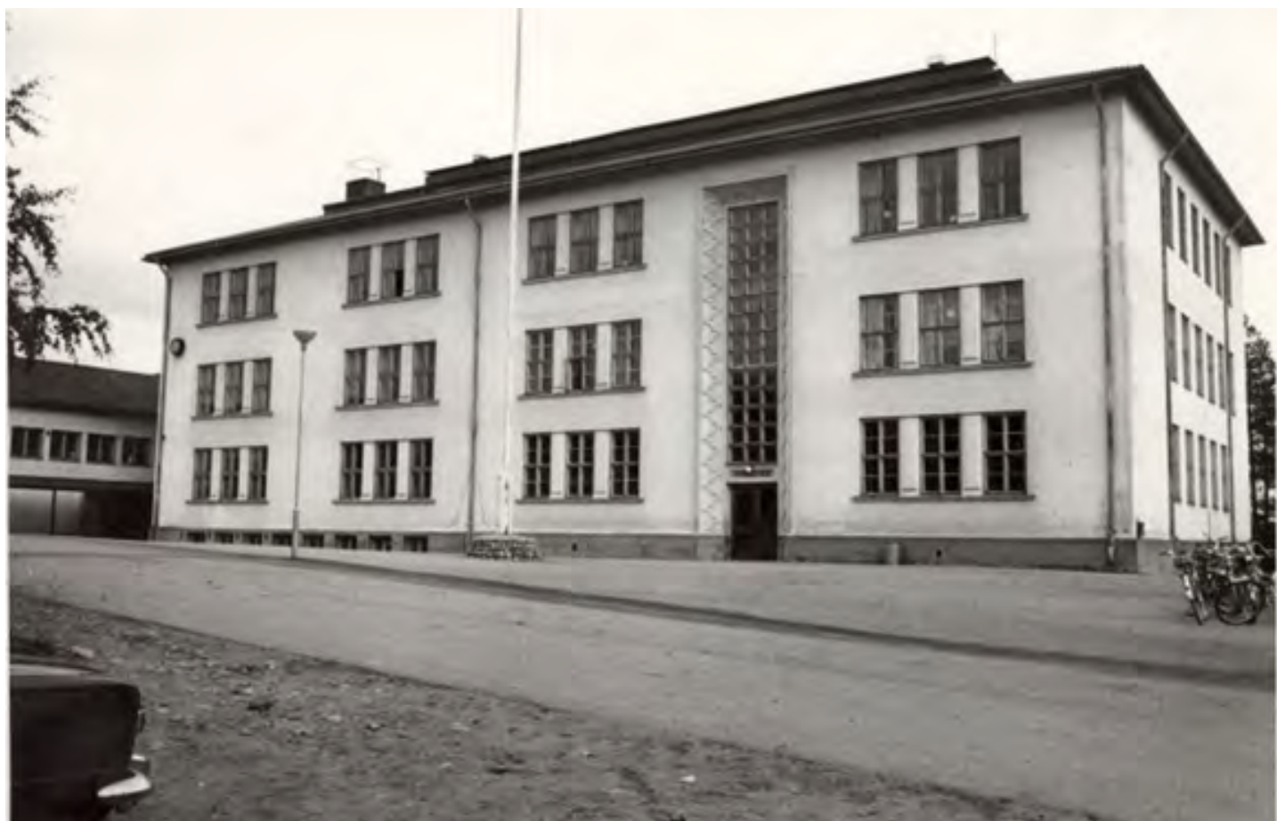
Martti Välikankaan suunnittelemassa yhteiskoulun laajennuksessa rakennusta korotettiin kerroksella, sekä pidennettiin pohjoiseen. Päärakennukset viereen rakennettiin uusi salirakennus, joka yhdistettiin päärakennukseen yhdyskäytävällä. Yhdyskäytävälle muodostui uusi katettu sisäänkäynti, joka vähensi alkuperäisen pääsisäänkäynnin käyttöä. Kuva 70-luvulta: Yhteiskoulun arkisto.
