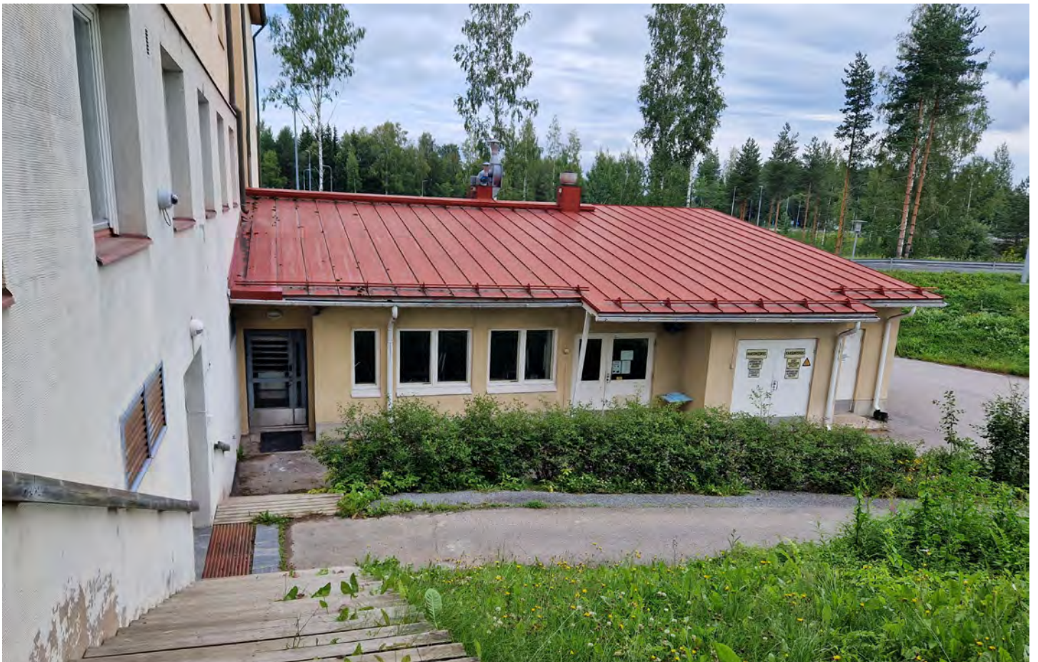
Vuoden 1997 laajennus. on alisteinen alkuperäiselle päärakennukselle, ja se jää hiukan syvennykseen. KS.
