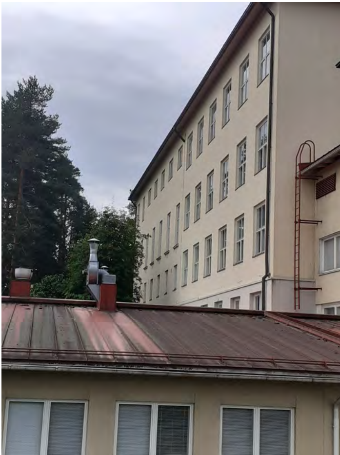
Pohjoisesta kuvattun itäjulkisivua, jossa näkyy julkisivun eri kokoiset ikkuna-aukot. Vanhan salin ikkunoiden alareunassa levennetty muuraus. KS.
