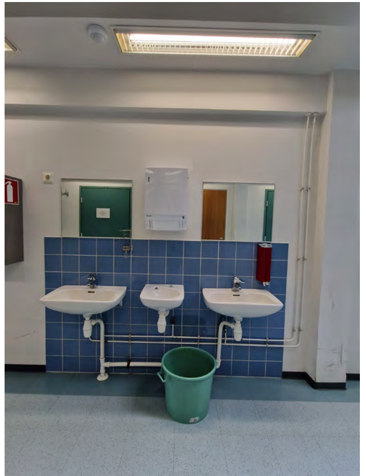
Vesipiste käytävällä, uusittu 1998.. KS
