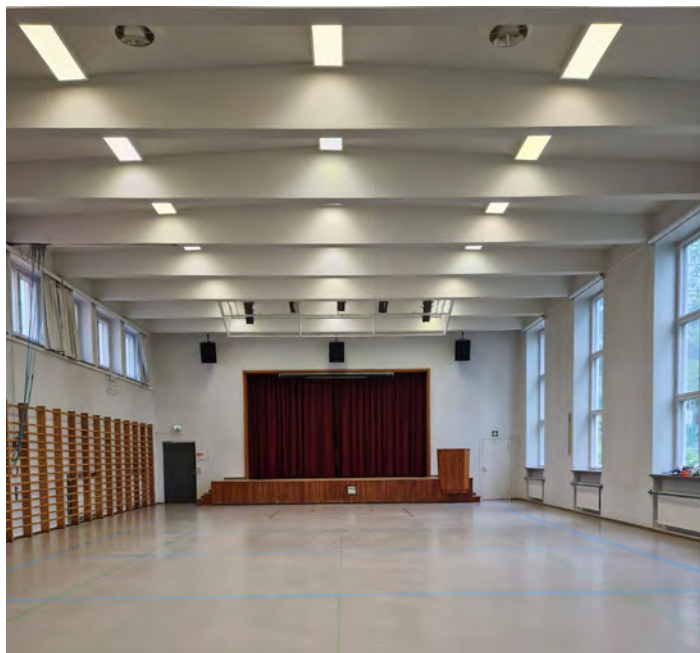
Liikuntasalin lattia on uusittu, mutta tilassa on säilynyt mm. alkuperäiset korkeat ikkunat ja puolapuut, sekä kattopalkistoon integroidut köysikiskot. EK
