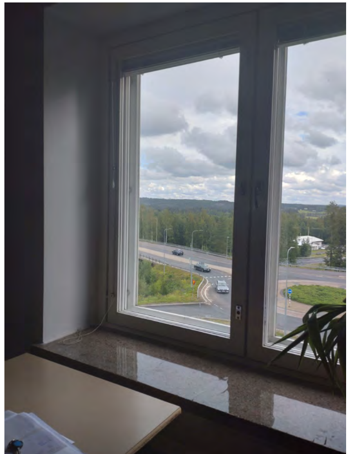
Vuoden 1955 laajennuksen korotusosassa salin yläpuoliset luokkatilat ovat muita matalampia. Ikkunapenkki on päällystetty läpinäkyvällä kiiltävällä massalla. KS
