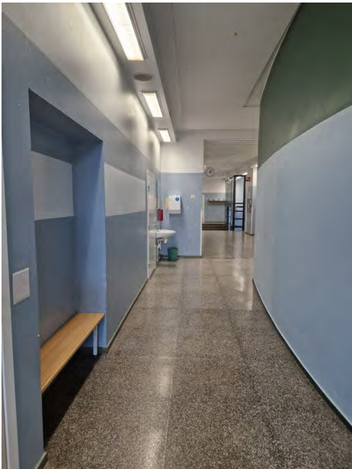
Käytävässä on alkuperäinen mosaiikkibetonilattia ja mahdollisesti alkuperäiset jalkalistat. Hissikuilu ja WC-tilat ovat tehneet käytävästä kapeamman ja sokkeloisen. KS
