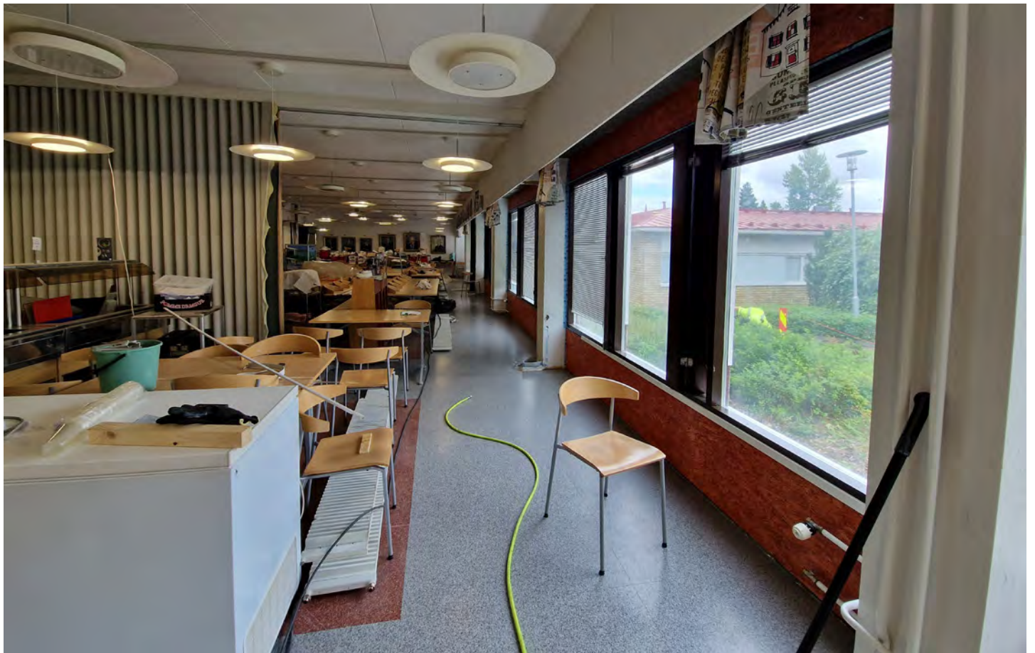
Ruokala on jaettavissa siirtoseinillä. Remontti kesken. EK
