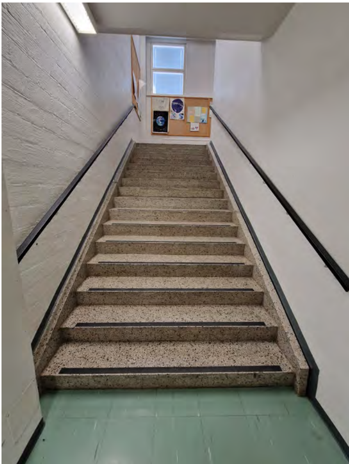
Pohjoispäädyn porttas ja alkuperäiset käsijohteet. EK
