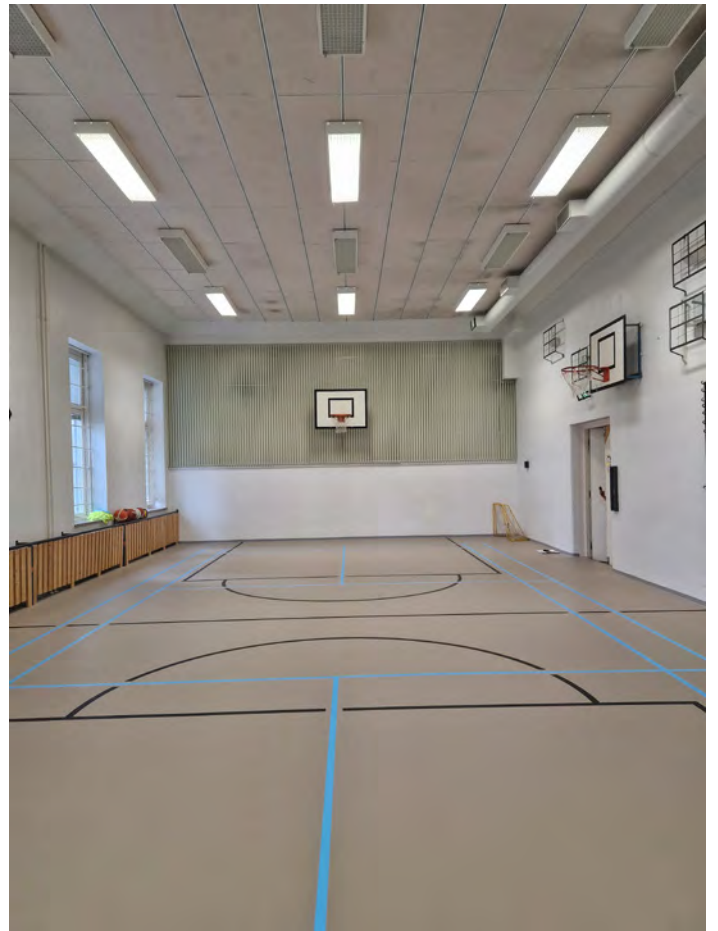
Vuoden 1931 osan liikuntasalista on purettu lava ja muurattu umpeen luokan ja salin välinen seinä. Ajankohta ei tiedossa. Kaikki pinnat uusia. EK
