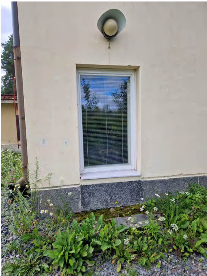
Alemman kellarikerroksen ulko-ovi on muutettu ikkunaksi. Vanha kulkuvalo ja porraskivi edelleen paikallaan. KS
