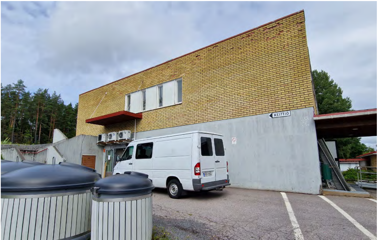
Eteläpäädyssä jo kertaalleen uusittu tiilimuuraus on rapautunut. EK
