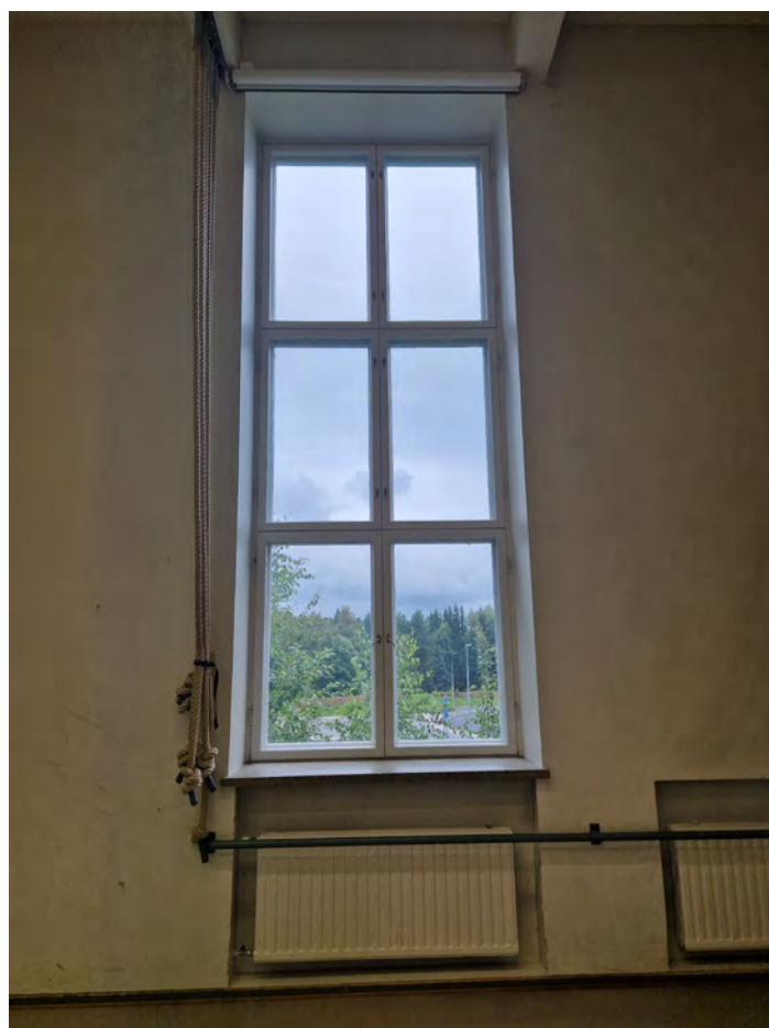
Salin alkuperäiset ikkunat, mosaiikkibetoniset ikkunapenkit ja patterisyvennykset. EK
