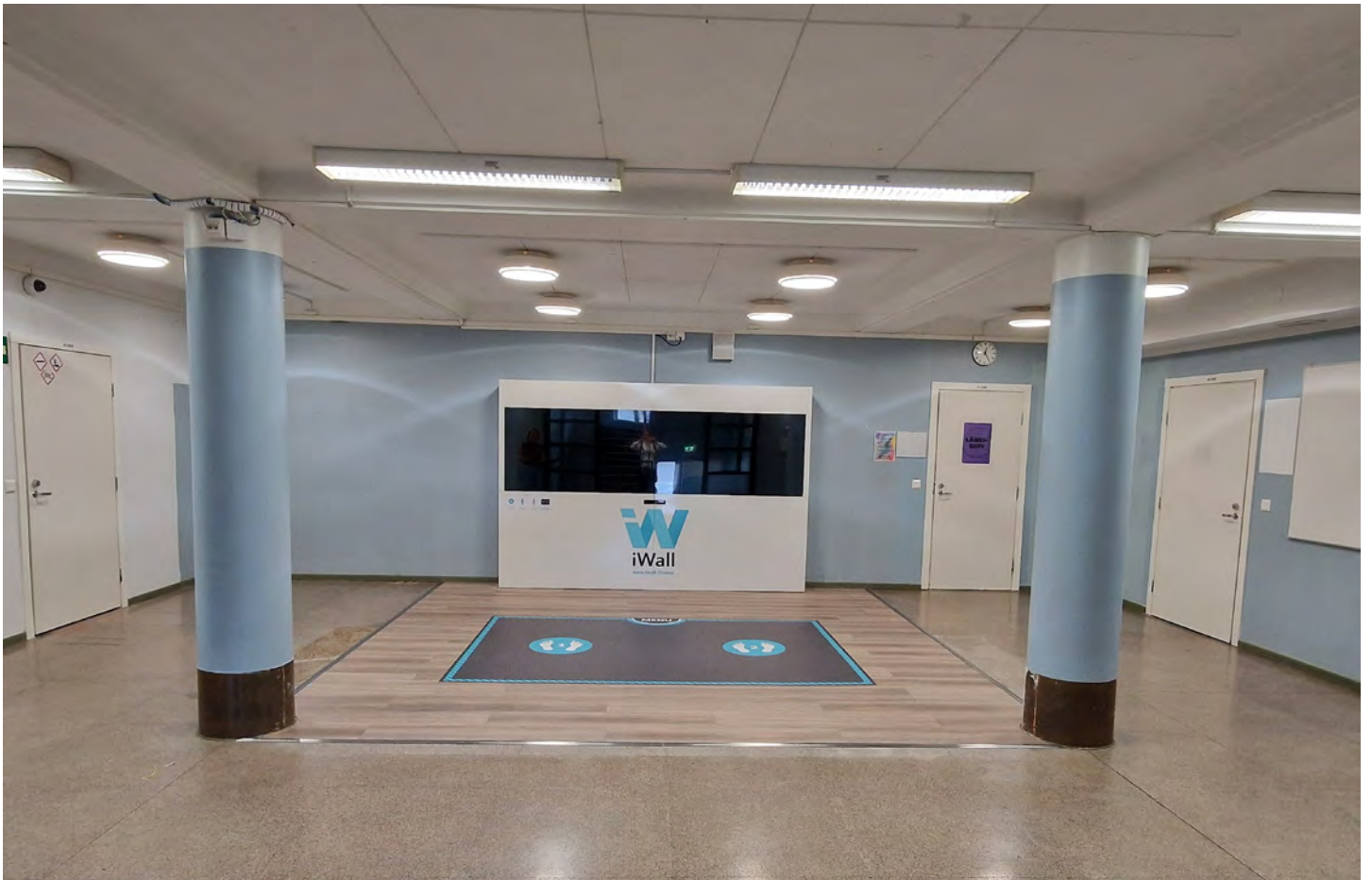
Vuonna 1931 valmistuneen koulurakennuksen aulaan on myöhemmin lisätty väliseinä, joka estää näkymät rakennuksen läpi. Muutos on tehnyt aulasta pimeän ja suljetun. EK
