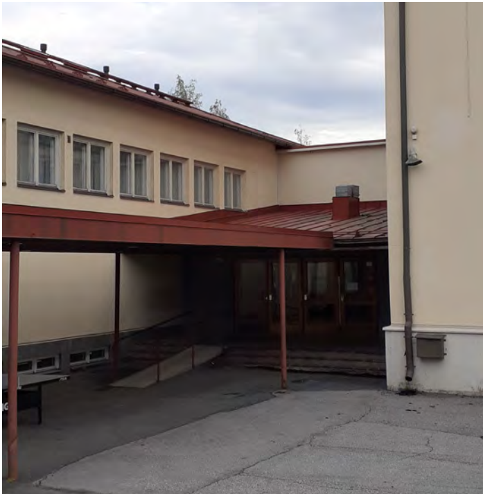
B-osaan johtava katos on jatkettu alkuperäisestä sisäänkäyntikatoksesta. KS.
