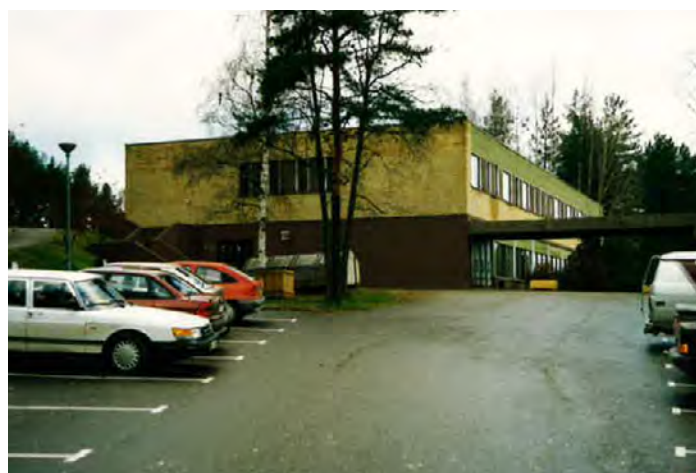
20 vuotta vanha C-osa ennen peruskorjausta oli huomattavasti tummempi kuin nykyään. Oriveden kaupungin kuva-arkisto.
