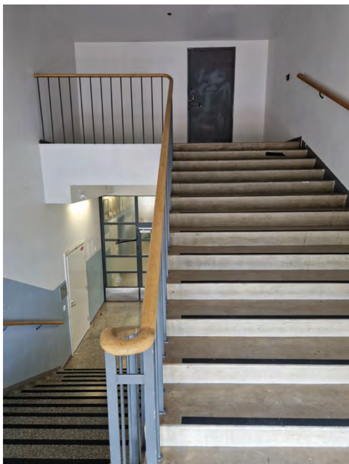
Vuonna 1955 valmistuneen laajennuksen ullakolle johtava porras. Yläpäässä vaatimattomampi askelmapinta viestii opetustilojen loppumisesta. Alhaalla näkyy osastoiva palolasisseinä. EK
