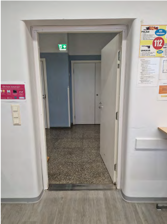
Luokkien oviaukkojen reunat on luokkahuoneiden puolella pyöristetty. KS.
