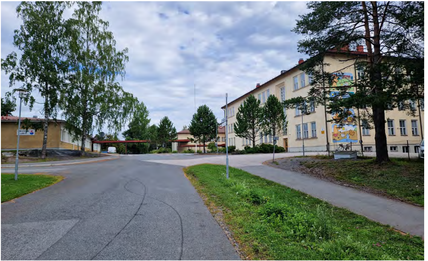
Oriveden yhteiskoulu kesällä 2023 Opintieltä kuvattuna. Oikealla näkyy alikululta tuleva kevyen liikenteen väylä. Pihaan on 1998 istutettu mäntyjä ja A-osan eteläpäättyyn tehty murali 2021. EK.
