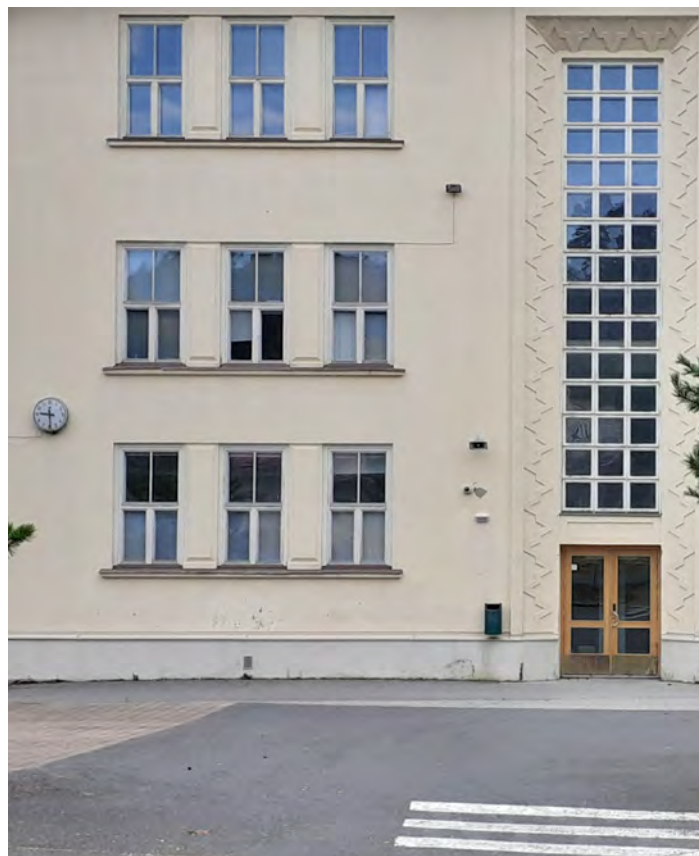
Luokkien ikkunat on toteutettu länsilukisivuun kolmen ryhminä. Ikkunoiden välissä kohopinta ja alla ulonnettu jalus. Laajennuksessa kellarin ikkunat on sovitettu ylempiin ikkunoihin. KS.
