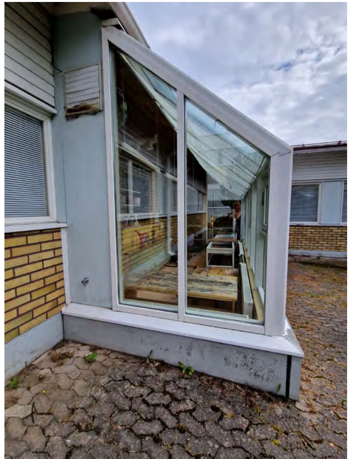
Vuoden 1998 peruskorjauksessa rakennukseen lisättiin viherhuone, johon on käynti opettajien tilasta. Lasitiili-ikkunat jäivät viherhuoneeseen sisään. KS
