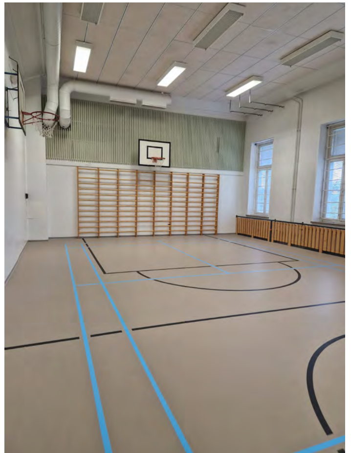
Salin ylänurkassa näkyvät teräsrakenteet lienevät jääneet alkuperäisestä vuoden 1931 rakennusvaiheesta. EK
