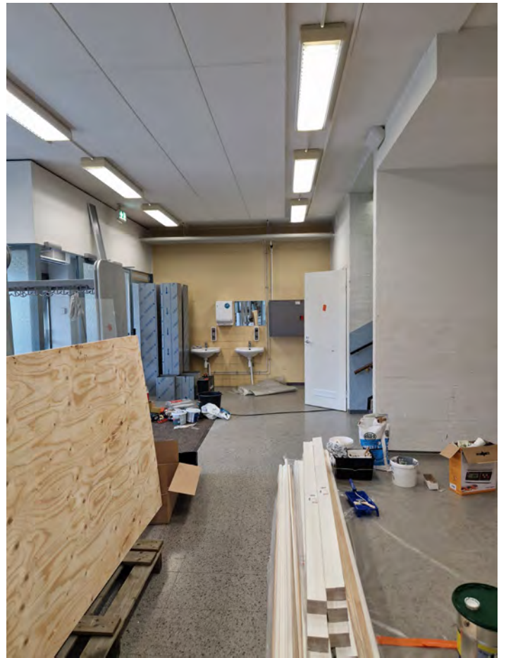
Ruokalan aulassa on alkuperäinen mosaiikkibetonilattia. EK
