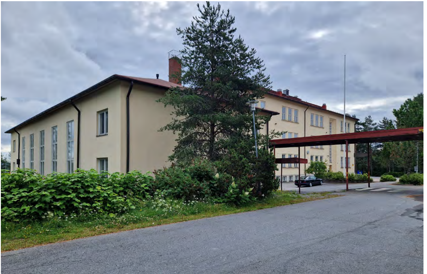
Liikuntasalisiipi kuvattuna luoteesta. KS.
