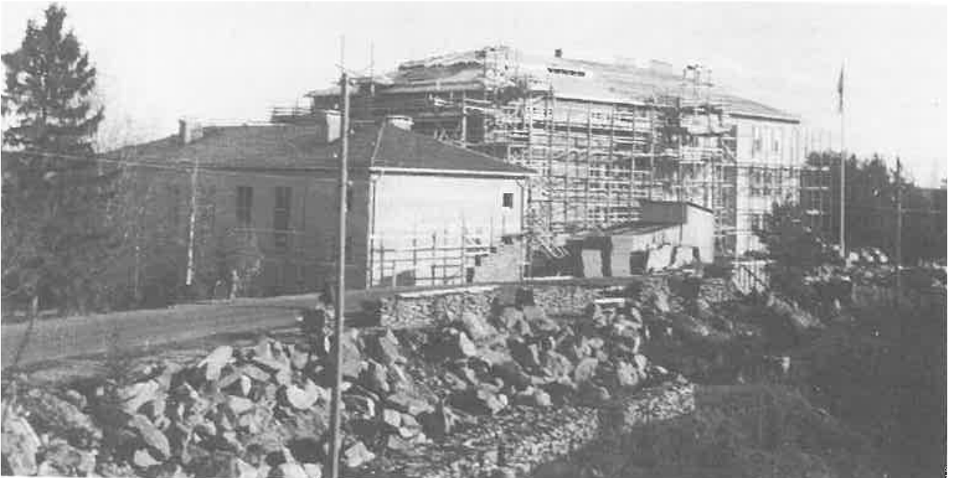
Oriveden yhteiskoulu, A-osan laajennuksen työmaa 1955. Kuva: Yhteinen koulumme 70 vuotta.
