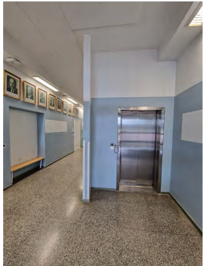
Suurimpia muutoksia on hissien lisääminen käytävään. Vuonna 1998 rakennukseen lisätty hissikuilu estää näkymän käytävän päädyistä toiseen. KS
