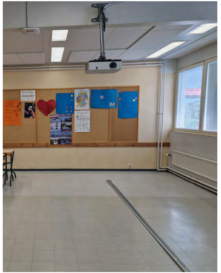
Luokkahuoneiden pinnat on pääosin uusittu. Lattian tummempi uosuus lienee alkuperäinen ja tilan muututtua sitä on jatkettu eri värisellä laattalla. Ilmoitustaulut saattavat olla alkuperäiset 1970-luvulta. KS
