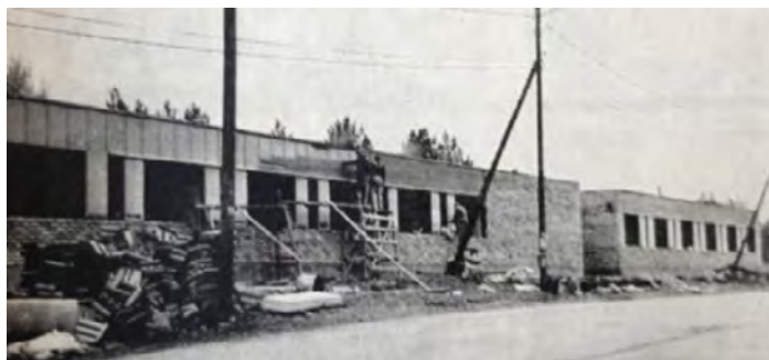
Laajennuksen rakentamista 1972. 50 vuotta sitten: Harjannostajaiset Yhteiskoululla, Oriveden sanomat 15.10.2022
