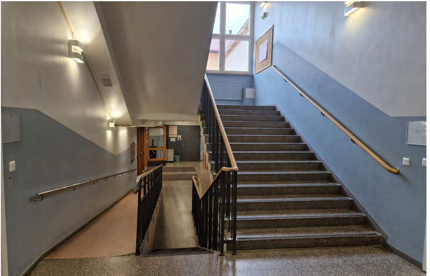
Luokkasiiven päädyssä oleva porras liittyy nivelosan sisäänkäyntiaulaan. Portaaseen on toteutettu vuonna 1998 esteetön luiska, joka kaventaa porrasta huomattavasti. KS
