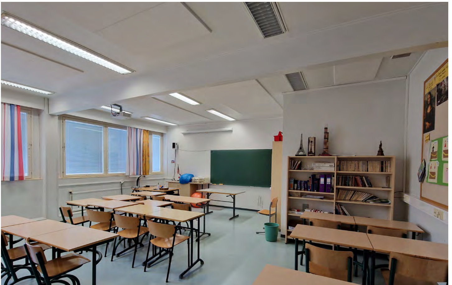
Uudempi luokkahuone. Kuvassa näkyy hyvin rakennuksen kantava pilari-palkki-järjestelmä. EK
