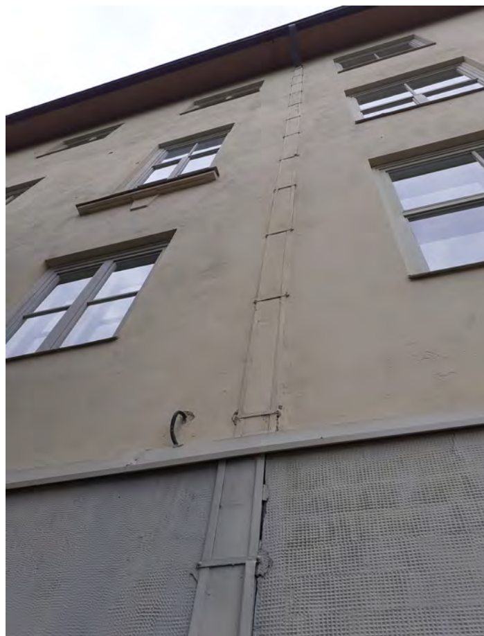
Muista syöksytorvista poiketen itäjulkisivulla laajennuksen saumakohtaan on toteutettu syvännetty syöksytorvi. KS.
