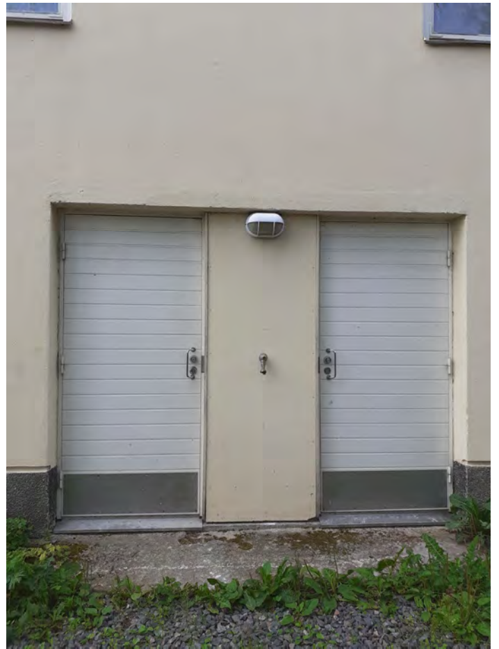
Alempaan kellarikerrokseen lisätyt ulko-ovet teknisen työn aputiloihin. KS.
