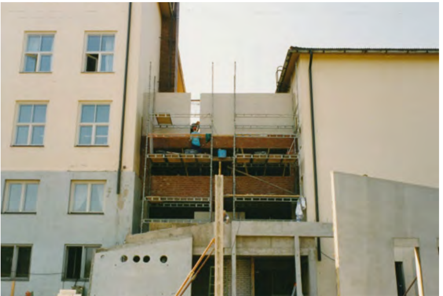
Lisäsiiven rakennustyömaa. Oriveden kunnan arkisto.
