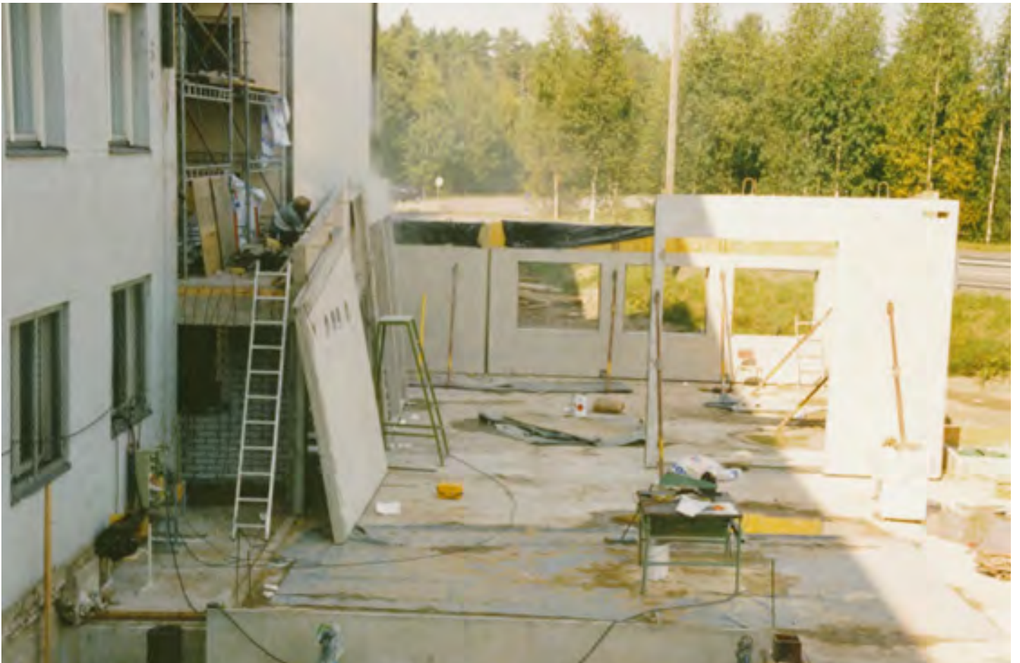
Lisäsiiven ja teknisen työn tilojen rakennustyömaa. Oriveden kunnan arkisto.
