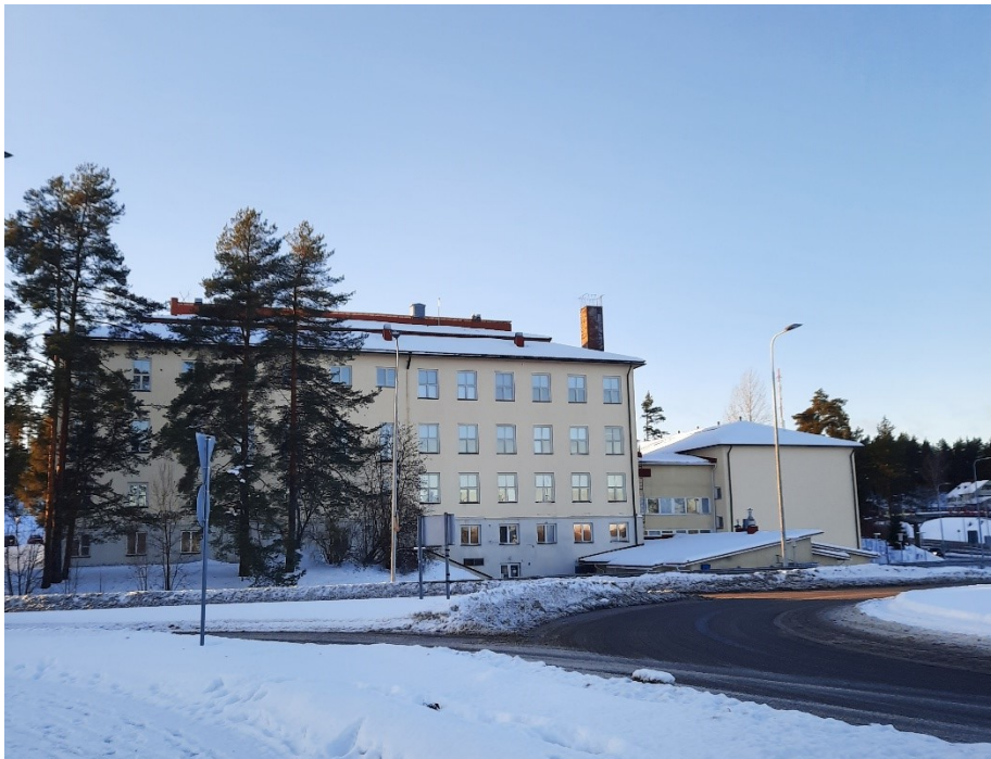
Kuva 2. Koulukompleksi kiertoliittymän suunnasta kuvattuna joulukuussa 2023.
