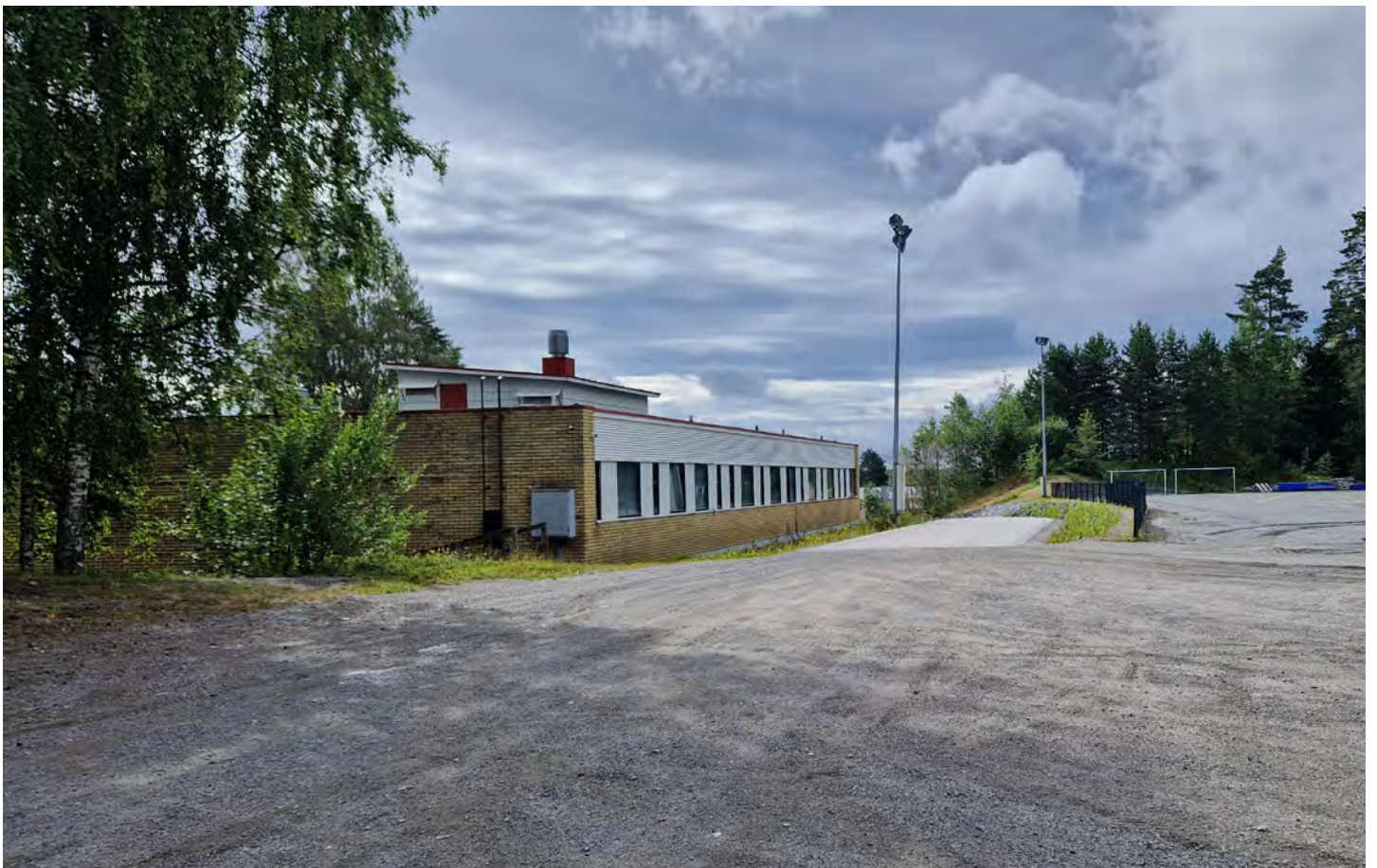
Kentälle näkyvä länsijulkisivu. IV-konehuone lisätty 1998. EK
