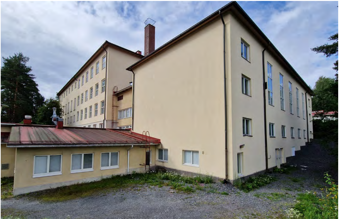
Vuoden 1997 laajennus. on muuttanut rakennuksen itäjulkisivua itään ja pohjoiseen. Tyyllillisesti on koitettu sovittaa laajennus vanhaan arkkitehtuuriin, mutta kellarin ja nivelosan laajentuessa rakennus on menettänyt tietyn linjakkuuden. KS.
