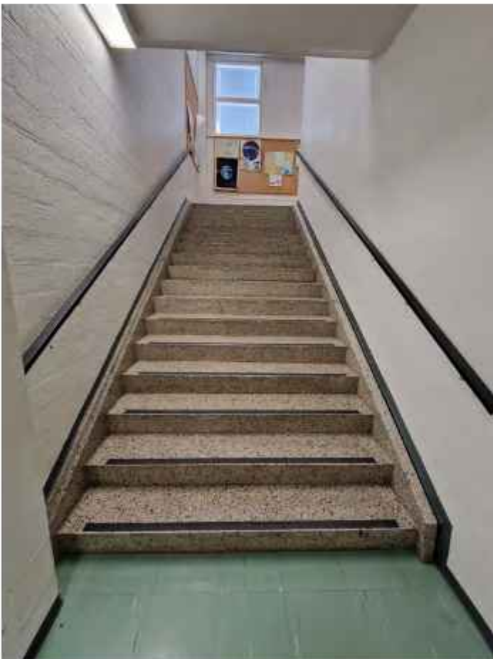
Pohjoispäädyn porras ja alkuperäiset käsijohteet. EK
