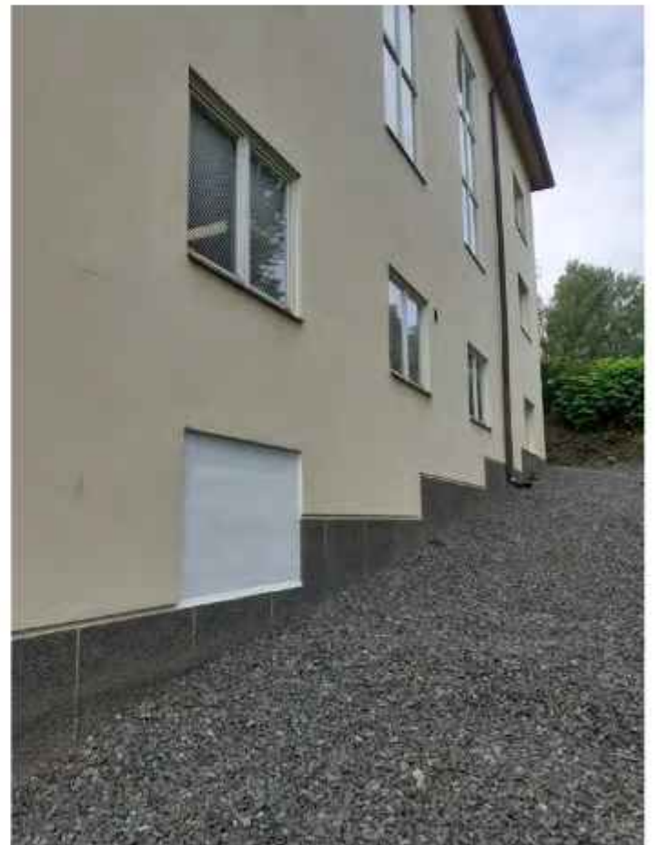
Alemman kellarikerroksen ikkuna on ummistettu. Sokkeli on porrastettu maanpinnan mukaan. KS.
