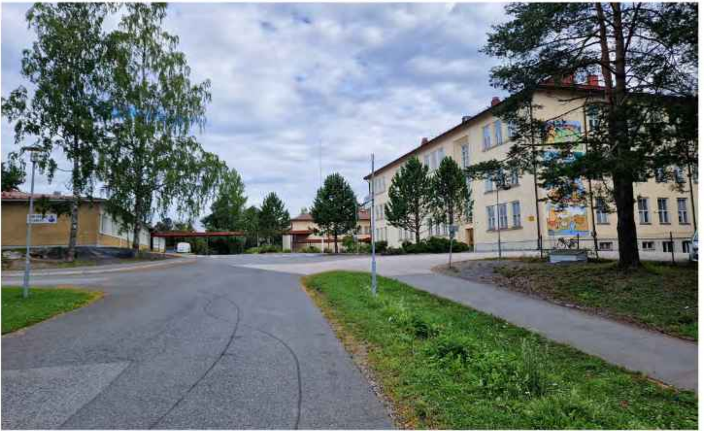
Oriveden yhteiskoulu kesällä 2023 Opintieltä kuvattuna. Oikealla näkyy alikululta tuleva kevyen liikenteen väylä. Pihaan on 1998 istutettu mäntyjä ja A-osan eteläpäättyyn tehty muraali 2021. EK.
