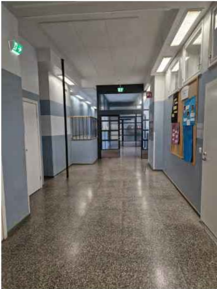
Vuonna 1955 valmistunut koulun korotusosa. käytävät ja portaat on rajattu vuoden 1998 peruskorjauksessa omiksi palo-osastoikseen. EK
