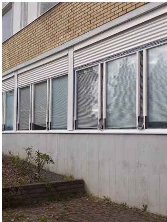
Ruokasalin ikkunoiden pellitykset on vaihdettu vaaleiksi ja yläpuolinen puupanelointi aaltolevyyn. KS
