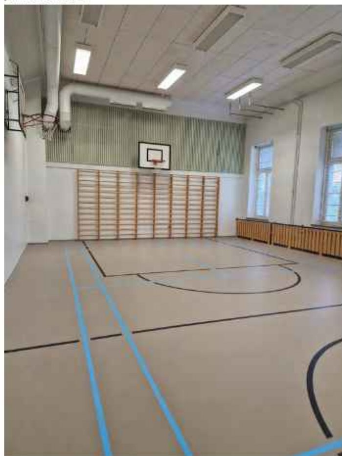
Salin ylänurkassa näkyvät teräsrakenteet lienevät jääneet alkuperäisestä vuoden 1931 rakennusvaiheesta. EK
