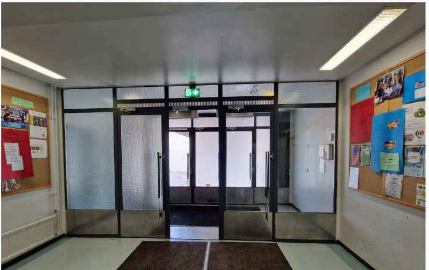
A-osalle johtavat ovet ovat alkuperäiset. Ovissa on huurrettu lasi, mikä luo aulaan hämärän tunnelman. EK
