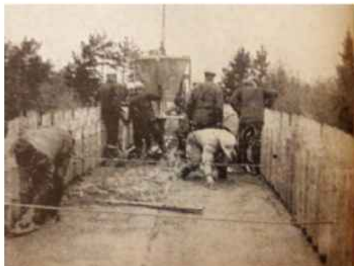
Oriveden yhteiskoulun jalankulkusillan työmaa 1971. 50 vuotta sitten: Yhteiskoulun tiesiltään betonkansi, tientehtäjät ehtineet jo Olkahisiin, Oriveden sanomat 22.5.2021
