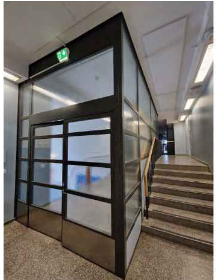
Portaan palo-osastoiva koppi pimentää käytävää ja tukkii näkymän käytävän päästä toiseen. EK
