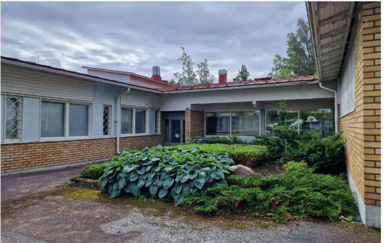
Takapuolen sisäänkäynnistä kulku terveydenhuollon siipeen ja pukutiloihin. Istutusalueet ovat alkuperäiset ja ne on pidetty hyvinä.. EK
