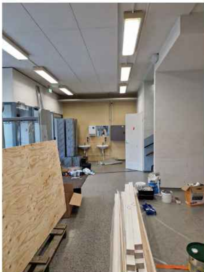
Ruokalan aulassa on alkuperäinen mosaiikkibetonilattia. EK
