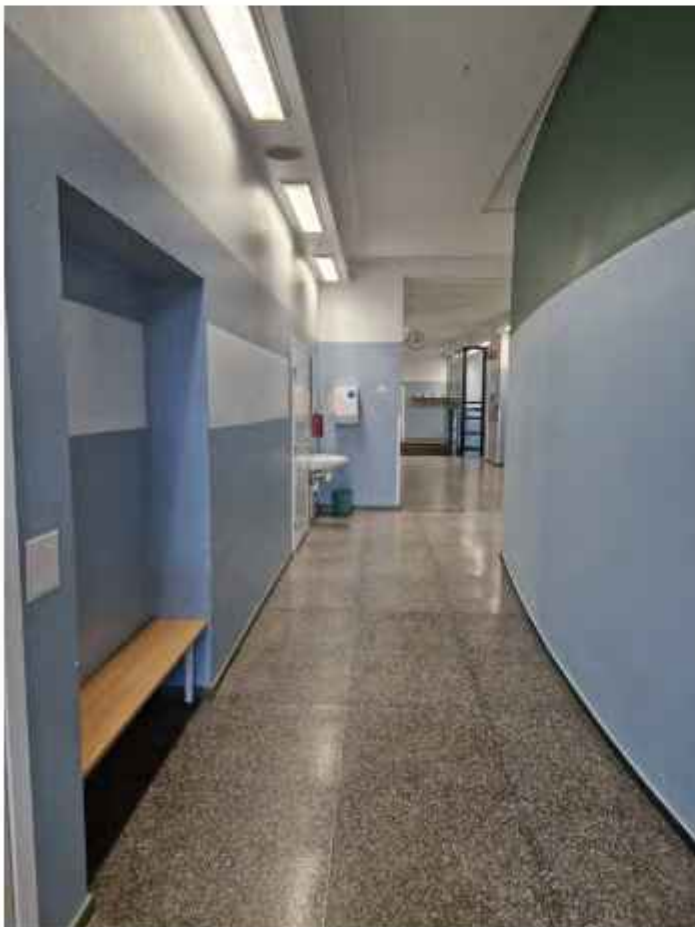
Käytävässä on alkuperäinen mosaiikkibetonilattia ja mahdollisesti alkuperäiset jalkalistat. Hissikuilu ja WC-tilat ovat tehneet käytävästä kapeamman ja sokkeloisen. KS
