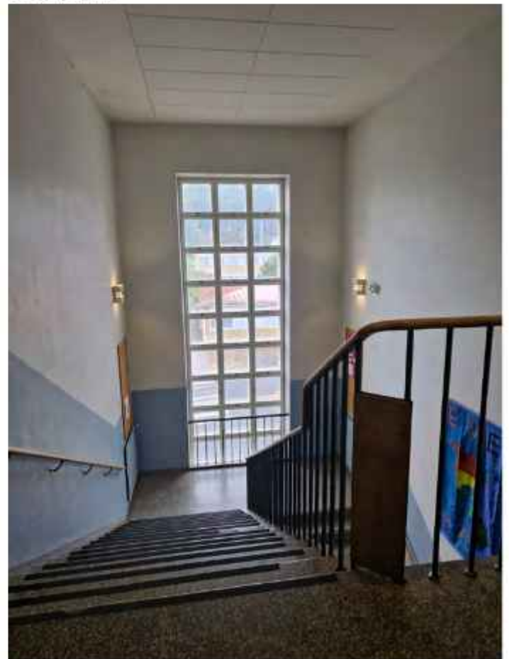
Vuonna 1931 valmistunutta porrashuonetta on korotettu vuonna 1955. Alkuperäisten ikkunoiden sisäpuittimet on korvattu lämpösisälementeillä. Kaiteessa nelion malliset pinnat vinottain. EK
