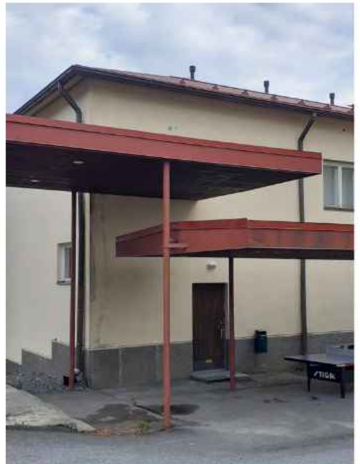
1973 rakennettu yhdyskatos B-osaan on osittain kiinni liikuntasalisivun julkisivussa. Alkuperäinen vuoden 1955 ulko-ovi porras-huoneeseen. KS.
