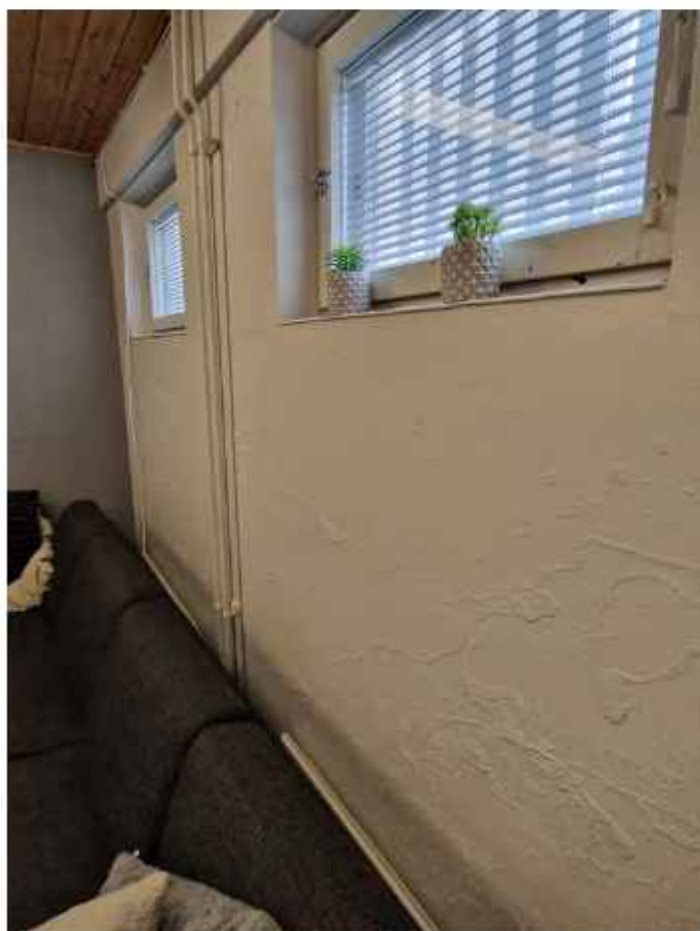
Pintamateriaalit on uusittu pitkälti. Alakatto lienee alkuperäinen. EK
