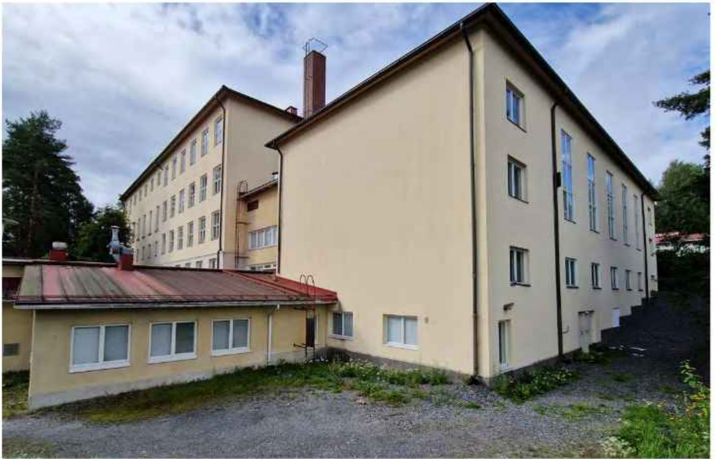
Vuoden 1997 laajennus on muuttanut rakennuksen itäjulkisivua itään ja pohjoiseen. Tyyllillisesti on koitettu sovittaa laajennus vanhaan arkkitehtuuriin, mutta kellarin ja nivelosan laajentuessa rakennus on menettänyt tietyn linjakkuuden. KS.
