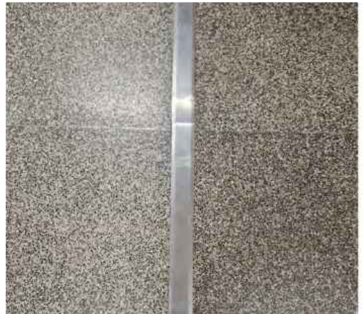
Vuosina 1931 ja 1955 toteutettujen mosaiikkibetonipintojen sävy käytävässä eroaa hiukan toisistaan. Saumaan lisätty myöhemmin RST-lista. EK.
