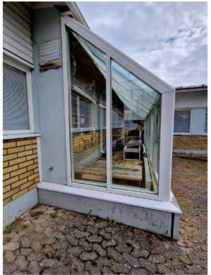
Vuoden 1998 peruskorjauksessa rakennukseen lisättiin viherhuone, johon on käynti opettajien tilasta. Lasitiili-ikkunat jäivät viherhuoneen sisään. KS
