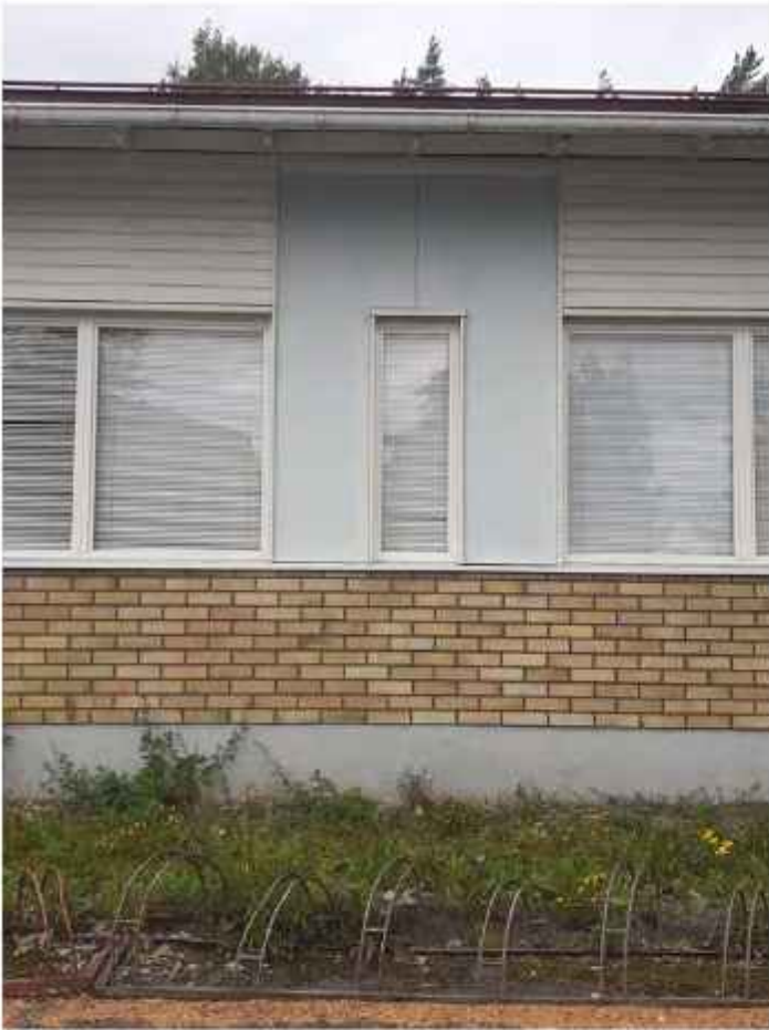
Tumman laudoituksen ja tummien ikkunanpuitteiden sijaan nauhaikkunoiden ympärys kokonaisuutena on nyt vaalea. KS
