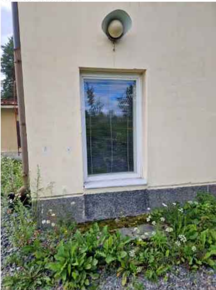
Alemman kellarikerroksen ulko-ovi on muutettu ikkunaksi. Vanha kulkuväli ja porraskivi edelleen paikallaan. KS
