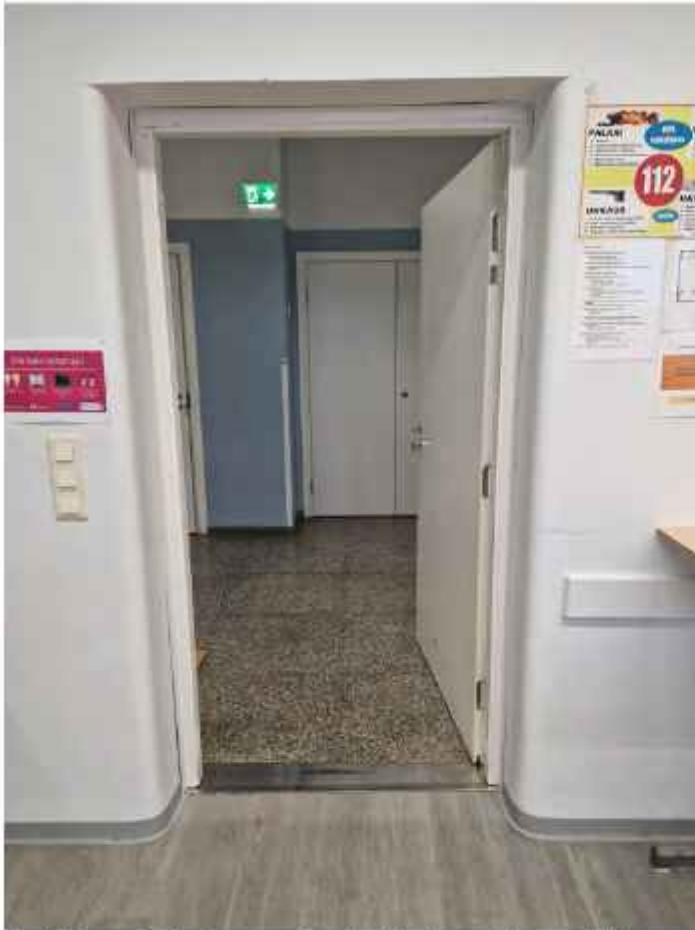
Luokkien oviaukkojen reunat on luokkahuoneiden puolella pyörästetty. KS.
