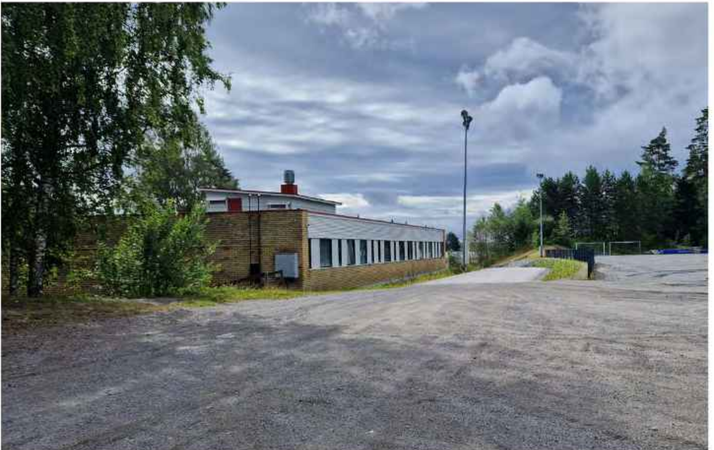
Kentälle näkyvä länsijulkisivu. IV-konehuone lisätty 1998. EK
