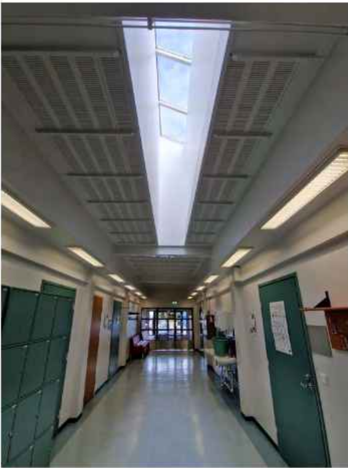
Käytävässä on alkupeäriset kattoikkunat, joista tulee valoa muuten hämärään käytävään. EK
