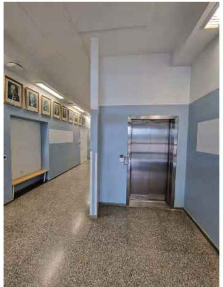
Suurimpia muutoksia on hissien lisääminen käytävään. Vuonna 1998 rakennukseen lisätty hissikuilu estää näkymän käytävän päädyistä toiseen. KS
