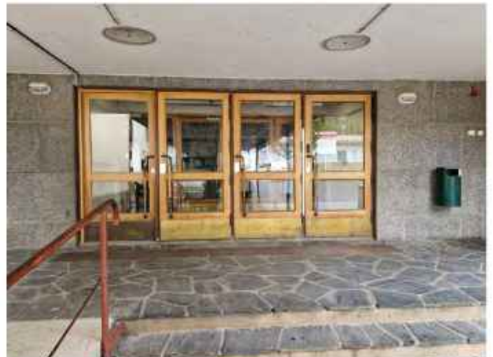
Nivelosan sisäänkäynnissä alkuperäiset tammiovet ja siroiterappaus. Askelmilla ja tasanteella liuskekivilaatoitus. KS.
