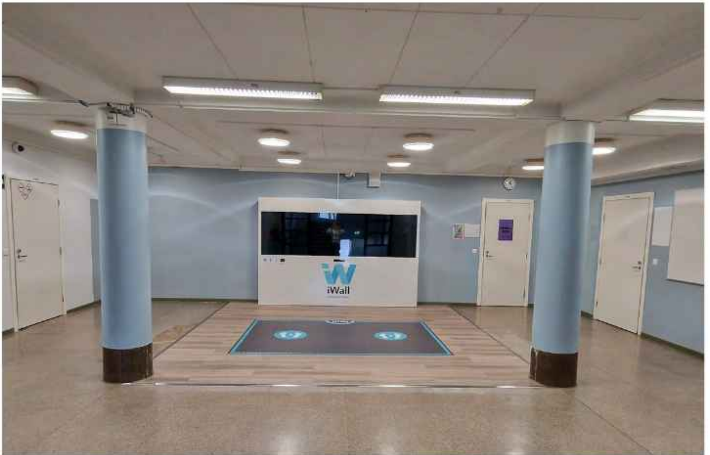
Vuonna 1931 valmistuneen koulurakennuksen aulaan on myöhemmin lisätty väliseinä, joka estää näkymät rakennuksen läpi. Muutos on tehnyt aulaa pimeän ja suljetun. EK
