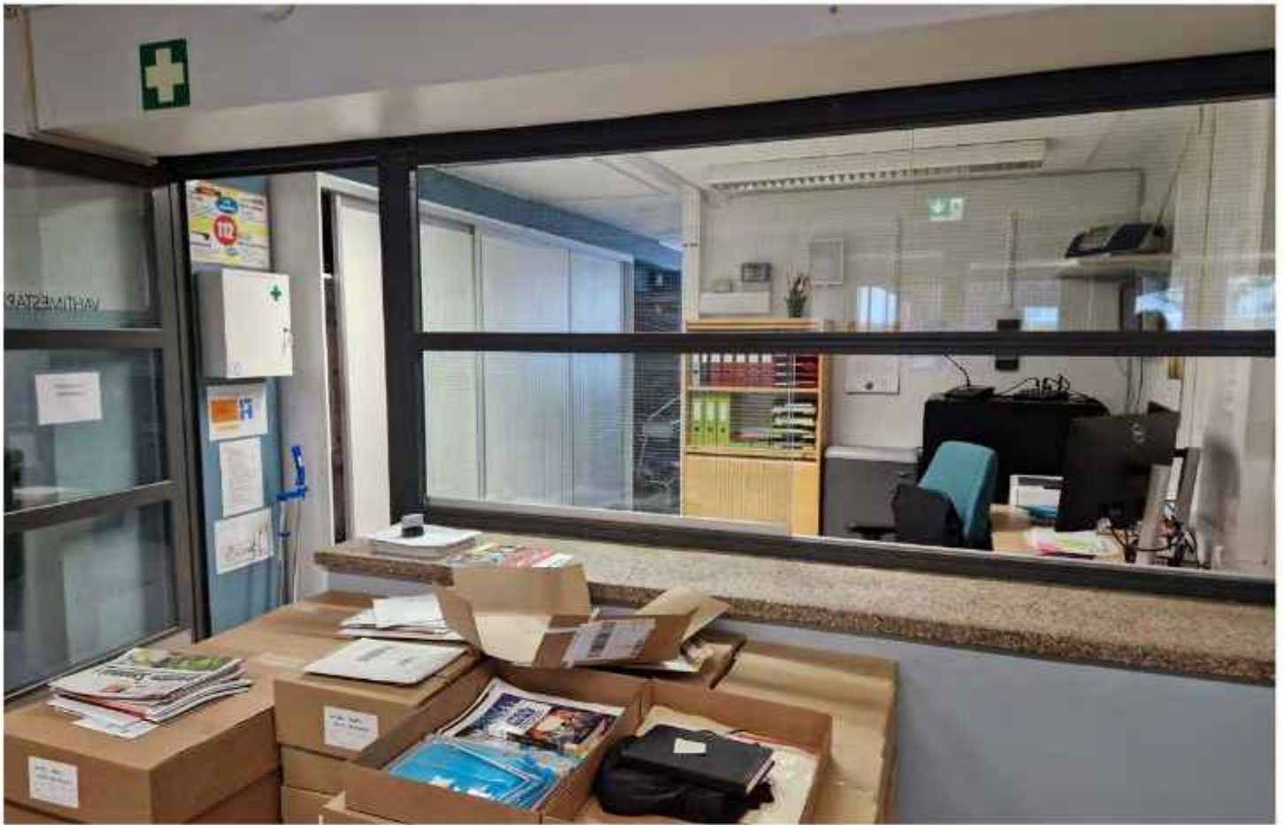
Nivelosan sisäänkäyntiäulaa on laajennettu vuonna 1998 valmistuneessa peruskorjauksessa, jolloin siihen on rakennettu vahtimestarin toimisto. Aiemmin käytävässä oli ikkunat ja niistä näkymä suoraan itään. KS
