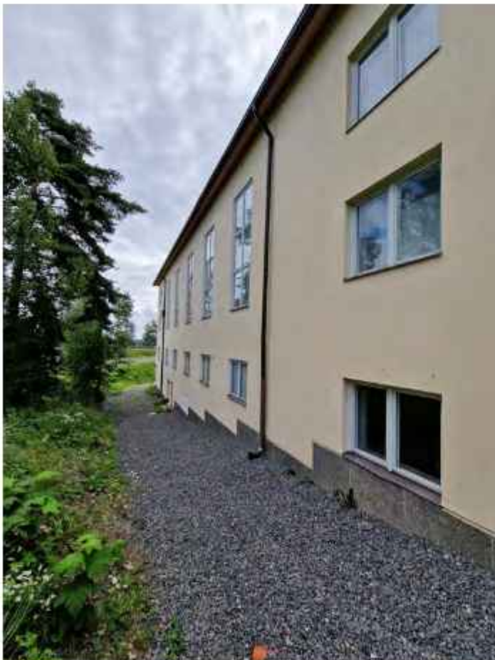
Pohjoisjulkisivu, liikuntasalin korkeat ikkunat ja matalat perusikkunat ovat ulkopuolelta alkuperäiset vuodelta 1955.. EK
