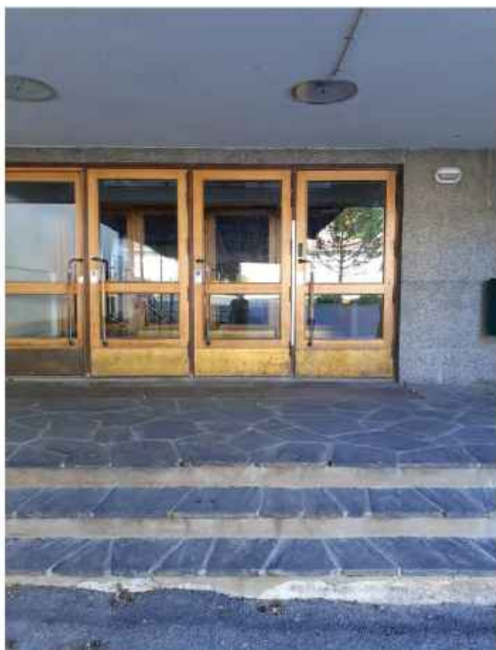
Nivelosan sisäänkäynnin tammiovet ja katoksen valaisinsyvennykset. 1950-luvulle tyypillisen liuskekiviporras tasanteineen. KS.
