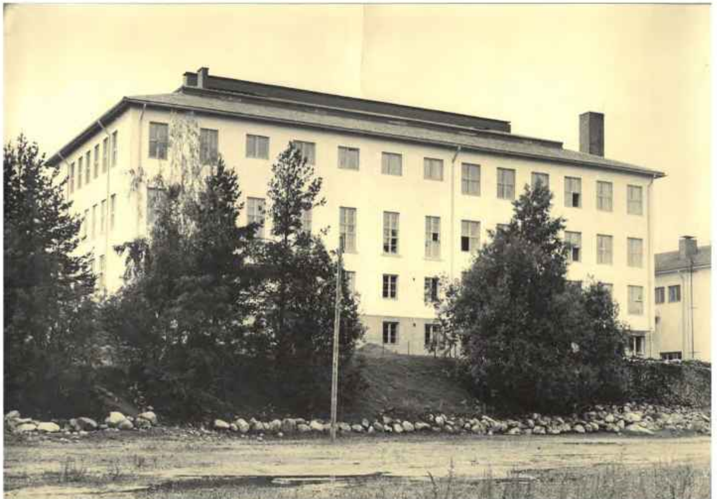
Valmis koulurakennus idästä. Nykyään koulun takaa kulkee tie. Kuva: Yhteiskoulun arkisto.
