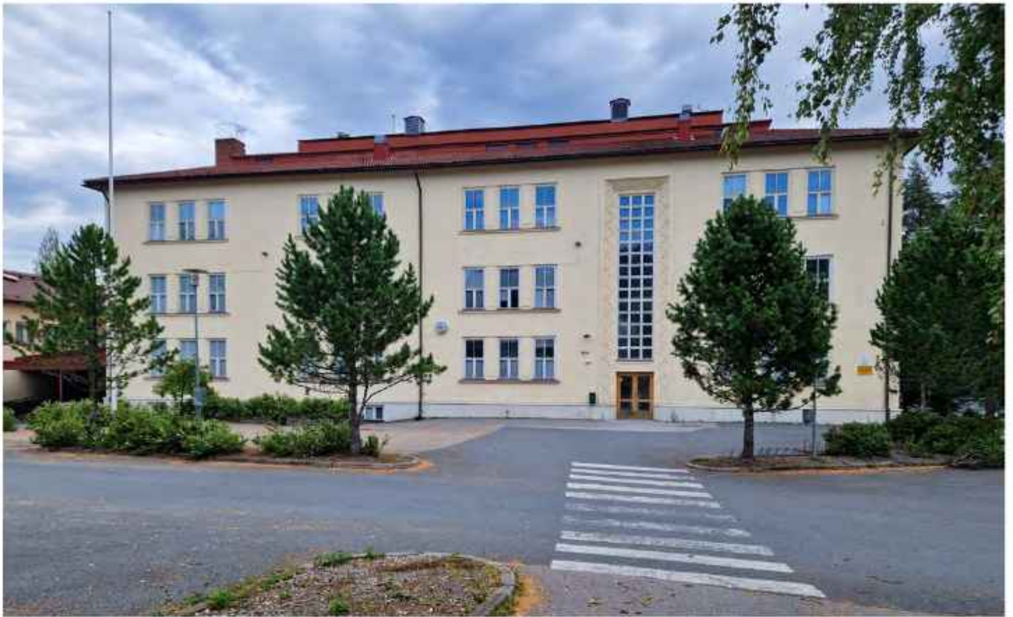
Länsijulkisivu, jossa näkyy alkuperäinen ikkunarytmitys ja sisäänkäynti. Pihalla 1990-luvun lopussa istutettuja mäntyjä ja pensaita, sekä laatoitettu alue. Pihan läpi kulkee kevyen liikenteen väylä. KS.
