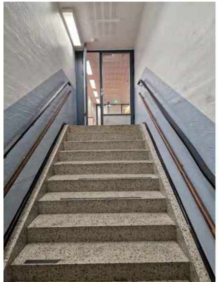
Eteläpäädyn portaaseen on lisätty toiset käsijohteet. EK
