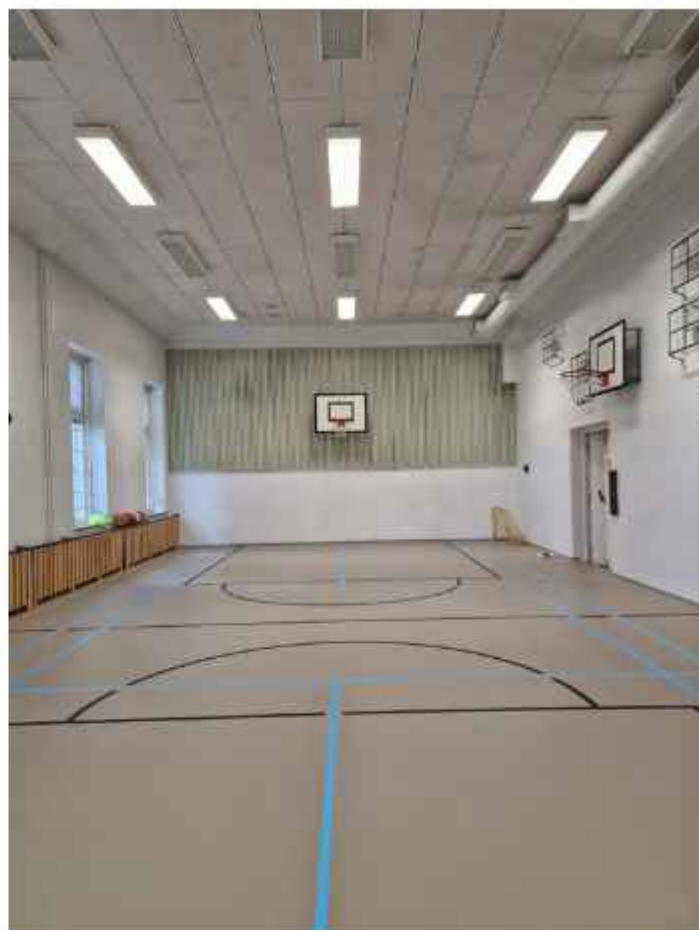
Vuoden 1931 osan liikuntasalista on purettu lava ja muurattu umpeen luokan ja salin välinen seinä. Ajankohta ei tiedossa. Kaikki pinnat uusia. EK
