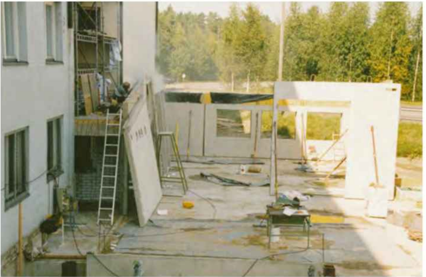
Lisäsiiven ja teknisen työn tilöjen rakennustyömaa. Oriveden kunnan arkisto.
