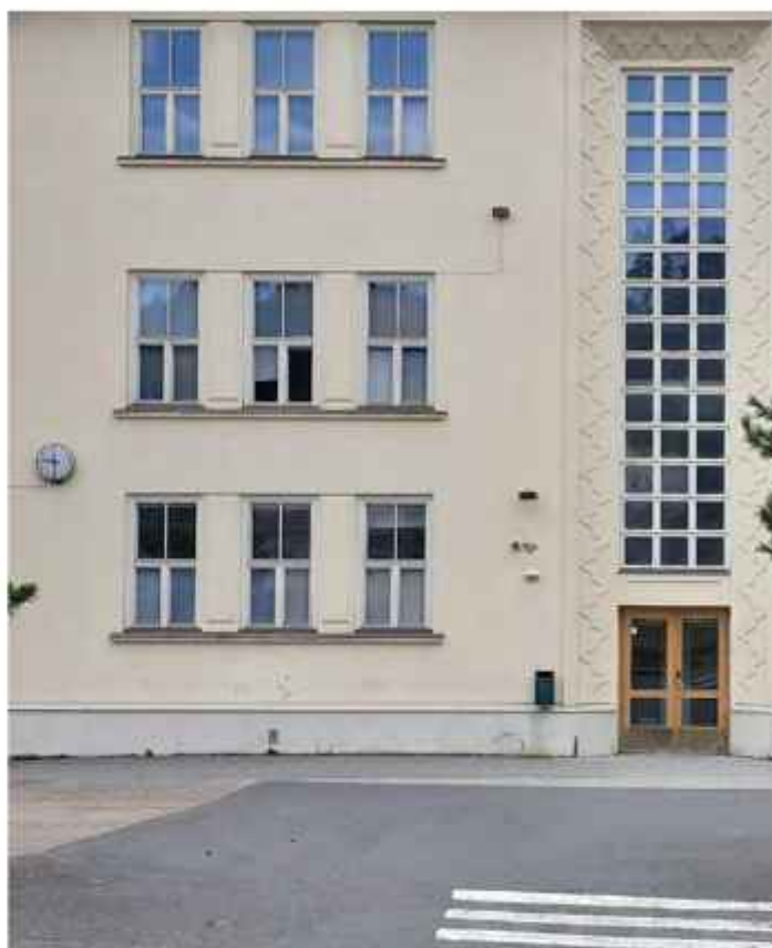
Luokkien ikkunat on toteutettu länsilukisivuun kolmen ryhminä. Ikkunoiden välissä kohopinta ja alla ulonnettu jalus. Laajennuksessa kellarin ikkunat on sovitettu ylempiin ikkunoihin. KS.
