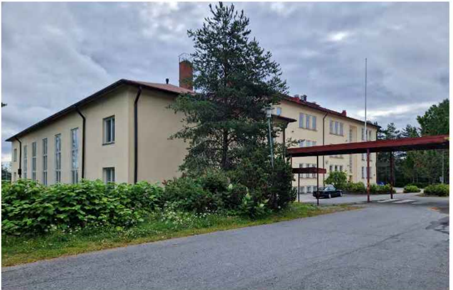
Liikuntasaliisiipi kuvattuna luoteesta. KS.
