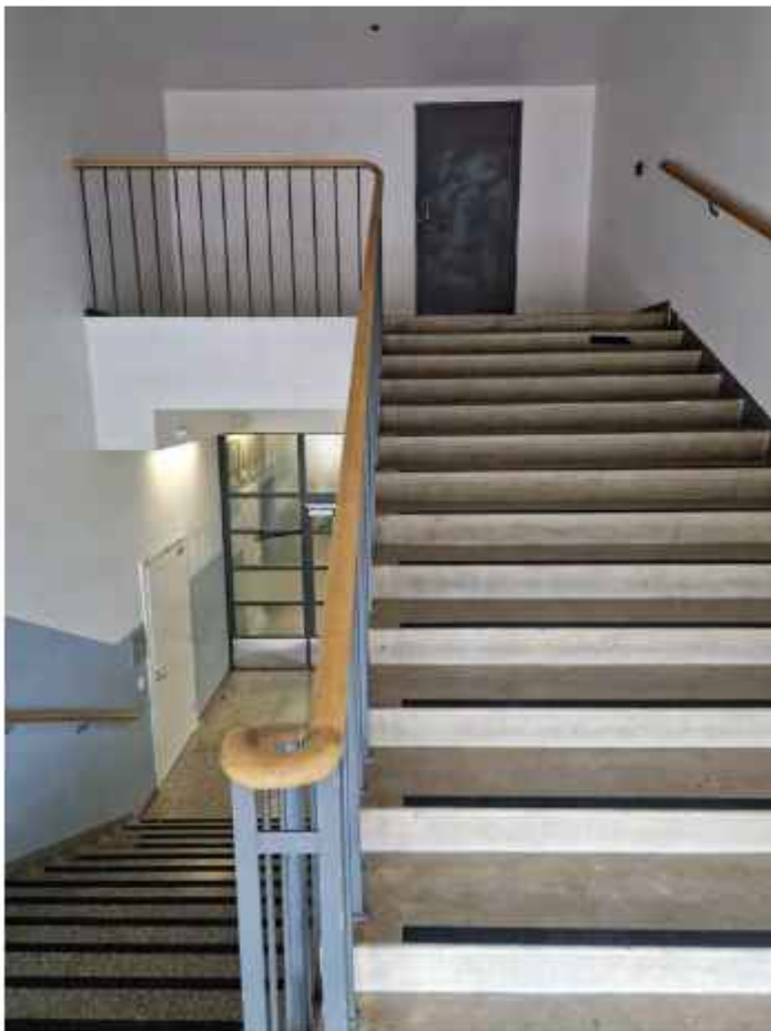
Vuonna 1955 valmistuneen laajennuksen ullakolle johtava porras. Yläpäässä vaatimattomampi askelmapinta viestii opetustilojen loppumisesta. Alhaalla näkyy osastoiva palolasiseinä. EK
