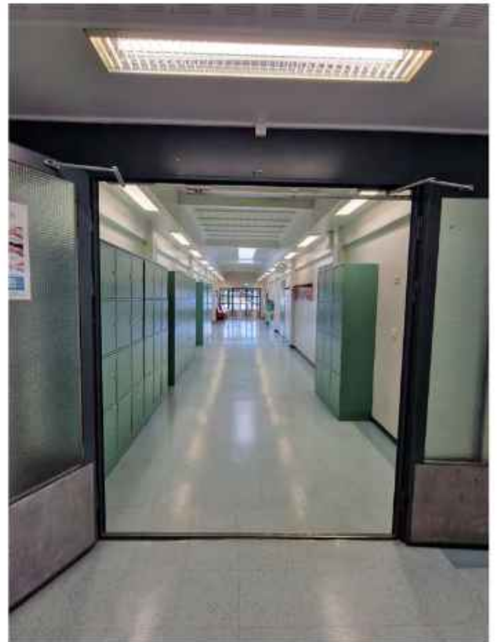
Keskikäytävä, jossa tummat alkuperäiset palo-ovet. Säilytyskaapit ovat uusia, samoin pintojen värityys on muuttunut alkuperäisestä. EK
