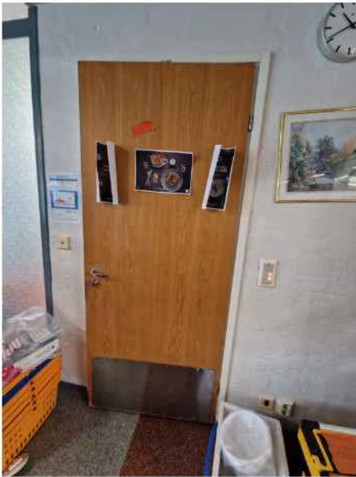
Alkuperäinen puuviiluovi ruokalassa. EK
