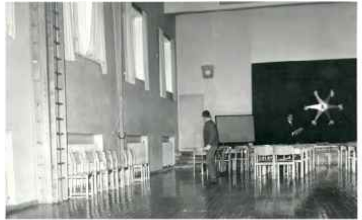
Laajennuksen liikuntasali pian valmistumisen jälkeen. Oriveden kunnan arkisto.
