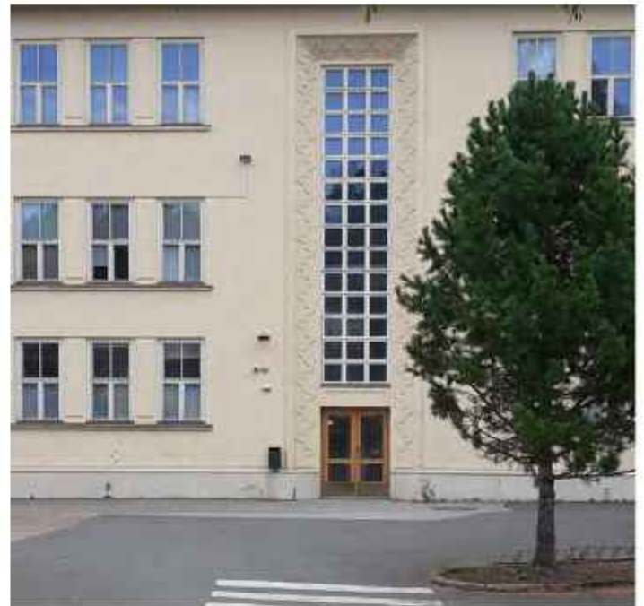
Sisäänkäyntisyvennyksen kohokuviointi ja alkuperäiset ikkunat, sekä luokkahuoneiden ikkunaryhmät länsijulkisivussa. KS.
