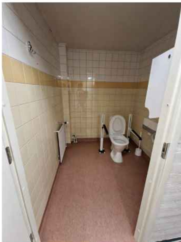
Rakennukseen on peruskorjauksen yhteydessä lisätty esteetön WC-tila. EK
