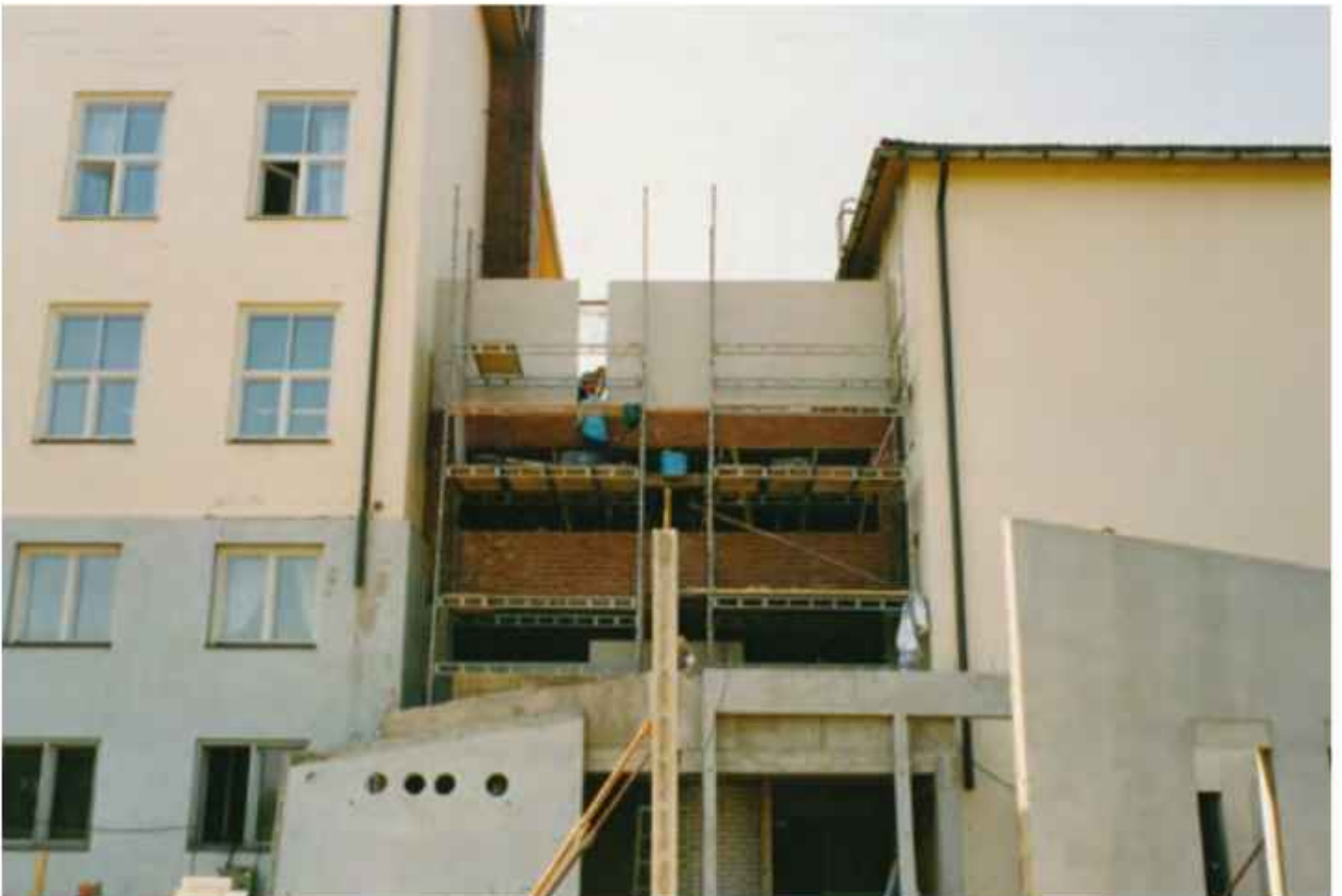
Lisäsiiven rakennustyömaa. Oriveden kunnan arkisto.
