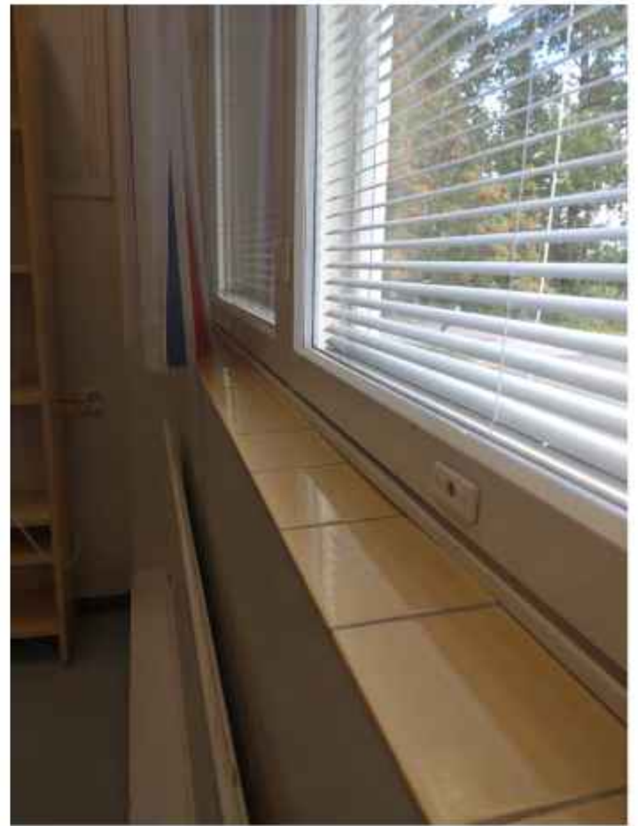
Osaan tiloista on vaihdettu ikkunalaudan kaakelointi. Uusissa reuna ei ole pyörästetty. KS
