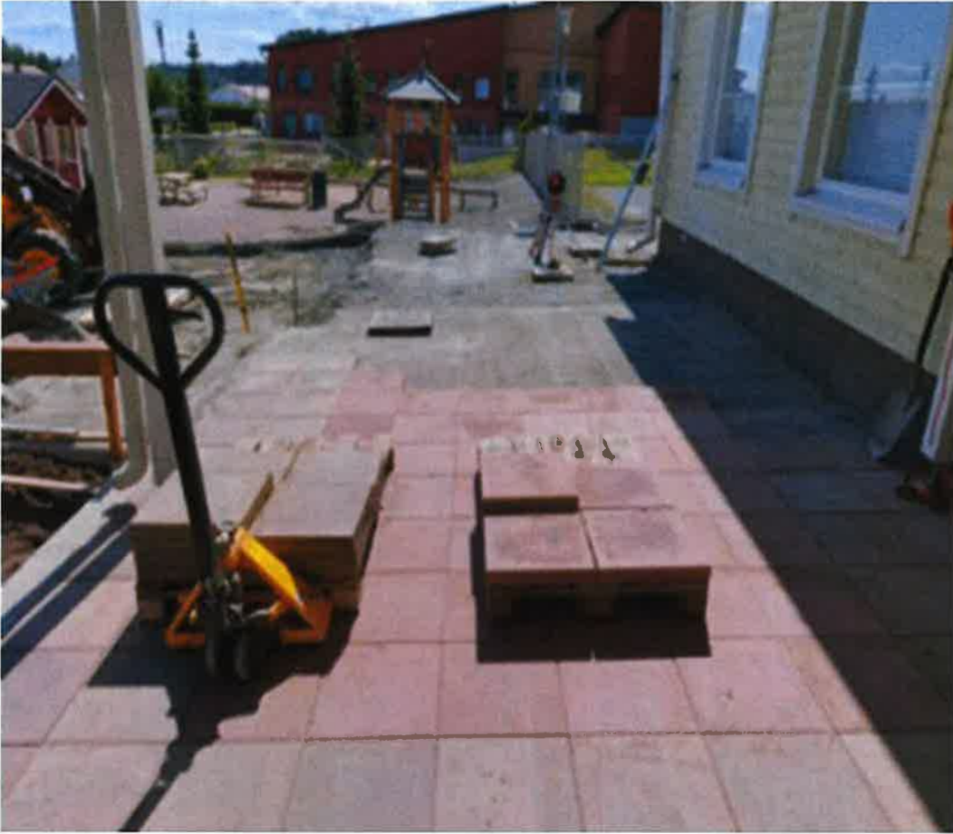
Vuokkokujan pihan korjausvaihe 1 toteutui kesällä 2023
