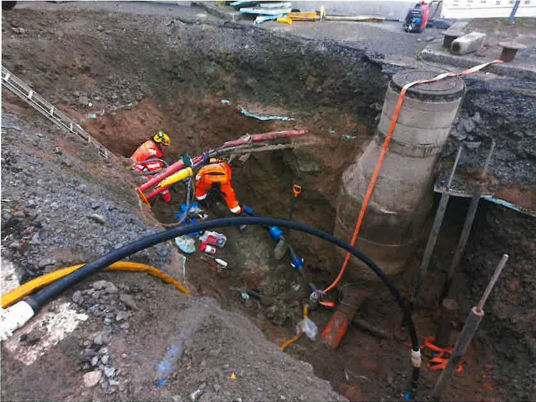
Vesijohtojen uusimista Koluntie - Urheilutie Ahtiantien liitoskohdassa
