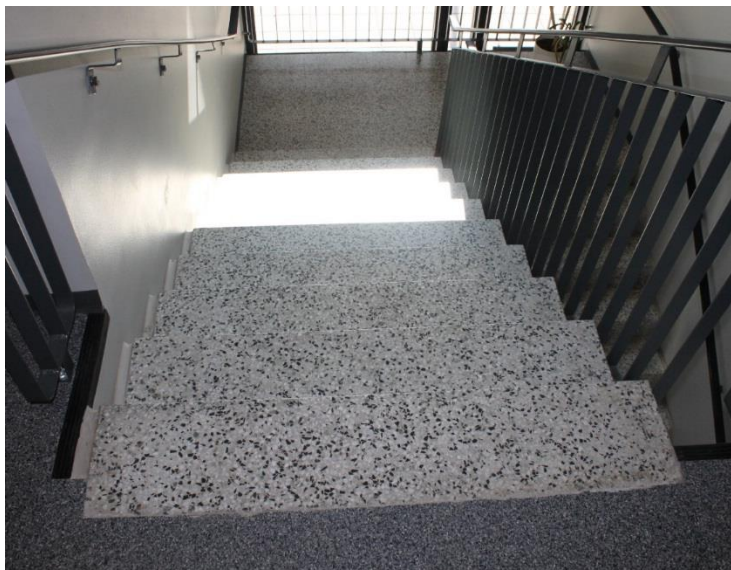
Kuva125. Portaiden alla on tila, jonne pääsee. Kulkuväylän yläpuolella portaiden rakenteiden takia korkeus ei ole riittävä. Ikkunasta muodostuu heijastusta portaisiin, mikä vaikeuttaa porraskaskelmien hahmottamista. Askelmista puuttuvat kontrastiraidat.
