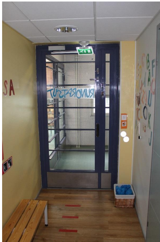
Kuva174. Kulkuväylillä on jonkin verran tavaraa. Portaikkoon johtavissa ovissa kahvat on sijoitettu korkealle turvallisuussyistä.
