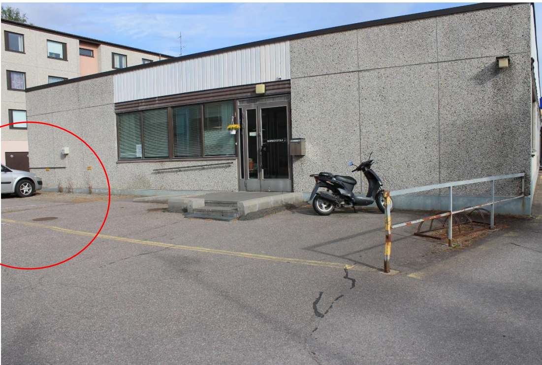
Kuva33. Piha-alueella ei ole liikuntaesteisille varattua autopaikkaa. Sisäänkäynnin vasemmalla puolella on kaksi autopaikkaa, jotka ovat tasaisia. LE-autopaikka voitaisiin sijoittaa esimerkiksi siihen.
