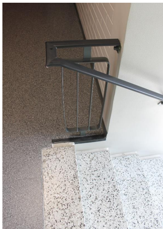
Kuva125. Portaiden alla on tila, jonne pääsee. Kulkuväylän yläpuolella portaiden rakenteiden takia korkeus ei ole riittävä. Ikkunasta muodostuu heijastusta portaisiin, mikä vaikeuttaa porraskaskelmien hahmottamista. Askelmista puuttuvat kontrastiraidat.
