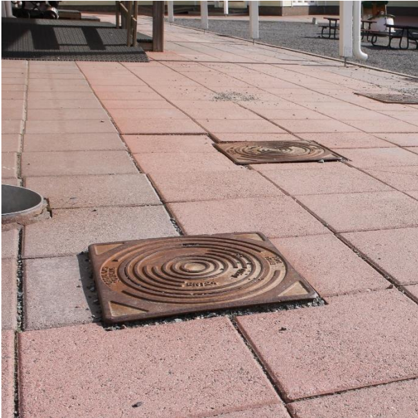
Kuva 102. Laatoitus viettää alaspäin rakennuksen seinustalta, jolloin kulkuväylä ei ole tasainen. Laatoituksen kohdalla on kaivonkansia. Piha-alueella on laatoitus. Laatan päälle pääsee helposti hiekkaa, mikä voi tehdä laatoituksesta liukkaan.
