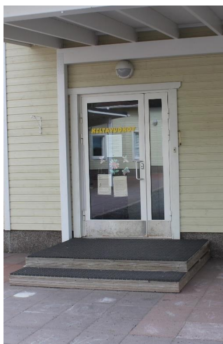
Kuva 104. Portaiden yhteydestä puuttuvat käsijohteet. Tasanteiden reunoista puuttuvat kaiteet, jotka estävät putoamisen (korkeusero ei ole suuri, mutta pienelle lapselle hankala).
