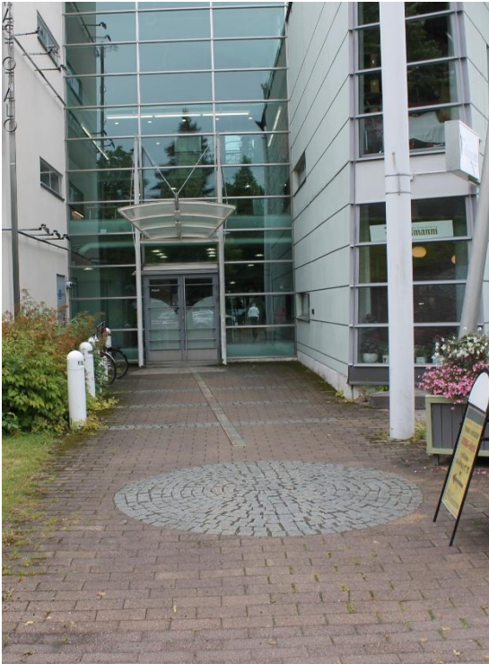
Kuva171. Orivesi-talon sisääkäynnillä on liian korkea kynnyks ja tuulikaappi on ahdas.
