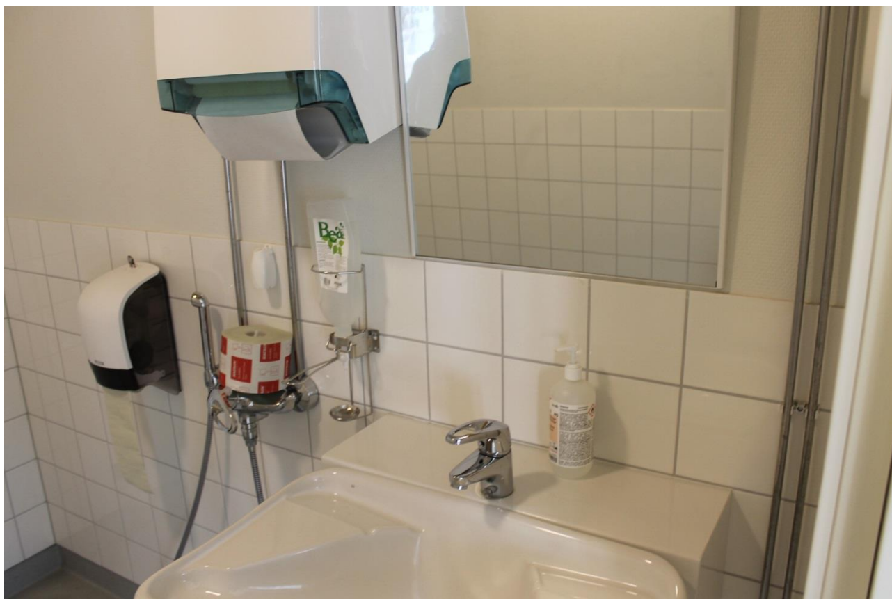
Kuva110. Peili on sijoitettu liian korkealle.
