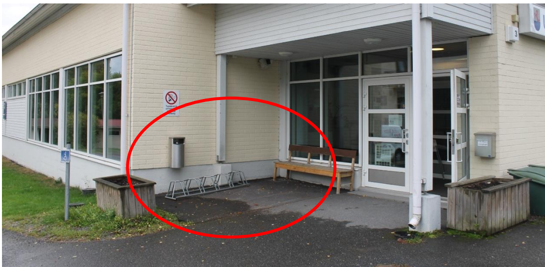
Kuva64. Katoksen edustalle sijoitettu pyöräteline voi estää katoksessa olevan penkin käyttöä.
