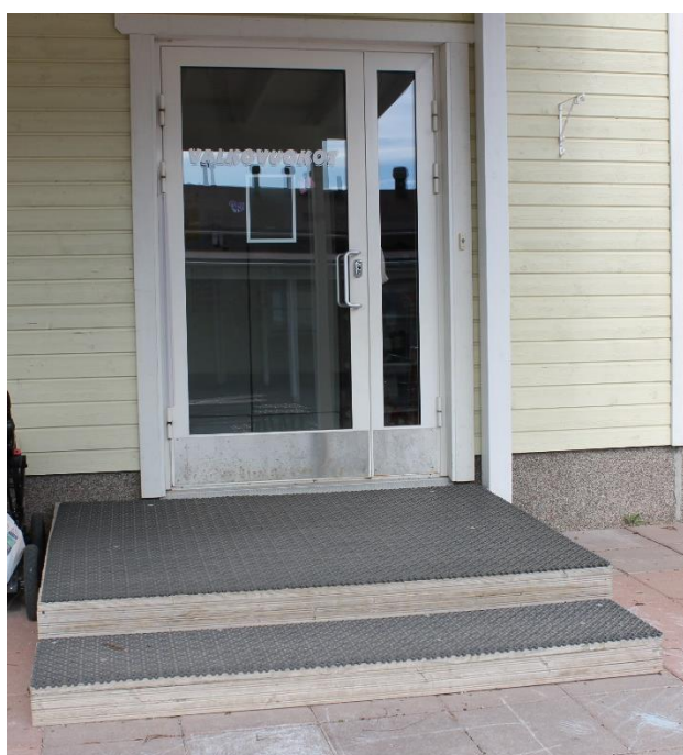
Kuva 104. Portaiden yhteydestä puuttuvat käsijohteet. Tasanteiden reunoista puuttuvat kaiteet, jotka estävät putoamisen (korkeusero ei ole suuri, mutta pienelle lapselle hankala).
