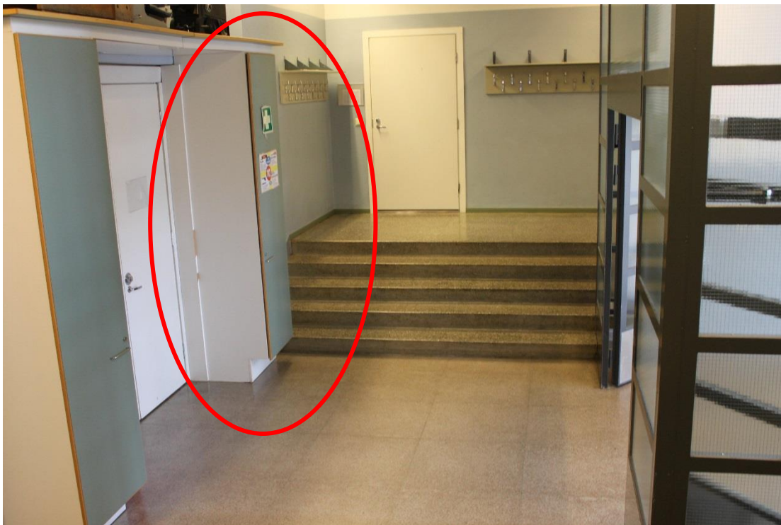
Kuva 87. Pieneen liikuntasaliin tai kuvan luokkahuoneeseen ei ole esteetöntä pääsyä. Portaista puuttuu käsijohteet ja kaluste on sijoitettu suoraan portaan eteen.
