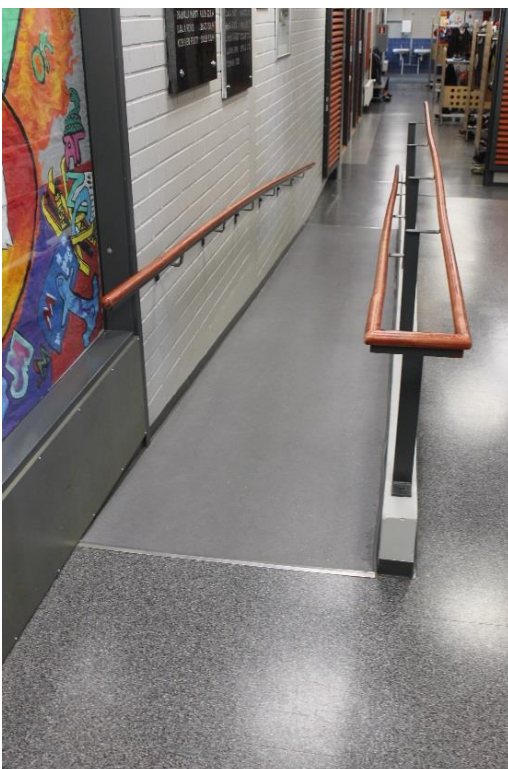
Kuvat. Luiskan alkamis- ja päättymiskohta ei erotu kontrastina. Käsijohteen päätä ei ole käännetty. Käsijohteen tuki on kaukana, jolloin käsijohteessa on pitkä uloke, joka voi aiheuttaa takertumisvaaraa.
