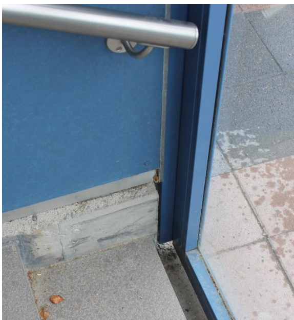
Kuvat. Käsijohde päättyy viimeisen portaan kohdalle. Portaan päättymiskohdassa on kuitenkin portti, joka rajoittaa käsijohdetta. Opaste on sijoitettu suoraan lasipintaan, josta sitä voi olla hankala hahmottaa.
