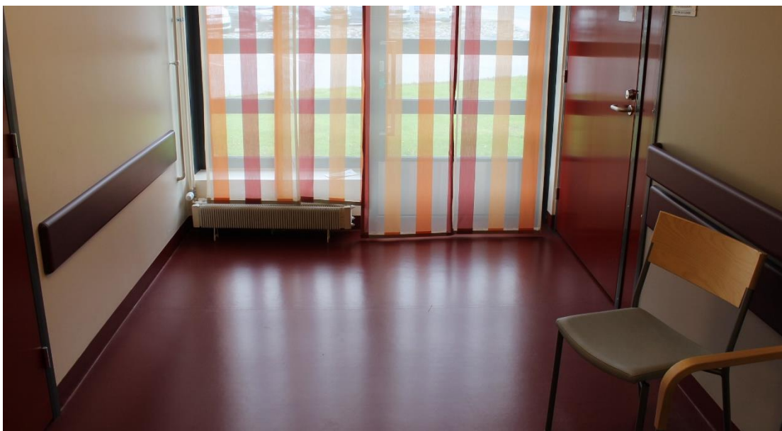
Kuva 25. Käytävien lattiaan tulee paikoittain voimakasta heijastusta.
