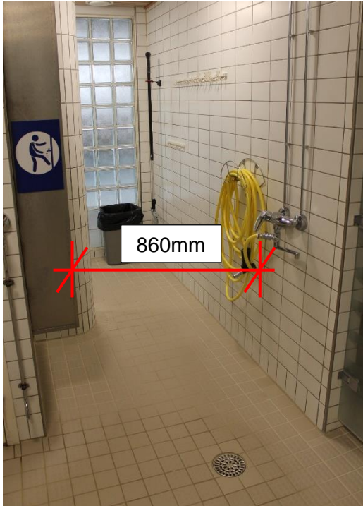
Kuva75. Lokerikot vähentävät vapaata tilaa ja kulkuvälien leveyttä. Naisten puolella kulkuväylän ve- ressä olevaan hanaan törmää helposti, kun kulkuväylä on kapea.
