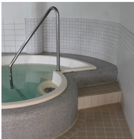
Kuva76. Porealtaan portaiden yhteydestä puuttuu käsijohde toiselta puolelta. Terapia-altaan portaista puuttuu käsijohteet alimmalta porrassanteelta.
