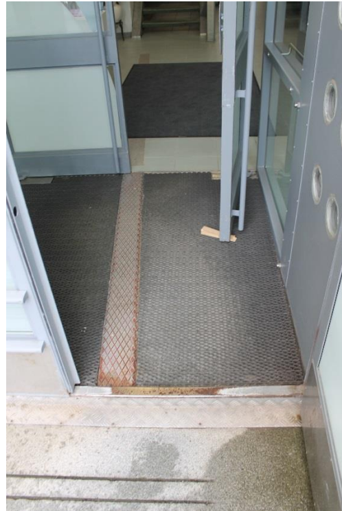
Kuva171. Orivesi-talon sisääkäynnillä on liian korkea kynnyks ja tuulikaappi on ahdas.
