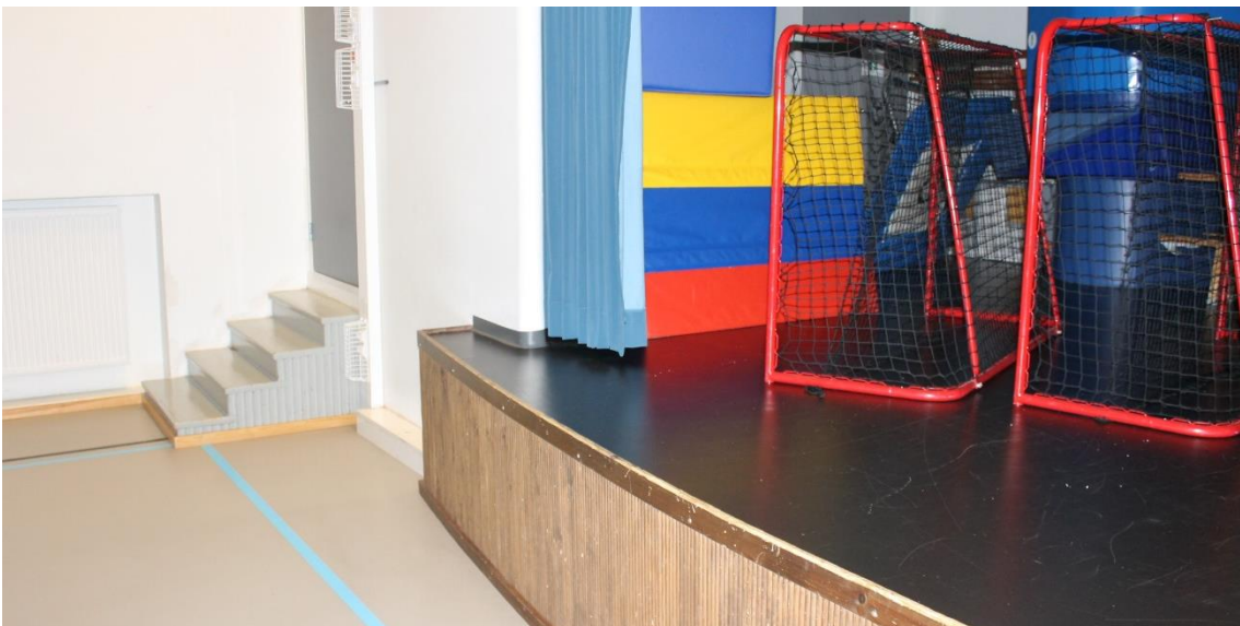
Kuva139. Liikuntasalissa olevista portaista puuttuvat käsijohteet. Lavalle ei ole esteetöntä kulkua.
