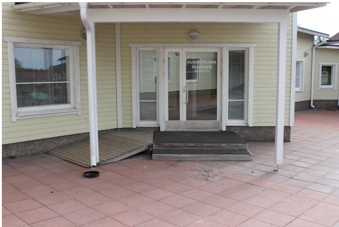
Kuva105. Luiskan ja portaiden yhteydestä puuttuvat käsijohteet.
