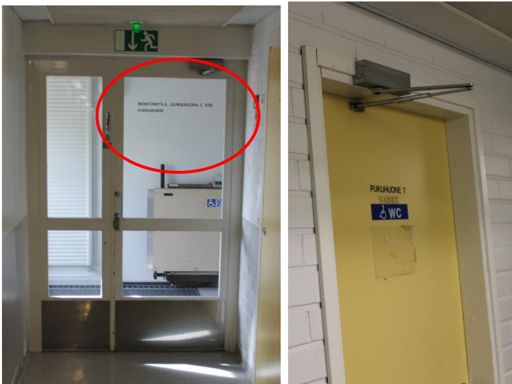
Kuva51. Opasteita on sijoitettu suoraan oviin. Lasipintaan sijoitettu opaste erottuu valkoista taustaa vasten. Pukuhuoneen oveen on sijoitettu opaste. Ovi avautuu sisäänpäin, joten törmäysvaaraa ei välttämättä synny.
