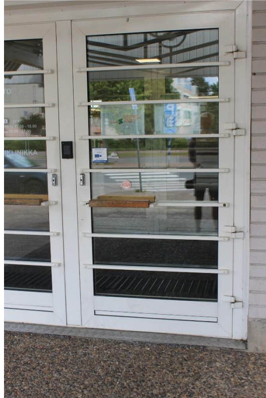
Kuva3. Suoraan lasiin sijoitettuja opastetekstejä on hankala hahmottaa. Automaattisesti avautuvaan oveen sijoitettuja opasteita ei pääse lukemaan läheltä.
