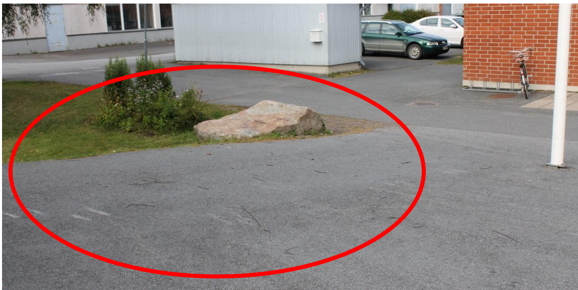
Kuva113. Piha viettää sisäänkäynnille päin. Kulkuväylän sivuun sijoitettu käsijohde voisi tarvittaessa auttaa liikkumisessa sisäänkäynniltä parkkipaikalle talvisin liukkaalla sekä mikäli kulkuväylä on liian jyrkkä kulkea.
