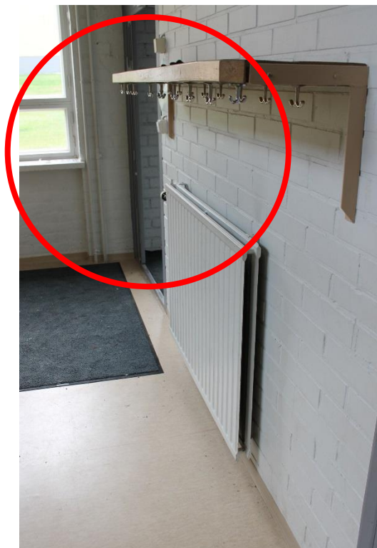
Kuva141. Sisäänkäynnin yhteydessä tasanteelta puuttuu putoamista ehkäisevä kaide. Sisääntuloau- lassa on naulakko, joka aiheuttaa törmäysvaaraa.
