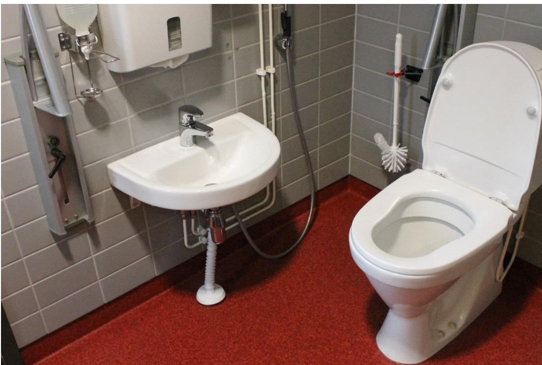
Kuva 32. Wc-istuimen vasemmalle puolelle ei jää vapaata tilaa. Istuimen viereen on sijoitettu matala allas sekä bideesuihku.
