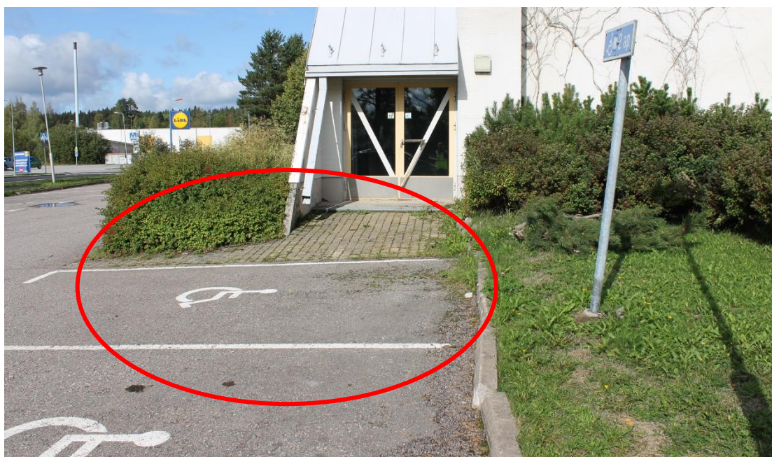
Kuva48. Kulkuväylä jää liian kapeaksi, mikäli LE-autopaikalle on ajettu auto.
