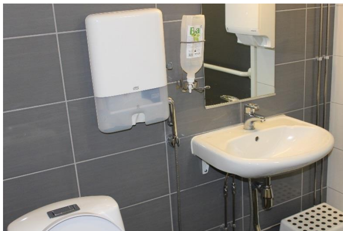
Kuva146. Esteettömän wc-tilan opasteessa on mainittu, että wc on käytettävissä molemmin puolelta. Bidee-suihku jää wc-istuimen taakse.
