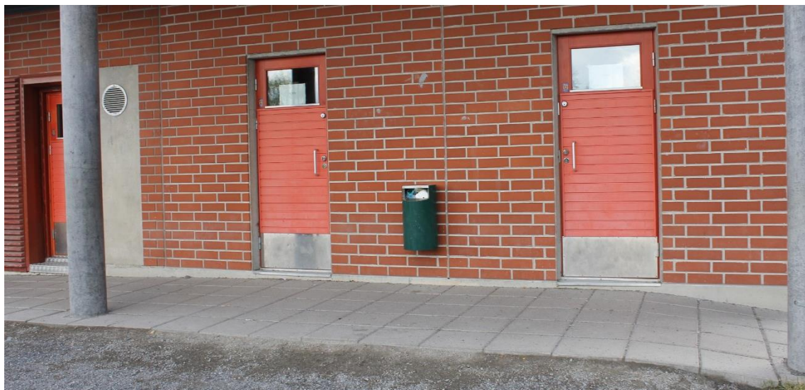
Kuva123. Pukuhuoneisiin on käynti ulkokautta. Opasteet on sijoitettu liian korkealle ja lasin taakse sijoitettua opastetta voi olla hankala lukea.
