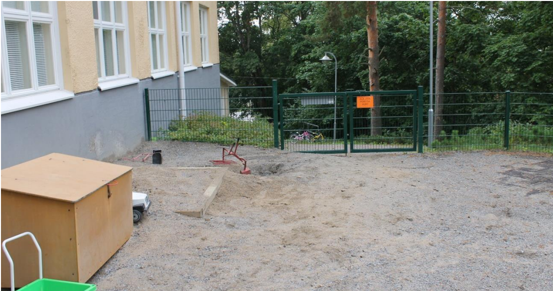
Kuva130. Hiekkalaatikon vieressä on kaivettu maata kaivurilla. Kuoppa on kulkuväylän sivussa, mutta sitä ei ole rajattu kulkuväylästä.
