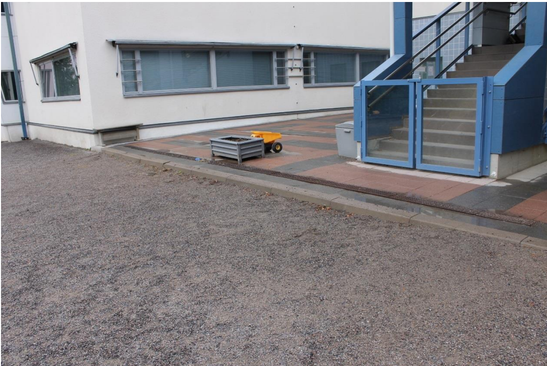
Kuva168. Tasanteen ja hiekoituksen väliin jää pieni tasoero. Kuvan oikeassa reunassa alkaa kulkuväylä alakerran sisäänkäynnille. Tällä kohtaa hiekkaa on enemmän, jolloin tasoero on pienempi.
