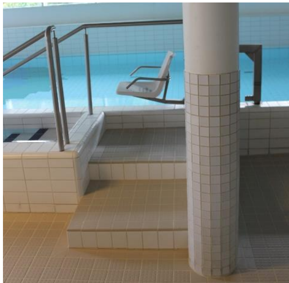
Kuva76. Porealtaan portaiden yhteydestä puuttuu käsijohde toiselta puolelta. Terapia-altaan portaista puuttuu käsijohteet alimmalta porrassanteelta.
