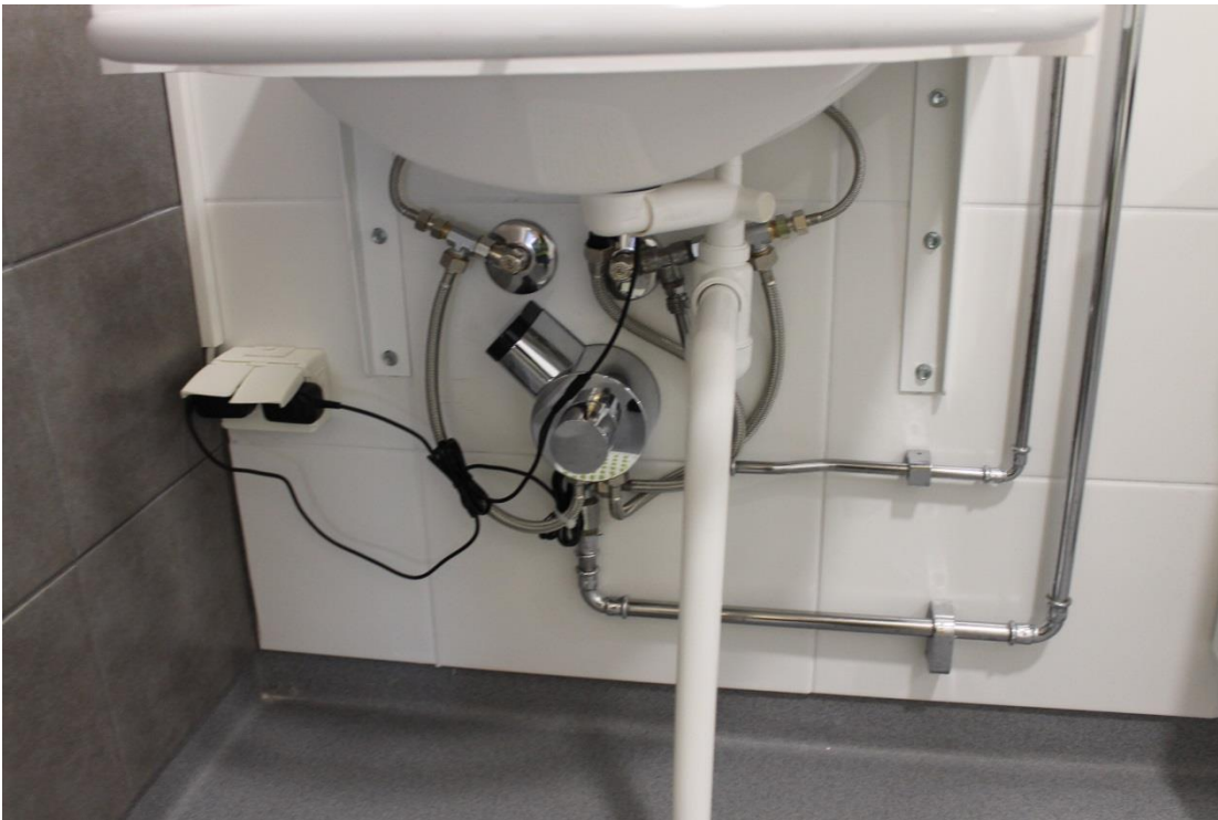
Kuva164. Altaan säätölaitteet ovat näkyvissä altaan alla, jolloin lapset pääsevät säätämään niitä. Altaan poistoputki vähentää vapaata tilaa altaan alla.
