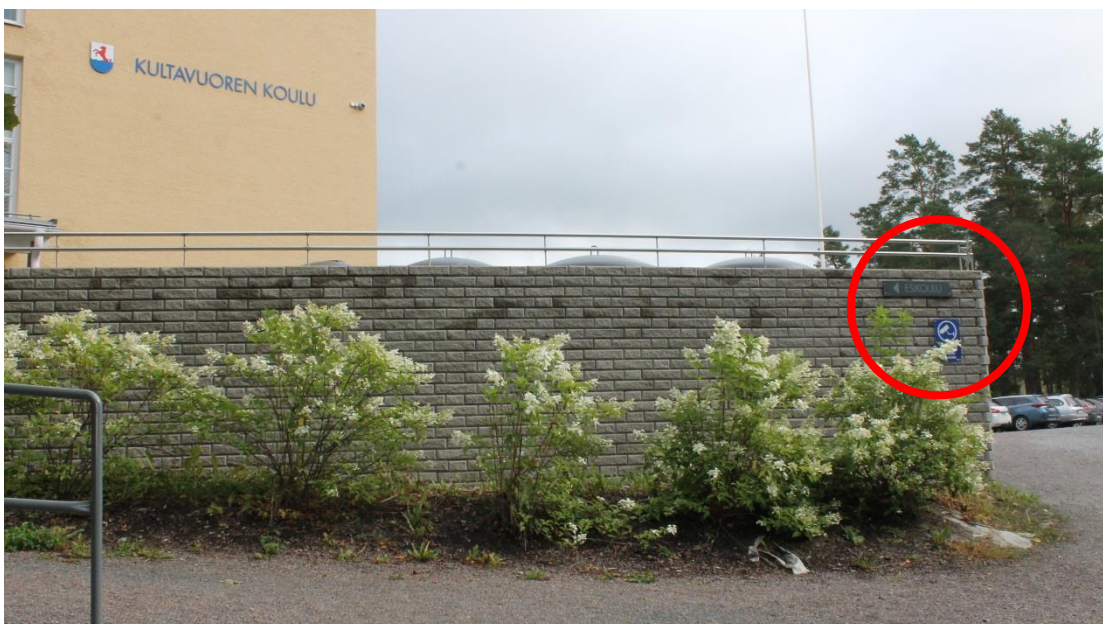
Kuva. Koulun opaste on rakennuksen seinässä. Esikouluun on opaste muurissa.
