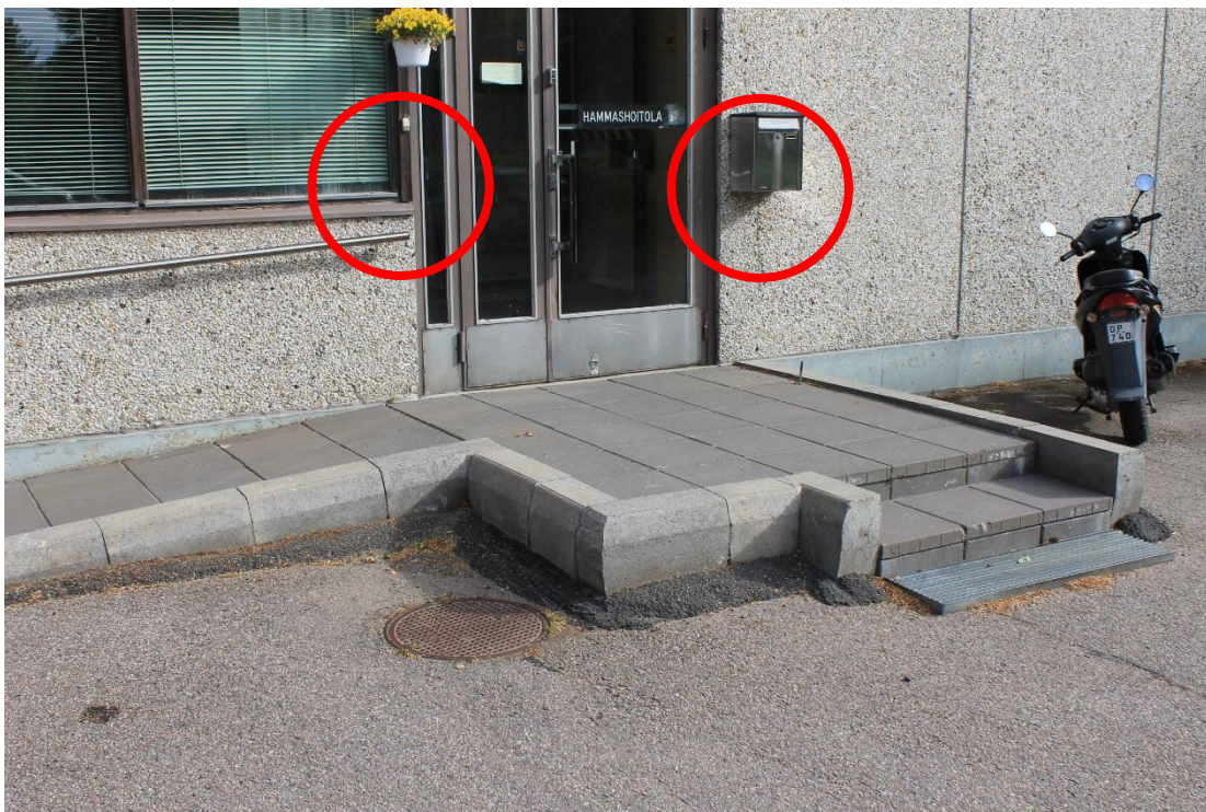
Kuva 36. Ovikello on sijoitettu oven viereen seinään. Ovikello on luiskan kohdalla, mikä vaikeuttaa ovikellon soittamista. Postilaatikko on seinässä tasanteen ulkopuolella, postilaatikkoon voi olla vaikea ulottua.
