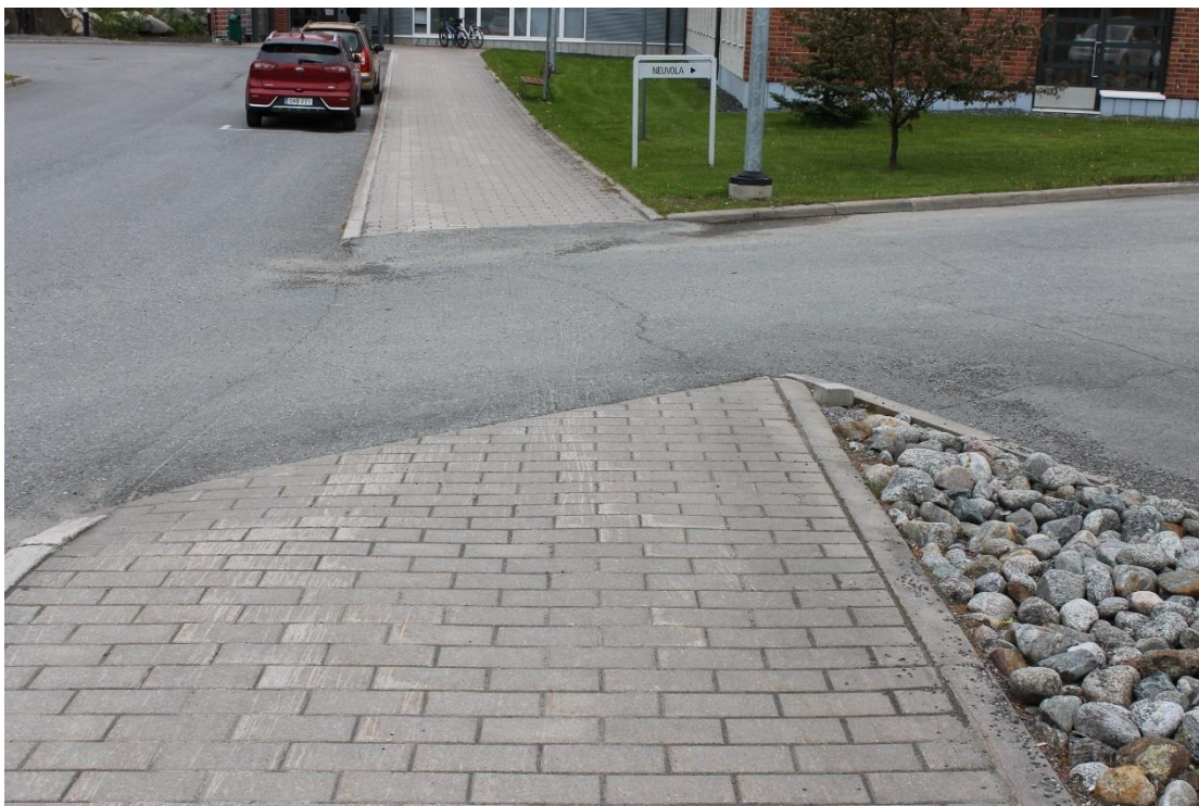
Kuva 23. Suojatie puuttuu. Ajoradan viereen on sijoitettu LE-autopaikat. Reunakivetystä ei ole luis-kattu paikkojen vierestä.
