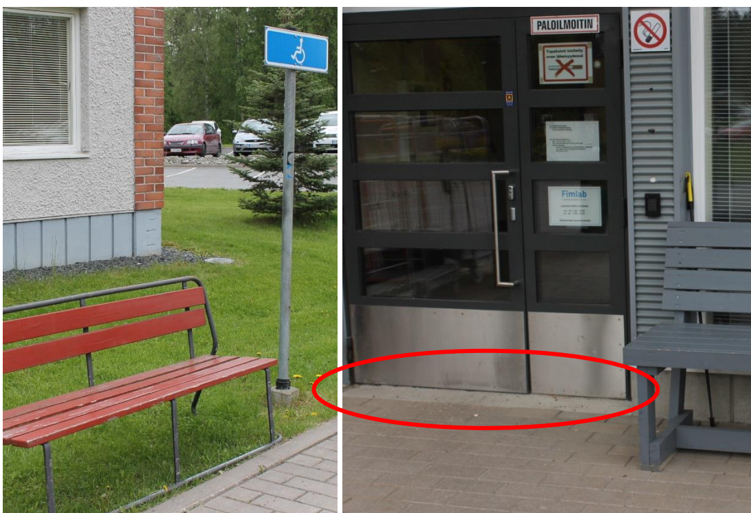
Kuva. Opasteesta puuttuu LE-autopaikkojen määrä. LE-autopaikkojen viereen sekä sisäänkäynnille on sijoitettu penkit. Pääsisäänkäynnin edessä on pieni tasoero/epätasaisuus oven edessä, mikä hankaloittaa ovesta kulkemista erityisesti pienipyörällisen apuvälineen tai parien kanssa.
