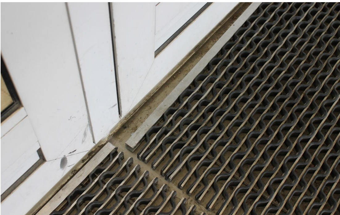
Kuva4. Tuulikaapin matto oli huonosti paikallaan.
