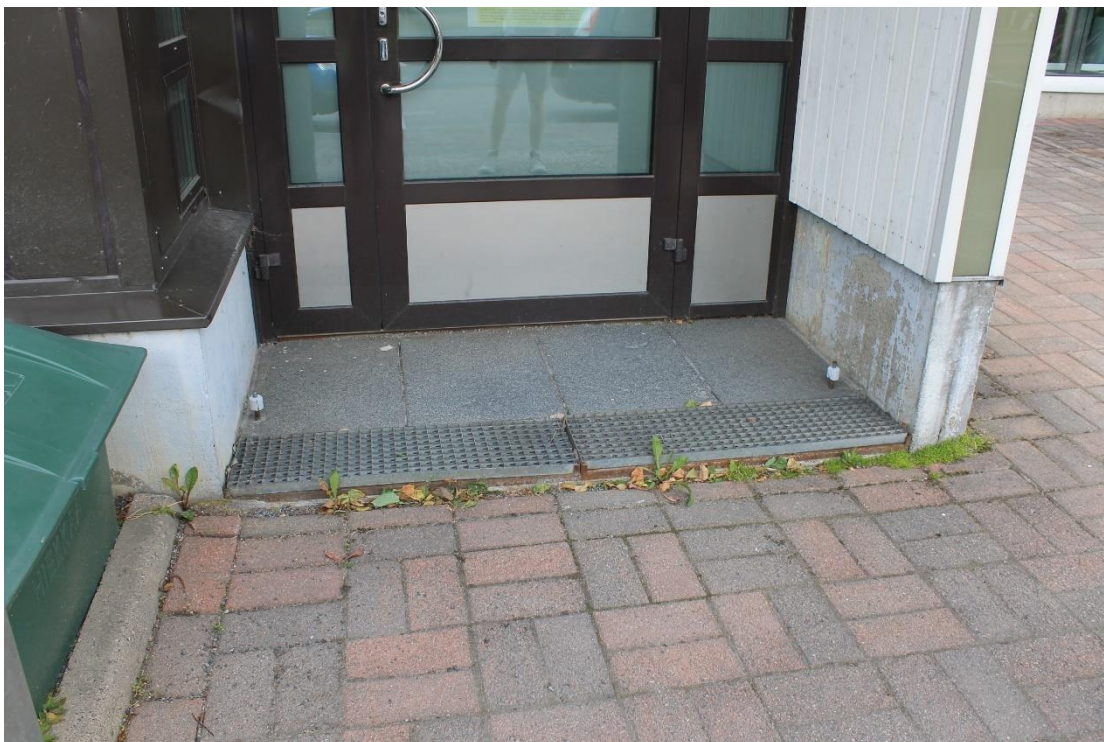
Kuva12. Asumispalveluiden sisäänkäynnin yhteydessä on korkea tasoero.
