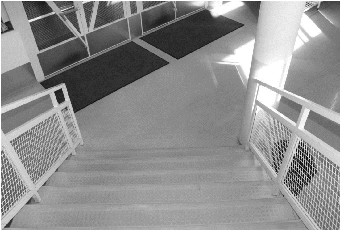
Kuva60. Porraskelmat eivät erotu kontrastina toisistaan mustavalkokuvassa.
