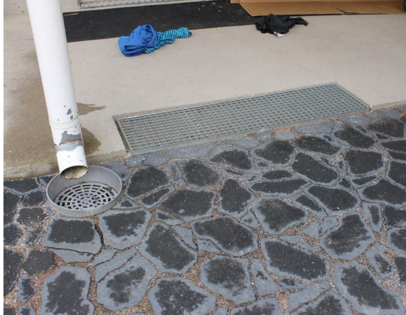
Kuva154. Opaste on sijoitettu suoraan oveen. Tekstiin muodostuu heijastusta. Ulko-oven edustalla on tasanne. Tasoero ritilän kohdalla on hieman liian suuri.
