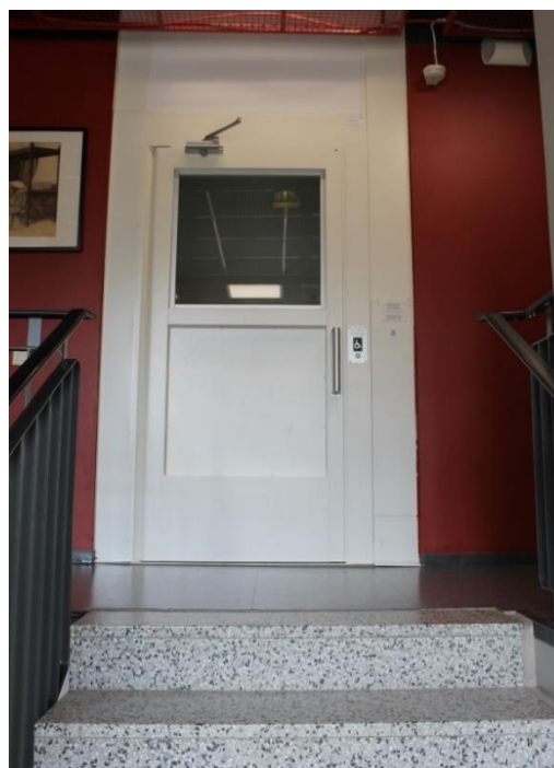
Kuva127. Ylhäällä hissien ovi sijaitsee yläkerrassa portaita vastapäätä. Hissistä joutuu peruuttamaan pois, jolloin portaat voivat aiheuttaa putoamisvaaran.
