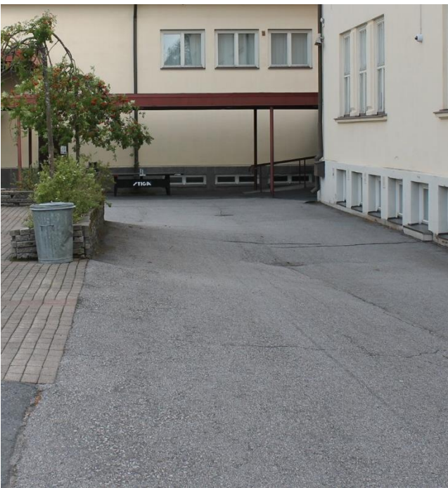
Kuva79. Piha-alueen profiili on paikoittain kalteva. Kaltevuutta on kulkuväylillä myös sivusuunnassa. Kaivon kansi on painunut, ero on liian suuri.
