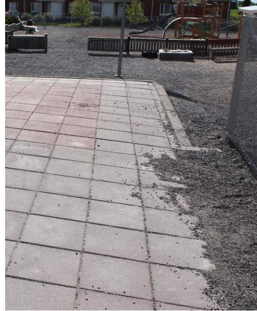
Kuva 102. Laatoitus viettää alaspäin rakennuksen seinustalta, jolloin kulkuväylä ei ole tasainen. Laatoituksen kohdalla on kaivonkansia. Piha-alueella on laatoitus. Laatan päälle pääsee helposti hiekkaa, mikä voi tehdä laatoituksesta liukkaan.
