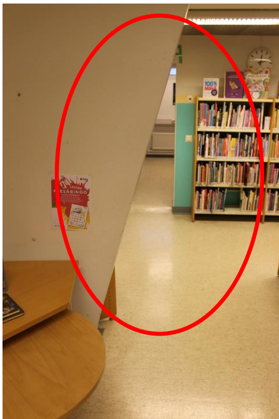
Kuva14. Kirjastossa kulkuväylällä on vino rakenne, jota voi olla hankala hahmottaa ja joka voi aiheuttaa törmäysvaaran.
