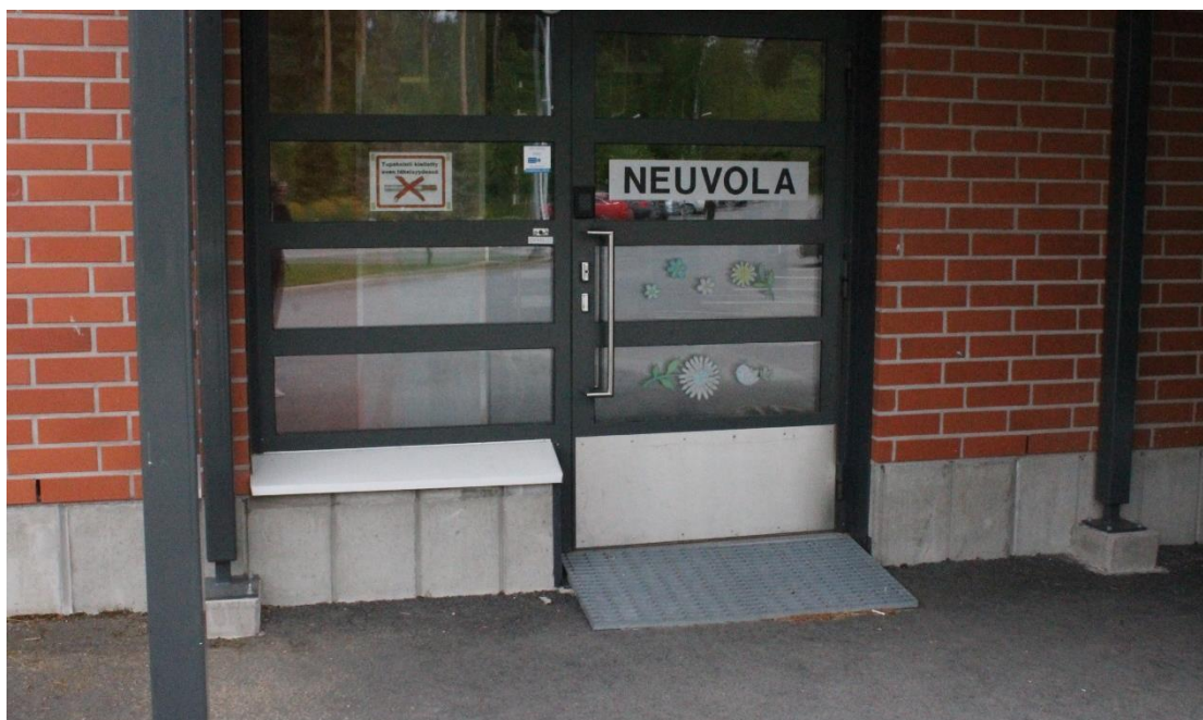
Kuva 29. Sisäänkäynnin edustalla oleva kynnyksen luiskaus on liian jyrkkä.
