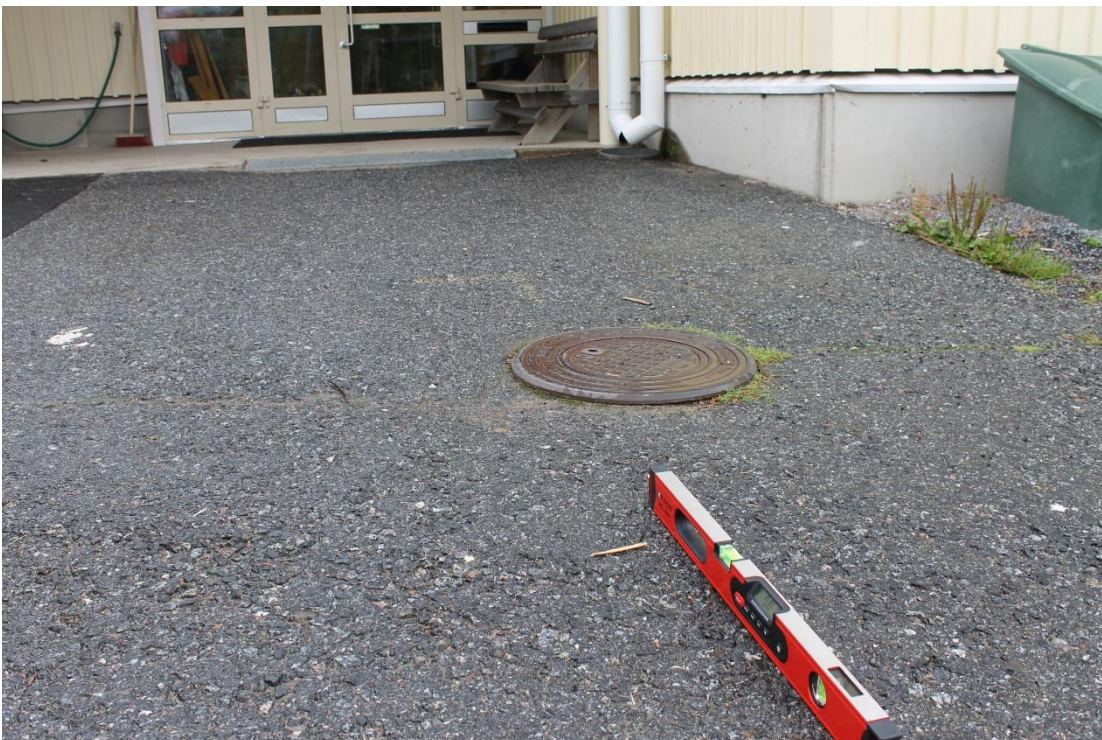
Kuva152. Kulkuväylä nousee sisäänkäynnille päin.
