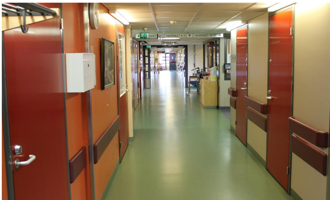
Kuva 28. Käsijohteet on sijoitettu vain toiselle puolelle käytävää. Käytävän päästä tulee voimakasta heijastusta lattiaan.
