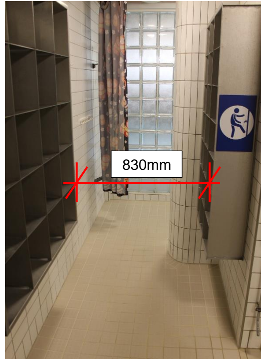
Kuva75. Lokerikot vähentävät vapaata tilaa ja kulkuvälien leveyttä. Naisten puolella kulkuväylän ve- ressä olevaan hanaan törmää helposti, kun kulkuväylä on kapea.
