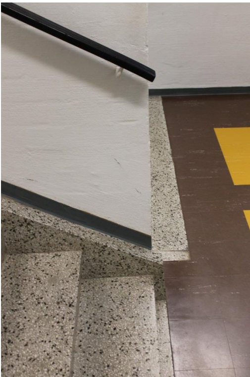
Kuva 98. Käsijohde päättyy liian aikaisin ensimmäisen portaan kohdalla. Portaiden kontrasti on huono.
