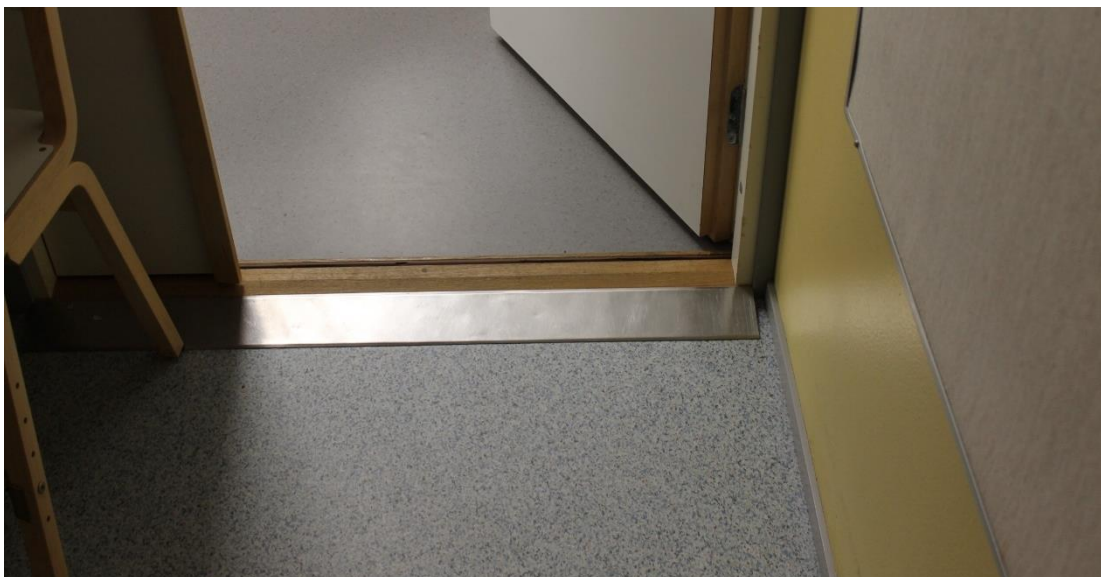
Kuva175. Ruokalaan johtava ovi on liian kapea. Oven kynnyks on luiskattu.
