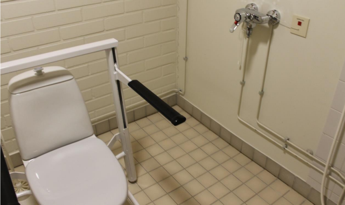
Kuva61. Bideen hana seinässä vähentää vapaata tilaa wc-istuimen oikealla puolella. Hätkäksunaru on nostettu hanan päälle ja naruun ei ulotu.
