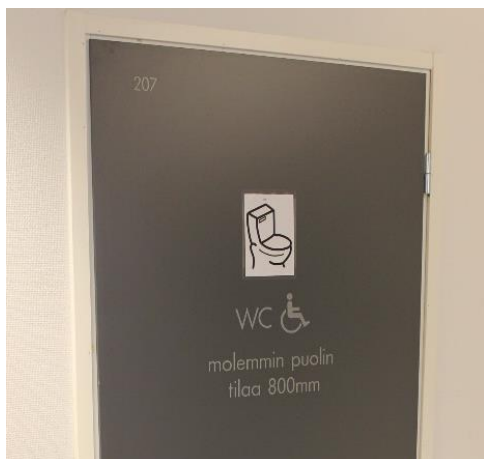
Kuva146. Esteettömän wc-tilan opasteessa on mainittu, että wc on käytettävissä molemmin puolelta. Bidee-suihku jää wc-istuimen taakse.
