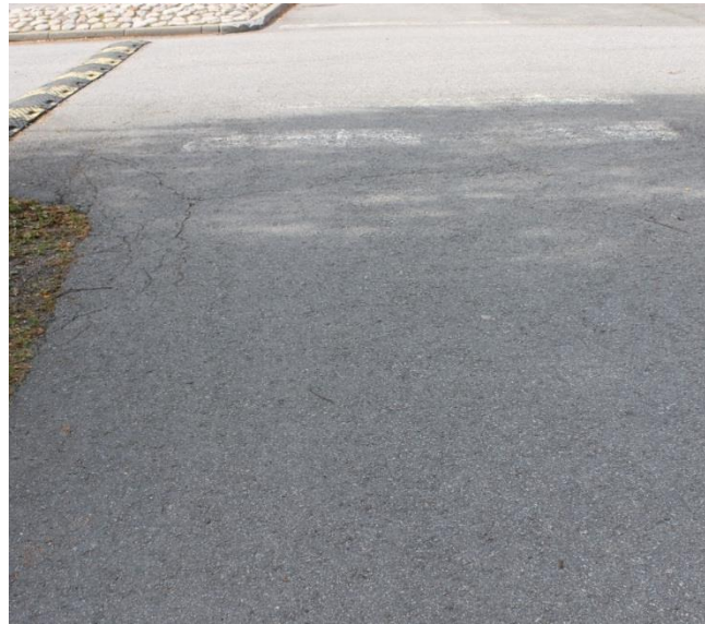
Kuva115. Hiekkaa on päässyt asfaltin päälle ja kulkuväylä voi olla liukas. Suojatien maalaukset ovat kuluneet.
