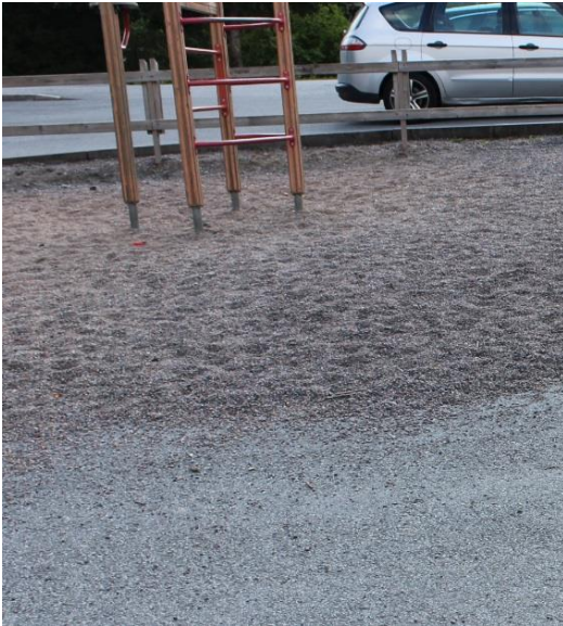
Kuva115. Hiekkaa on päässyt asfaltin päälle ja kulkuväylä voi olla liukas. Suojatien maalaukset ovat kuluneet.
