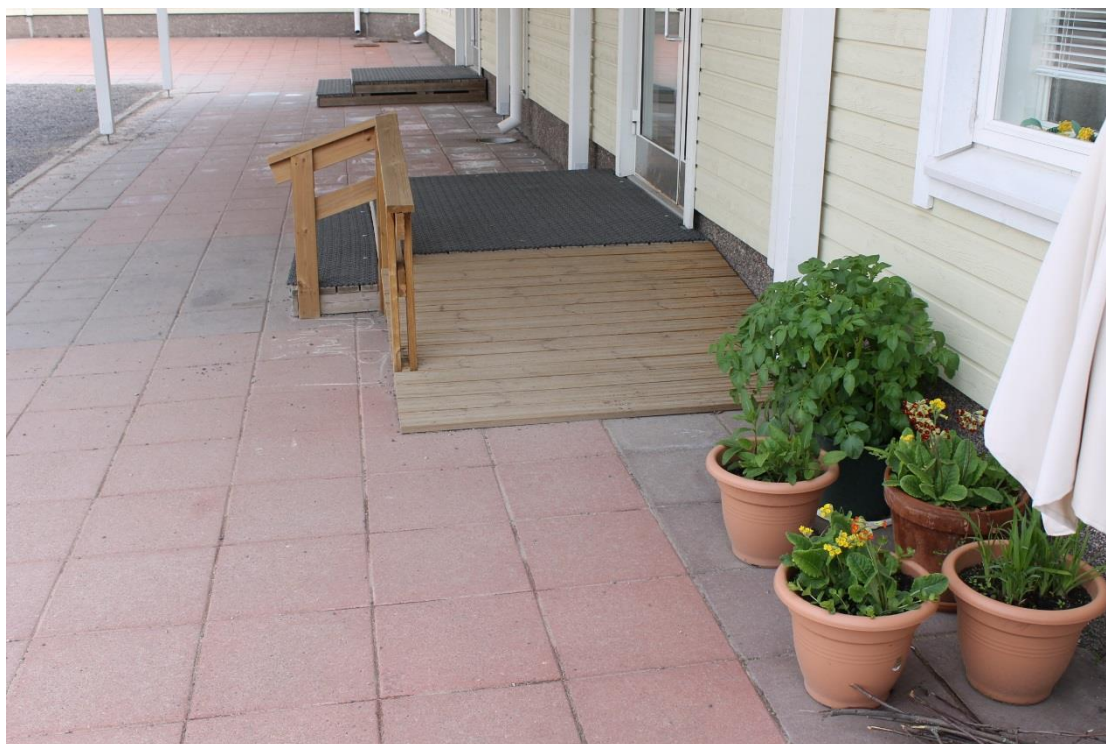
Kuva 106. Luiskan alkupäähän on sijoitettu ruukkuja, jotka ovat osittain kulkuväylällä. Käsijohde on liian lyhyt.
