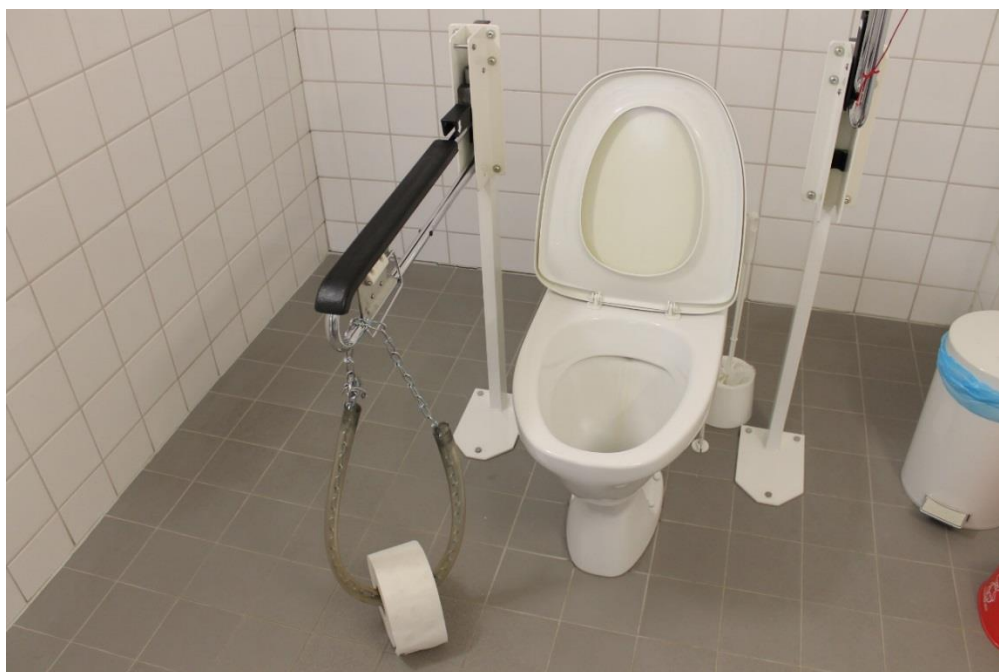
Kuva6. Wc-paperi on sijoitettu painavalla ketjulla käsitukeen. Hälytysjärjestelmän naru oli solmittu toiselle puolelle käsitukeen.
