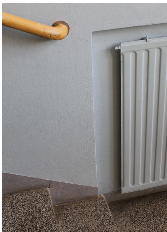
Kuva 89. Käsijohteet päättyvät liian aikaisin. Käsijohteen pitää ulottua 300mm yli portaan alkamis- ja päättymiskohdan.
