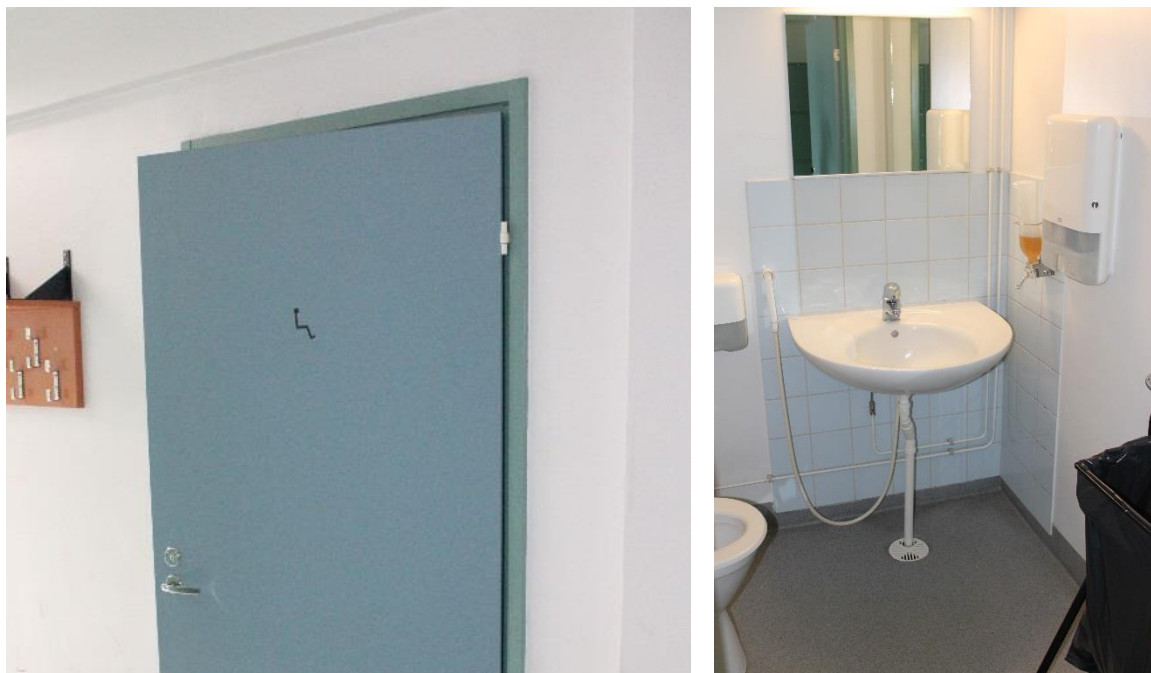
Kuva 99. Opaste on kulunut. Peili on sijoitettu liian korkealle.
