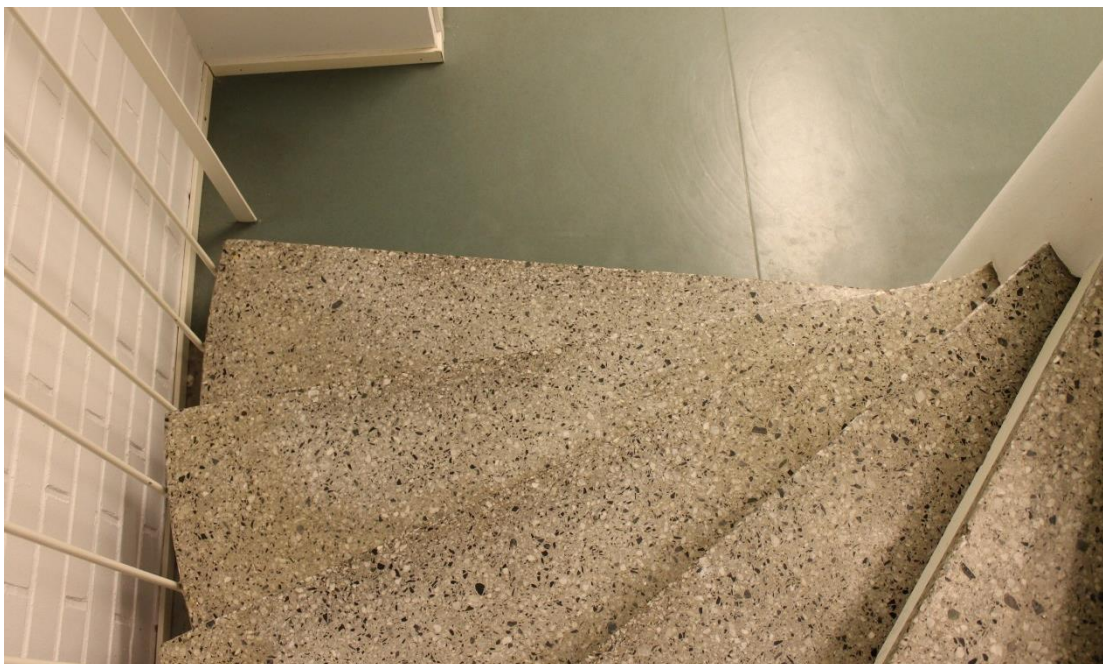
Kuva70. Porrasaskelmat eivät erotu kontrastina.
