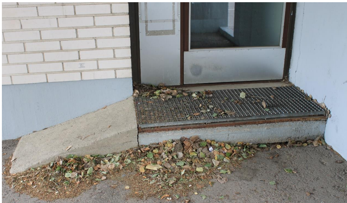
Kuva15. Kirjaston palautusluukulle ei ole esteetöntä pääsyä. Tasanne ja luiska ovat liian pienet.
