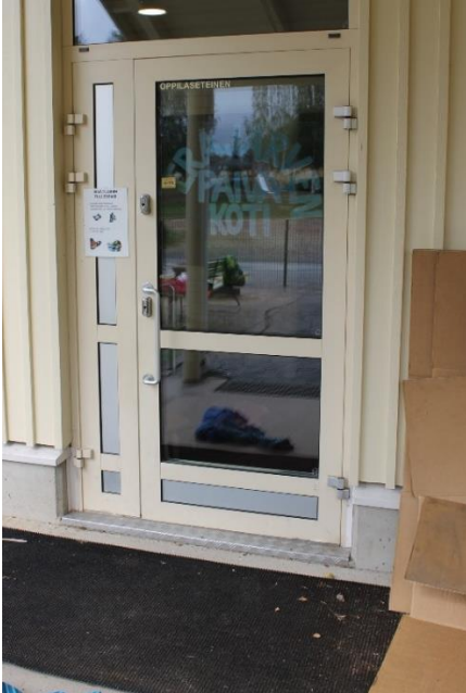
Kuva154. Opaste on sijoitettu suoraan oveen. Tekstiin muodostuu heijastusta. Ulko-oven edustalla on tasanne. Tasoero ritilän kohdalla on hieman liian suuri.
