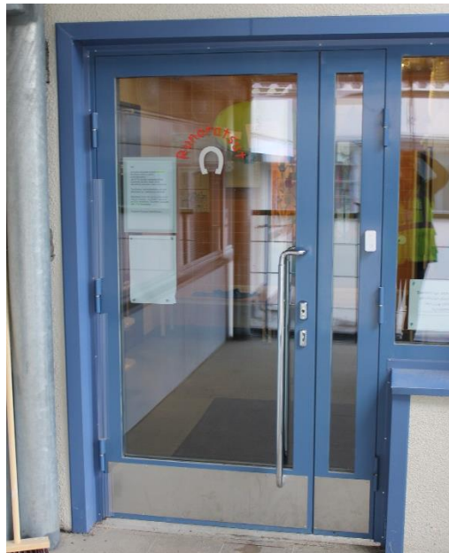
Kuvat. Käsijohde päättyy viimeisen portaan kohdalle. Portaan päättymiskohdassa on kuitenkin portti, joka rajoittaa käsijohdetta. Opaste on sijoitettu suoraan lasipintaan, josta sitä voi olla hankala hahmottaa.
