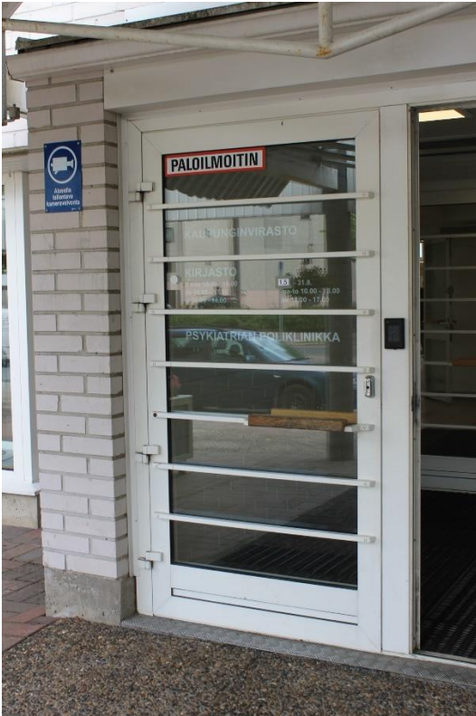
Kuva3. Suoraan lasiin sijoitettuja opastetekstejä on hankala hahmottaa. Automaattisesti avautuvaan oveen sijoitettuja opasteita ei pääse lukemaan läheltä.
