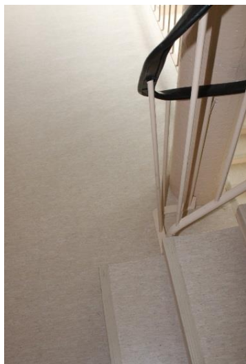
Kuva145. Käsijohde päättyy liian aikaisin portaan alkamiskohdassa. Portaista puuttuvat kontrastiraidat.
