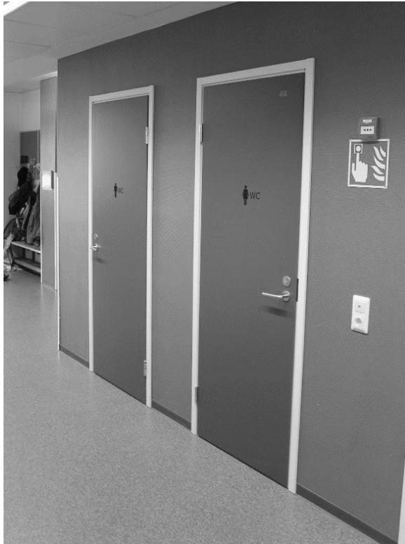
Kuva136. Matalalle sijoitettu naulakko. Ovet erottuvat kontrastina.
