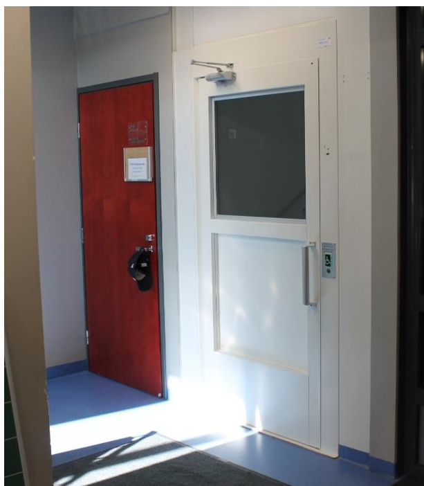
Kuva127. Ylhäällä hissien ovi sijaitsee yläkerrassa portaita vastapäätä. Hissistä joutuu peruuttamaan pois, jolloin portaat voivat aiheuttaa putoamisvaaran.
