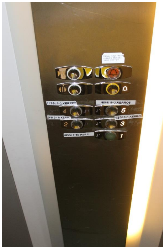
Kuva 92. Valosilmä on sijoitettu keskelle ovirakennetta. Hissin painikkeiden numerot eivät vastaa kerrosnumeroita. Painikkeiden vieressä on opastetekstit.
