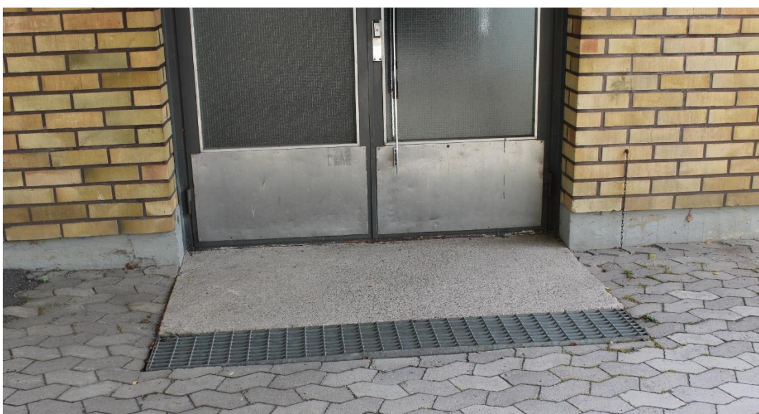
Kuva85. Ritilä on noussut toisesta reunasta terveydenhoitajan vastaanotolle johtavalla sisäänkäynnillä.
