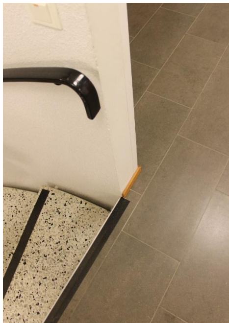
Kuvat 9. Porrasaskelmista puuttuu värikontrastina erottuvat kontrastiraidat ja toiselta puolelta käsijohde. Oikeanpuoleisessa kuvassa käsijohde ei ulotu riittävän pitkälle.
