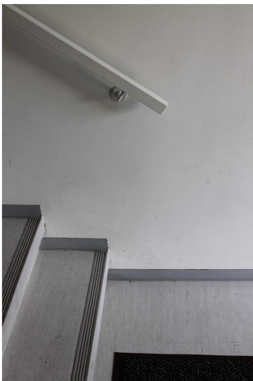
Kuva59. Käsijohteiden päitä ei ole käännetty. Käsijohde päättyy liian aikaisin ensimmäisen portaan kohdalla
