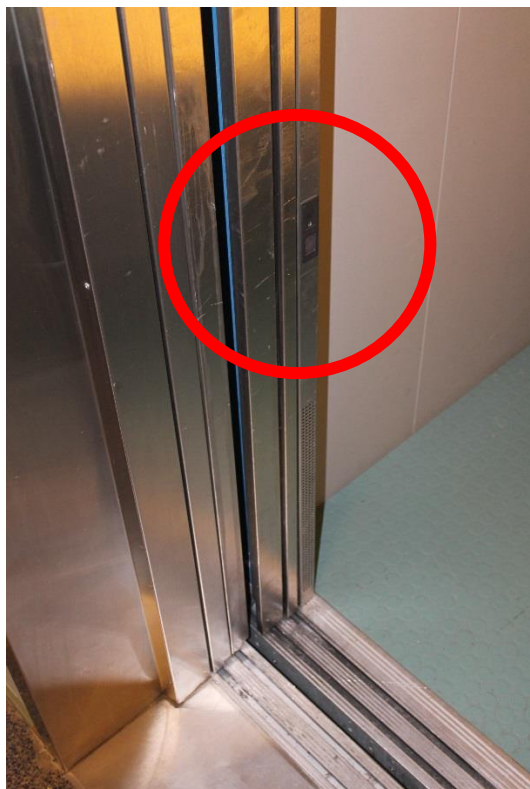
Kuva 92. Valosilmä on sijoitettu keskelle ovirakennetta. Hissin painikkeiden numerot eivät vastaa kerrosnumeroita. Painikkeiden vieressä on opastetekstit.
