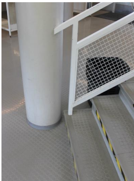
Kuva59. Käsijohteiden päitä ei ole käännetty. Käsijohde päättyy liian aikaisin ensimmäisen portaan kohdalla
