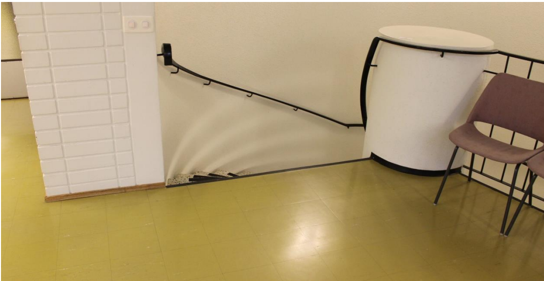
Kuva8. Portaan alkamiskohtaa ei ole merkitty kontrastina lattiaan. Portaiden hahmottaminen voi olla hankalaa (portaat eivät erotu ympäristöstä).
