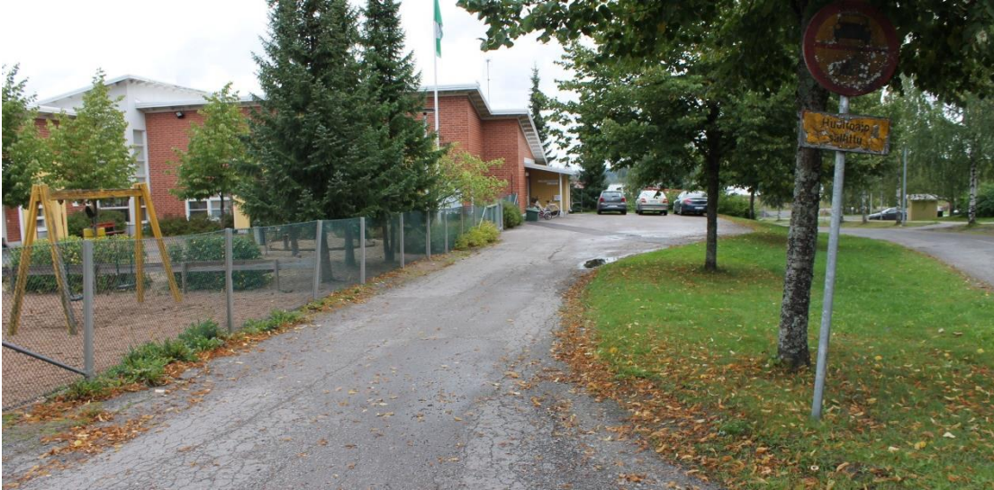
Kuva43. Sisäänkäynnille johtaa tie, jolla vain huoltoajo on sallittu. Saattoliikenteen ohjaamiseen ei ole opastetta.
