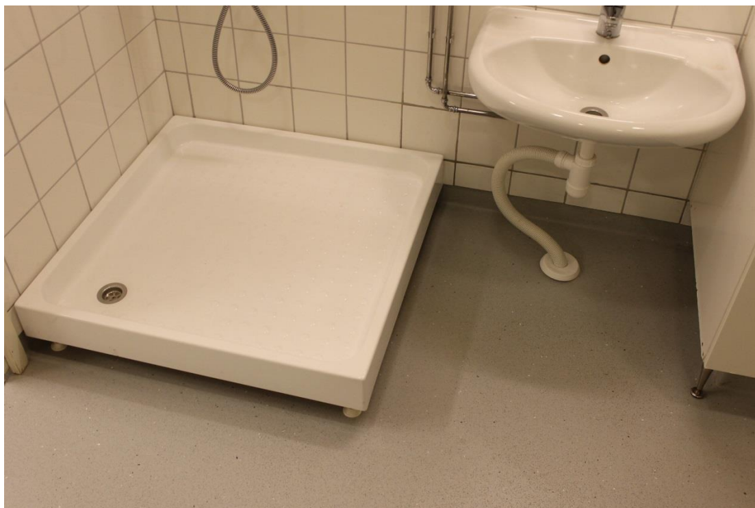
Kuva109. Suihkun alla on viemäröity koroke. Suihkun alle ei pääse pyörällisen apuvälineen kanssa.
