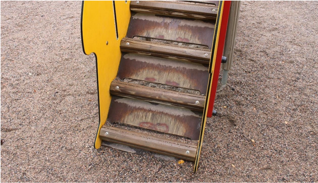
Kuva168. Liukumäen portaissa on pyöreät askelmat, jotka voivat olla talvella ja sateella liukkaat.
