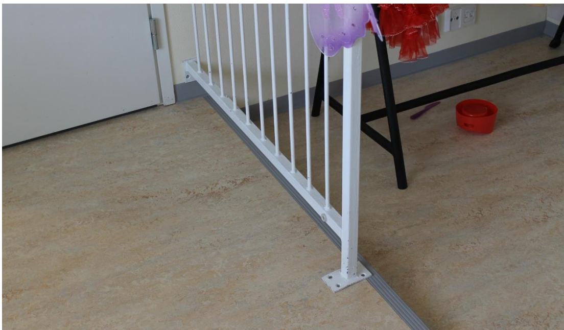
Kuva107. Tasoeron reunaan on sijoitettu kaide. Kaide tulisi ulottaa koko matkalle tasoeron reunaan.
