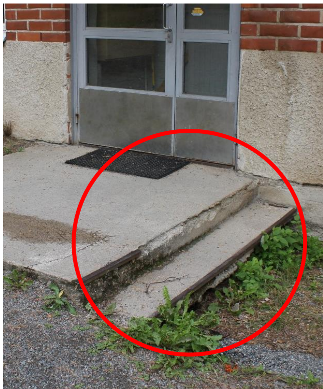
Kuva141. Sisäänkäynnin yhteydessä tasanteelta puuttuu putoamista ehkäisevä kaide. Sisääntuloau- lassa on naulakko, joka aiheuttaa törmäysvaaraa.
