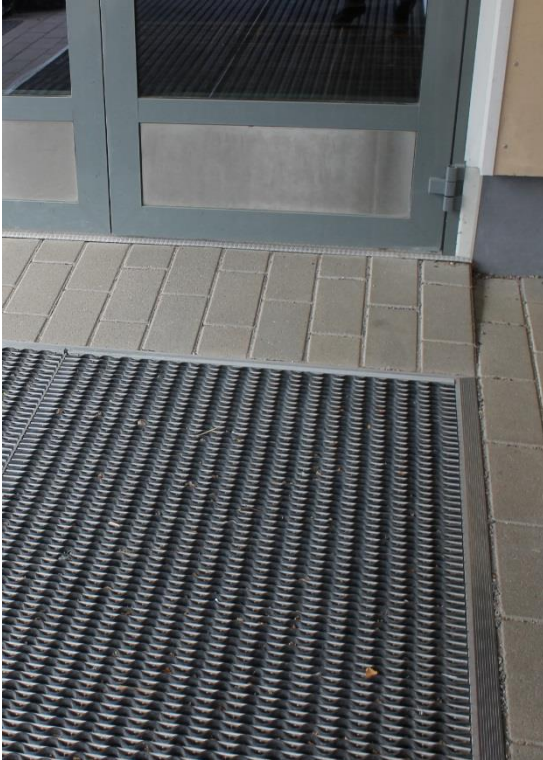
Kuva133. Ulko-oven edustalla laatoitus on luiskattu. Tuulikaapissa on lattiaan upotetut matot.
