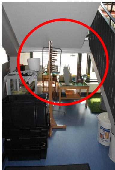
Kuva125. Portaiden alla on tila, jonne pääsee. Kulkuväylän yläpuolella portaiden rakenteiden takia korkeus ei ole riittävä. Ikkunasta muodostuu heijastusta portaisiin, mikä vaikeuttaa porraskaskelmien hahmottamista. Askelmista puuttuvat kontrastiraidat.
