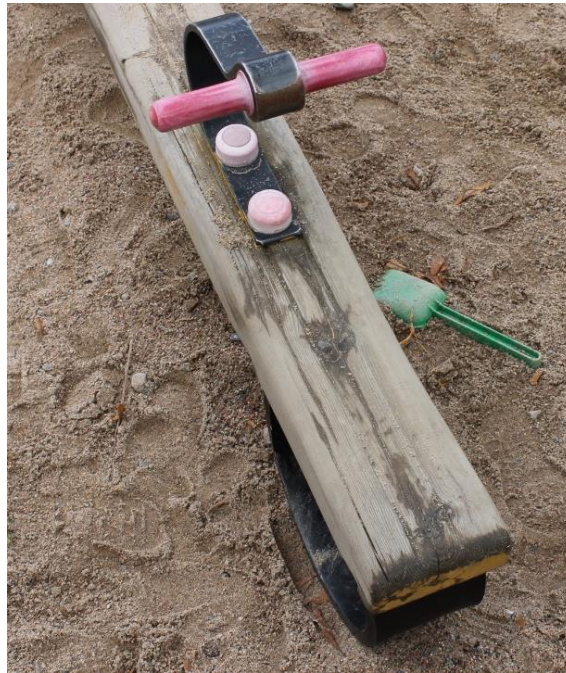
Kuva44. Muovisuoja on rikkoutunut. Keinulaudan puuosat ovat kuluneet ja niistä voi alkaa irrota tikkuja.
