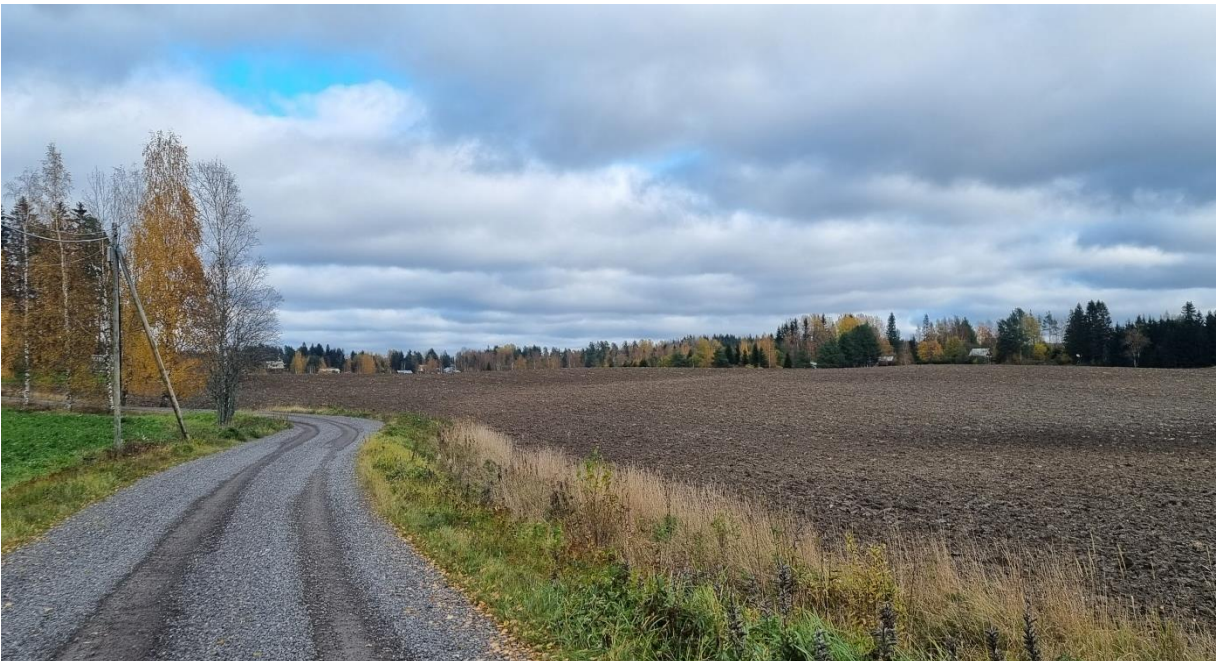
Kuva 5. Pois käytöstä jäänyt vanhan tien osuus sijoittuu peltoon Pohjantien ja Tanhuantien väliin. Vanha linjaus eroaa soratiestä mutkan kohdalla, erottuen pellostä vaaleampana linjauksena. Itään. SK.
