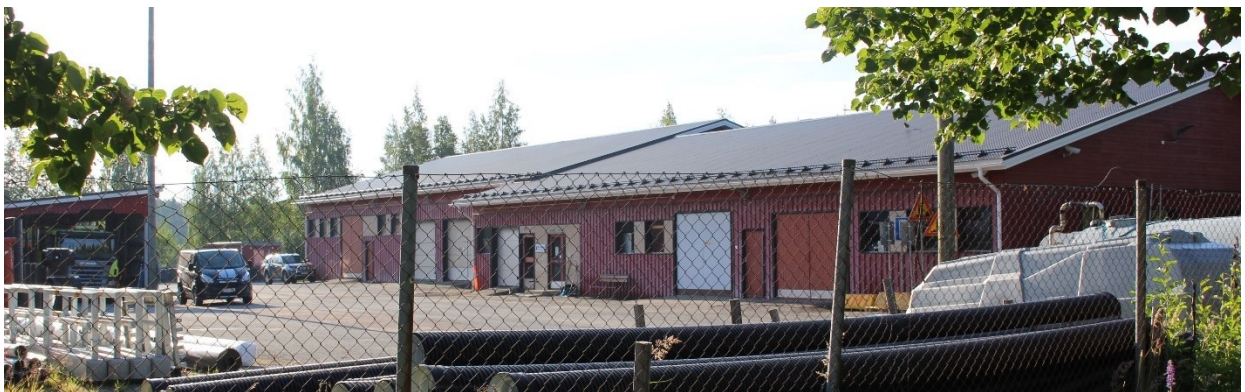
Kuva 14. Oripohjan keskivaiheilla sijaitsevaa rakennuskantaa kuvattuna heinäkuussa 2023.
