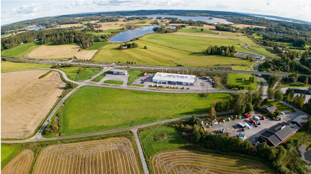
Kuva 3. Ilmaviistokuva suunnittelualan eteläosista etelään päin kuvattuna. Suunnittelualan raja- viistokuvassa horisontaalisesti kulkevan valtatie 9:n kohdilla (Pauli Noronen, 2023).
