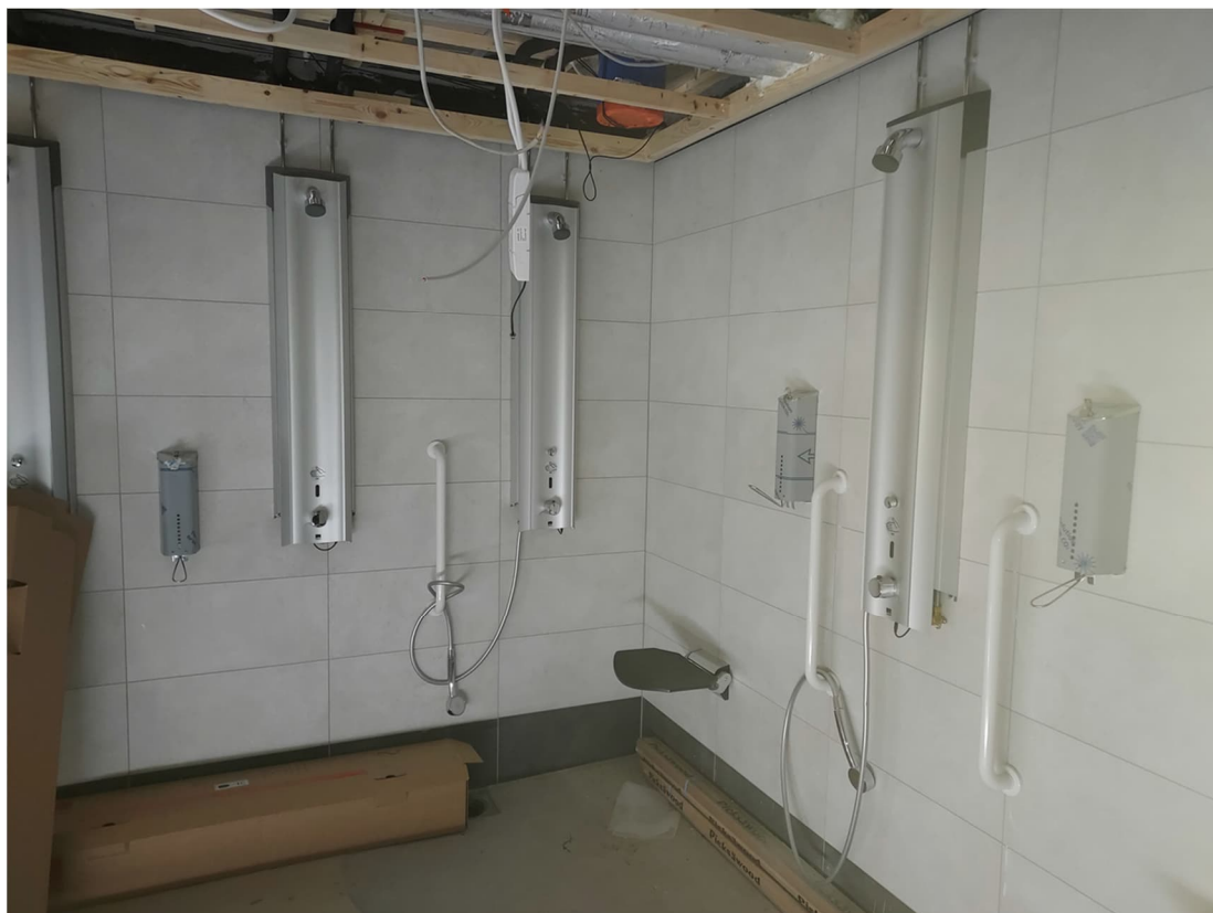
Uimahallin suihkutilat tekovaiheessa
