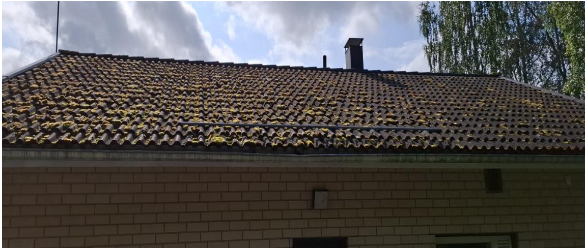
Kuva 17. Vesikatto rakennuksen takaa (metsän puolelta).
