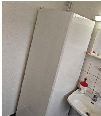
Kuva 25. Lämminvesivaraaja
