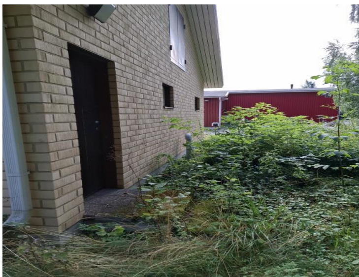
Kuva 3. Rakennuksen päädyn lähialue.
