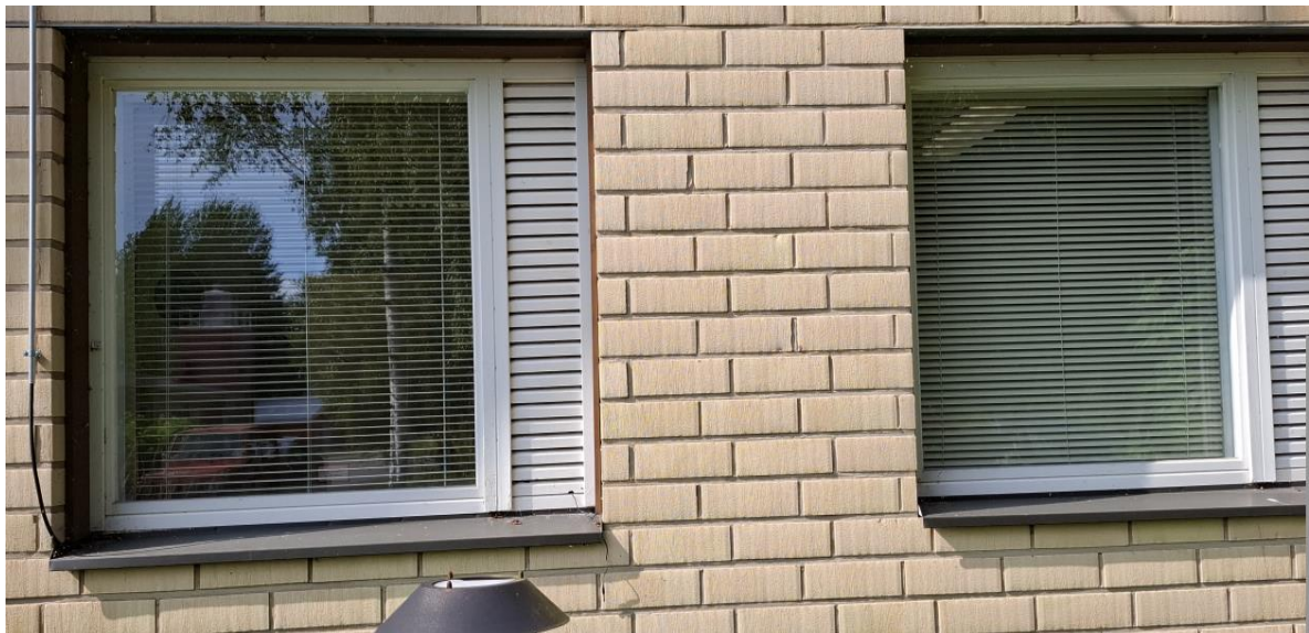
Kuvat 9 ja 10. Ulkopuitteita.
