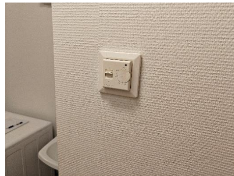
Kuva 28. Lattialämmityksen termostaatti
