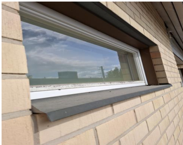
Kuvat 11 ja 12. Vesipeltien kallistus ja liityntä ulkoseinään.
