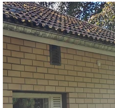
Kuva 35. Raitisilmasäleikkö
