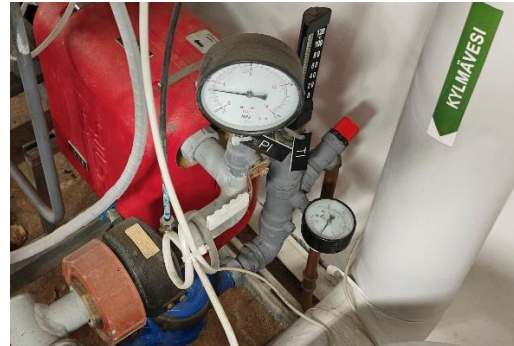
Kuva 36. Vuotava varoventtiili
