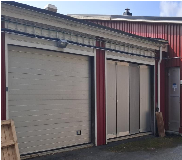
Kuva 19. Nosto-ovi ja haitariovi.
