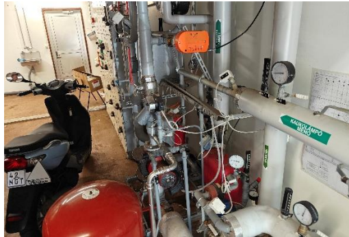
Kuva 35. Lämmönsiirrinpaketti
