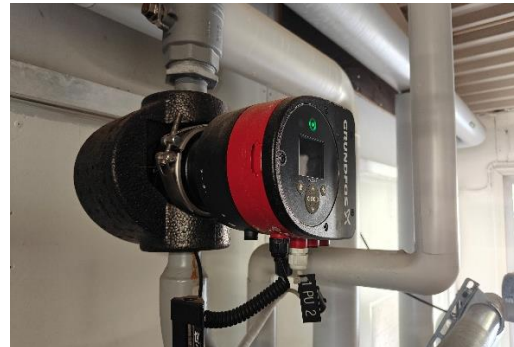
Kuva 38. Uusittu kiertovesipumppu
