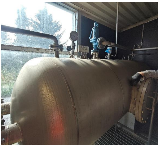
Kuva 42. dispersiovesisäiliö
