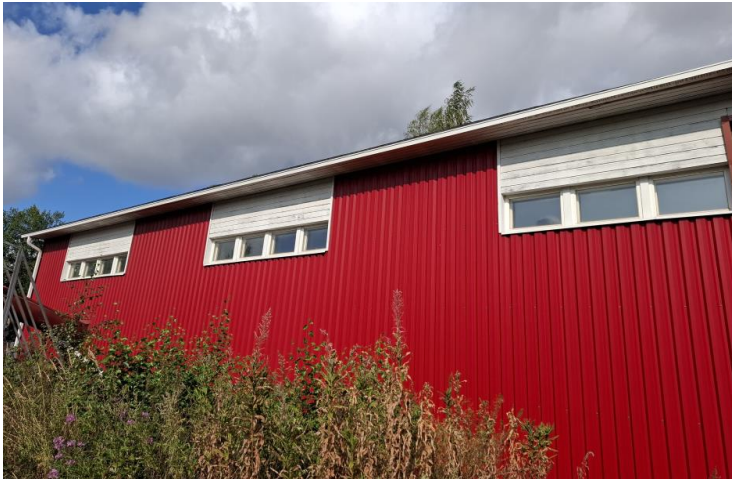
Kuva 15. Etelän puoleinen julkisivu.
