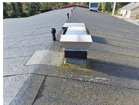
Kuva 52. huippuimureita ja TK03 raitisil-masäleikkö
