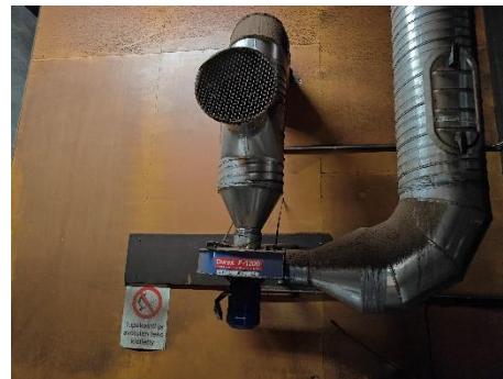
Kuva 50. Turvetilan kanavapuhallin
