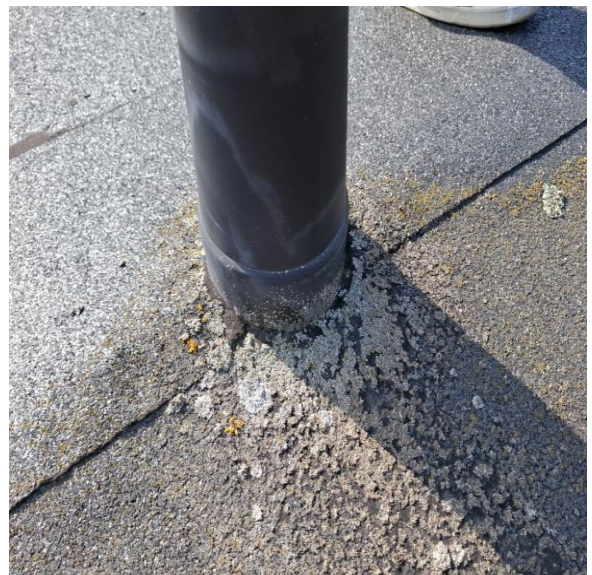
Kuva 24 ja 25. Epätiiviyttä pellin liitoksessa ja todennäköisesti alipainetuulettimen läpiviennissä.
