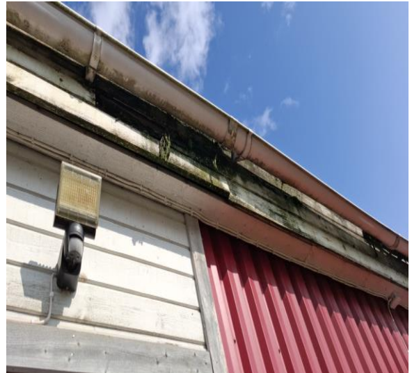
Kuvat 26 ja 27. Rakennuksen eteläpuolella sadevesikouru taipunut.
