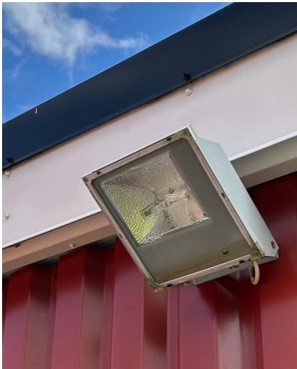
Kuva 62. Ulkovalaisimet tulisi vaihtaa LED-valoiksi.
