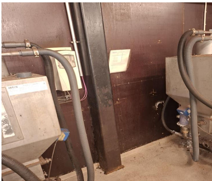
Kuva 11. Rakennuksen alkuperäisosan teräspilari.
