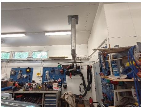
Kuva 51. Korjaamon kohdepoisto
