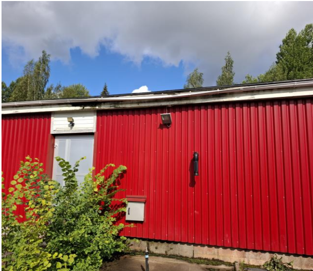
Kuvat 26 ja 27. Rakennuksen eteläpuolella sadevesikouru taipunut.
