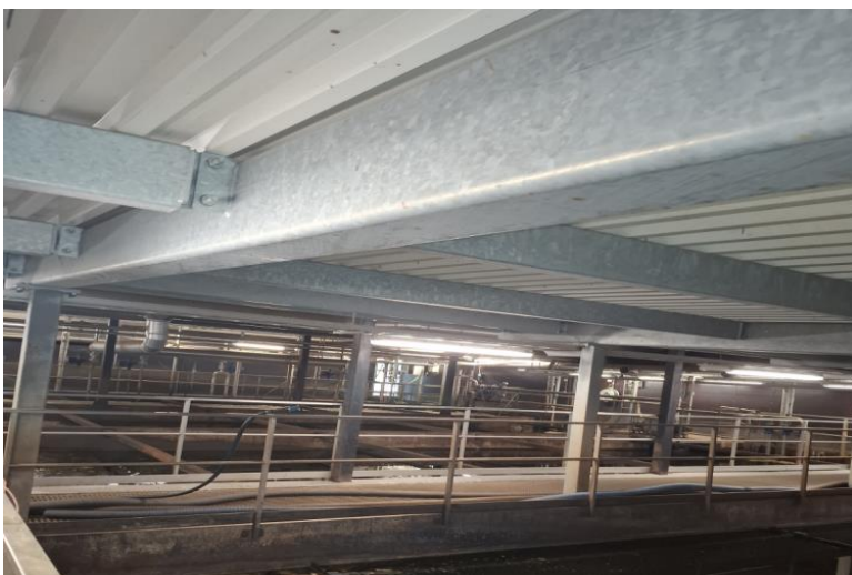
Kuva 14. Laajennusosan teräsrunkoa.
