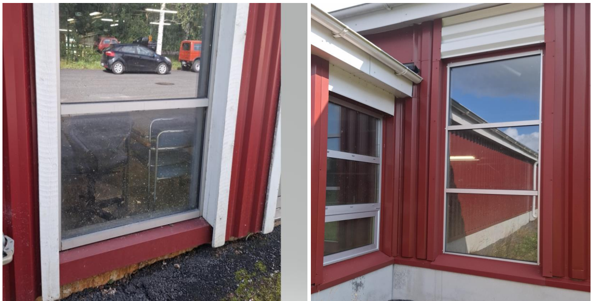
Kuvat 17 ja 18. Yleiskuvat umpiolasi-ikkunoista.
