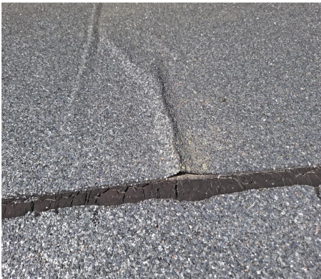
Kuva 23. Halkeilua bitumimassassa.
