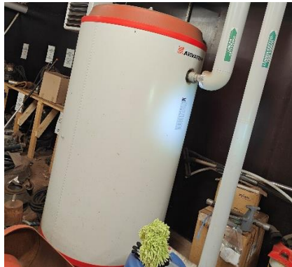
Kuva 37. lämminvesivaraaja
