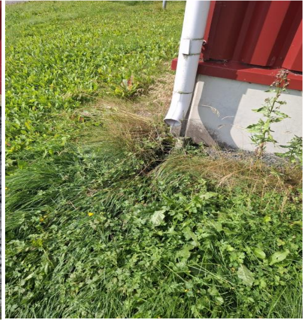
Kuvat 8 ja 9. Rännikaivot ja betonikourut tulee kunnostaa/puhdistaa.
