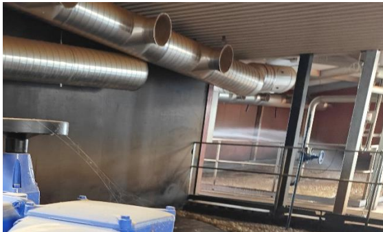
Kuva 56. Poistoilman imukartioita
