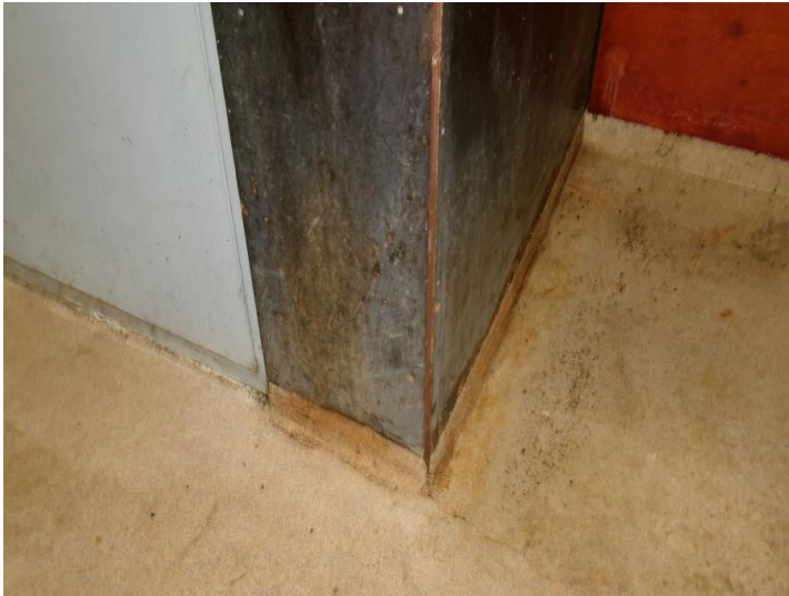
Kuva 31. Yleiskuva lattian akryylimassajalkalistasta.
