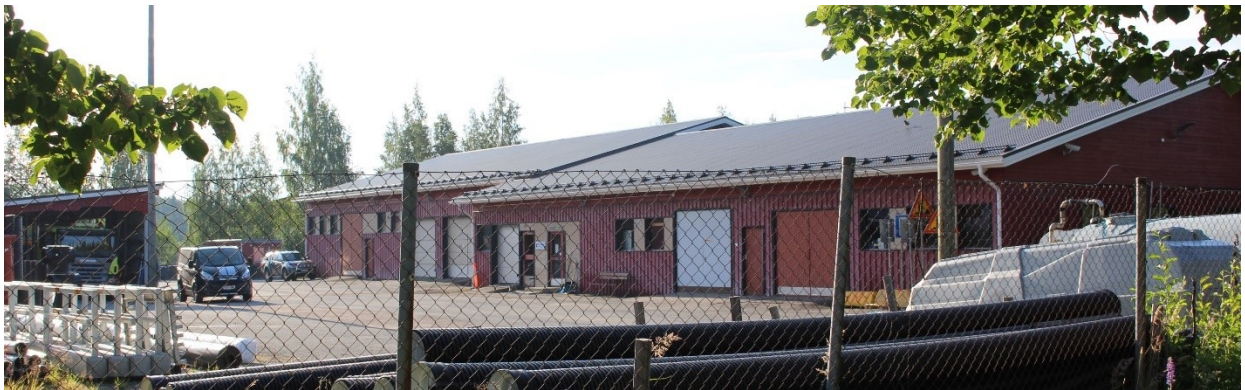
Kuva 14. Oripohjan keskivaiheilla sijaitsevaa rakennuskantaa kuvattuna heinäkuussa 2023.
