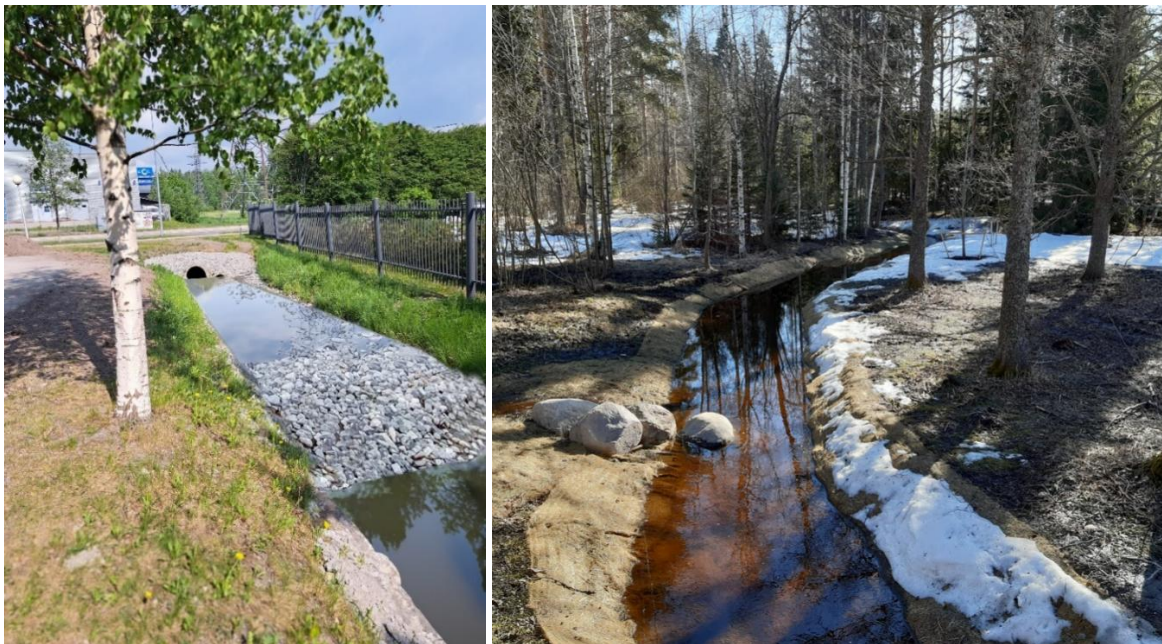
Kuva 18. Vasemmalla havainnollistus ojan yhteyteen toteutetusta väliaikaisesta suotopadosta kiintoaineiden poistamiseksi työmaavesistä. Oikealla eroosiosuojakankaalla suojattu oja. © Destia Oy 2024.
