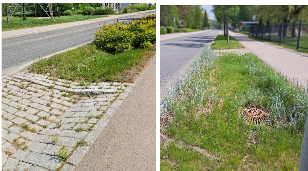
Kuva 15 A ja B. Esimerkki kadun viherkaistalle toteutetusta biosuodatusrakenteesta. Kuvat © Destia Oy.
