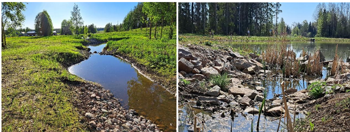
Kuva 14 A ja B. Esimerkkikuvia hulevesien viivytysaltaista. Kuvat © Destia Oy.
