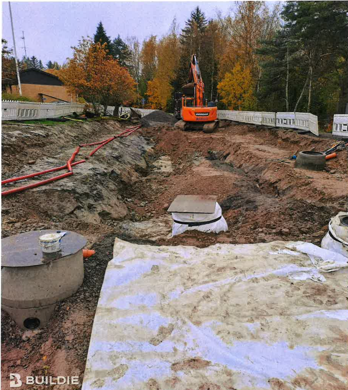
Kuva: Oripohjantien saneeraus ja kevyen liikenteen väylän rakentaminen
